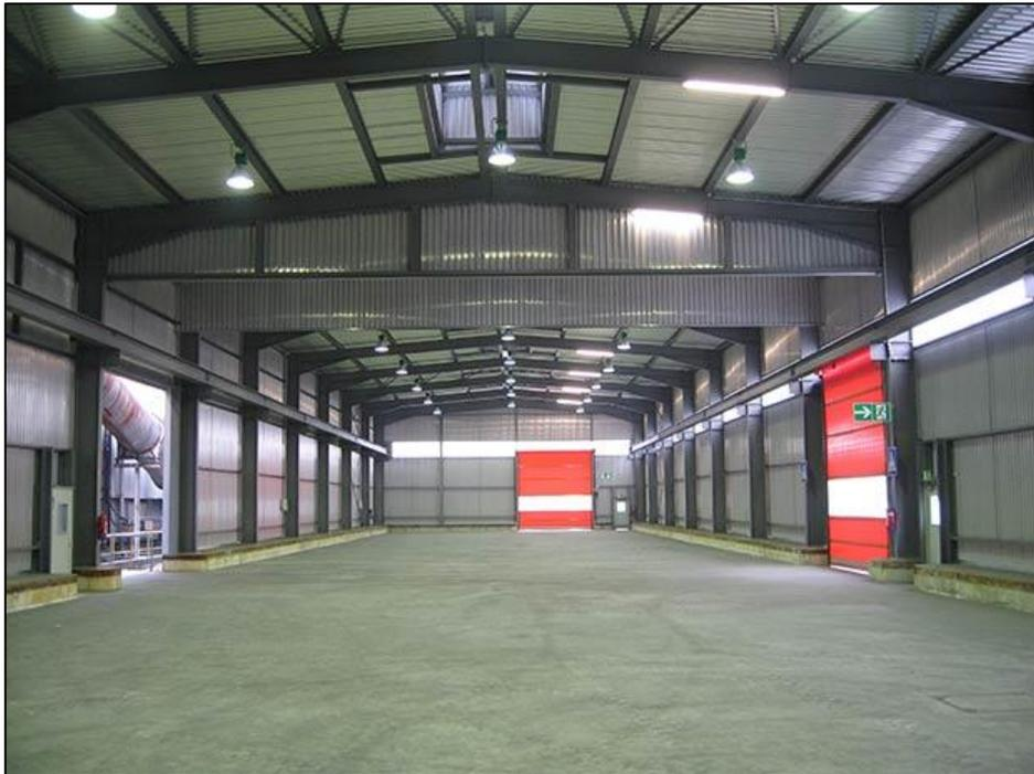
**Abb.1:** Rahmenkonstruktion [8]
