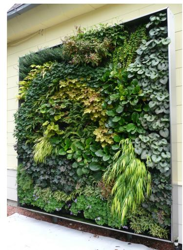
Abbildung 11: Matten-Begrünungssystem (links: kurz nach der Installation) [41]
