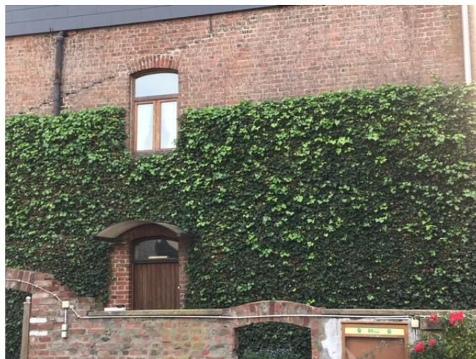
Abbildung 4: Bodengebundene Fassadenbegrünung mit Efeu in der Nähe von Aachen, Deutschland
