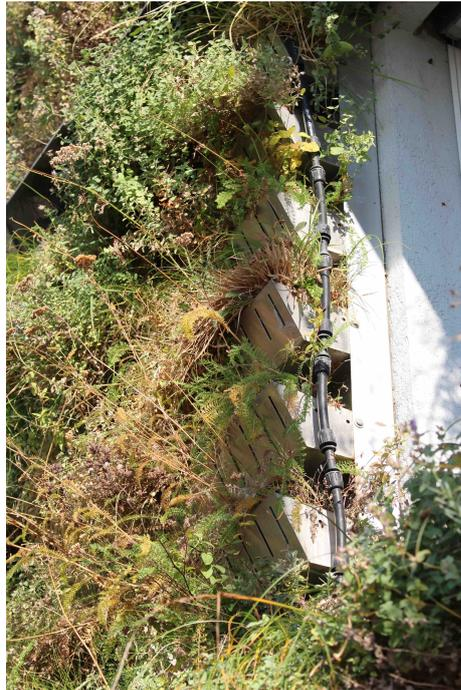
Abbildung 9: Bewässerungssystem des trogebundenen Begrünungssystems am Gebäude der MA 48 im 5. Bezirk, November 2017
