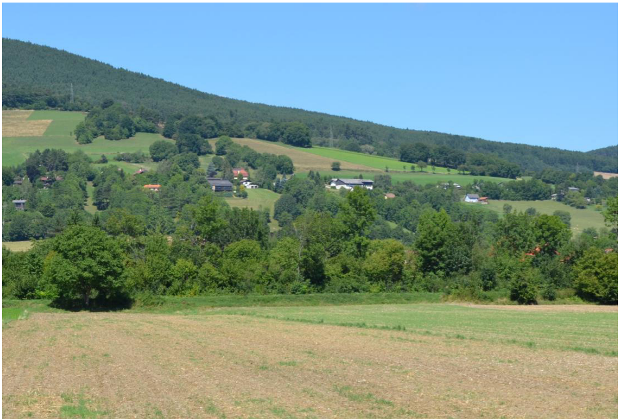
Abbildung 30: Erhebung Gloggnitz (1) (August 2017) (Südansicht des gegenständlichen Bereichs) (Die Darstellung reicht von Geb S21 (linker Bildrand) bis GEB S13 (rechter Bildrand), dabei sind aufgrund der Baum- und Strauchbestände im gegenständlichen Bereich nicht alle der erhaltenswerten Gebäude sichtbar) Quelle: Eigene Erhebung, eigene Darstellung
