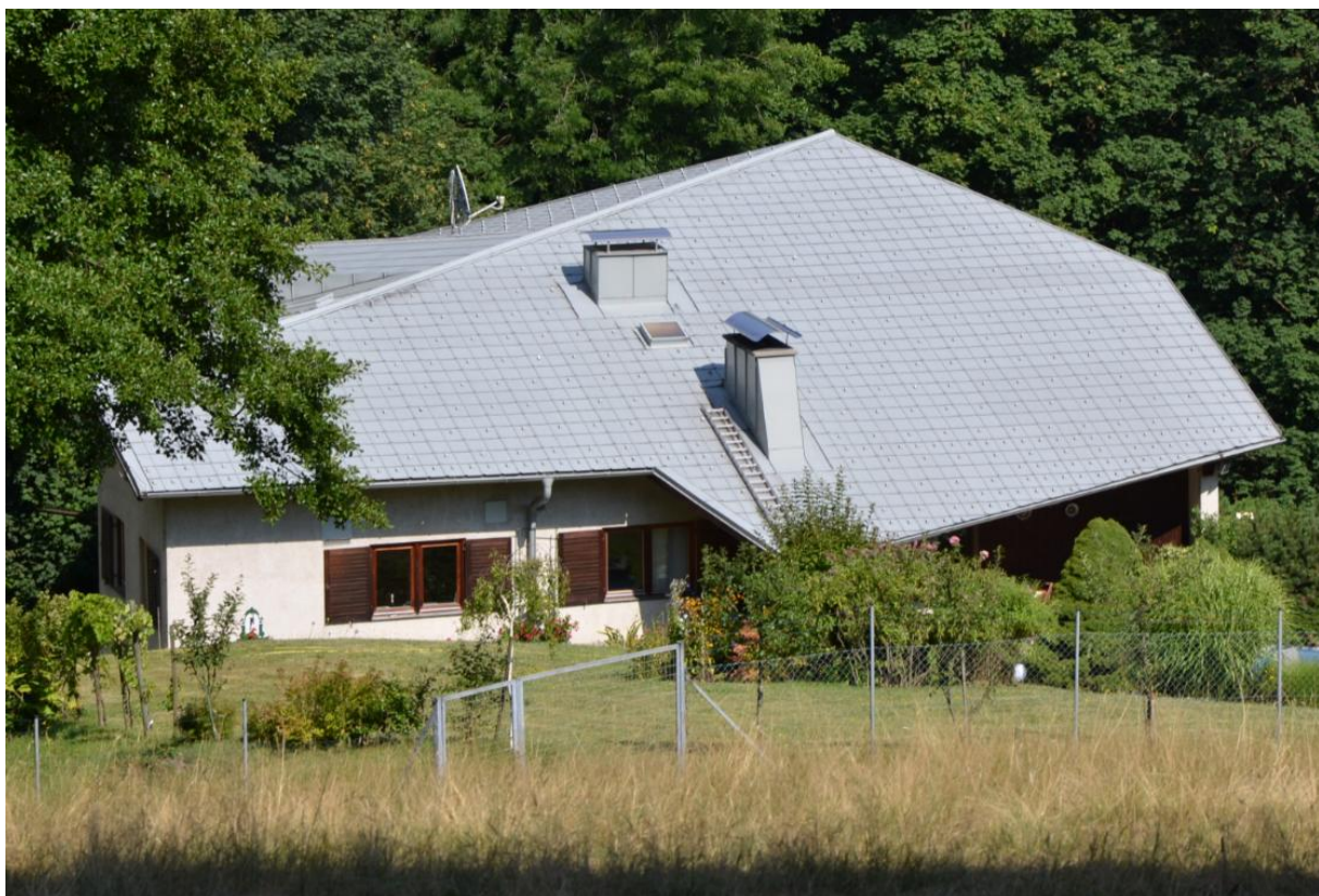
Abbildung 40: Erhebung Mauerbach (Juli 2017) (Erhaltenswertes Gebäude zentral) Quelle: Eigene Erhebung, eigene Darstellung
