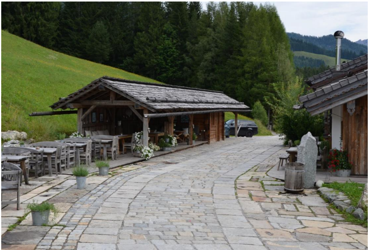
Abbildung 90: Erhebung Leogang (Juli 2017) (Neuerrichtetes Nebengebäude zentral) Quelle: Eigene Erhebung, eigene Darstellung
