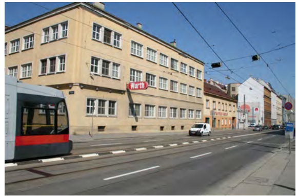
Abb. 23: Grst. 1476 Leerstand Gewerbe Firma Würth Essenzenfabrik.
