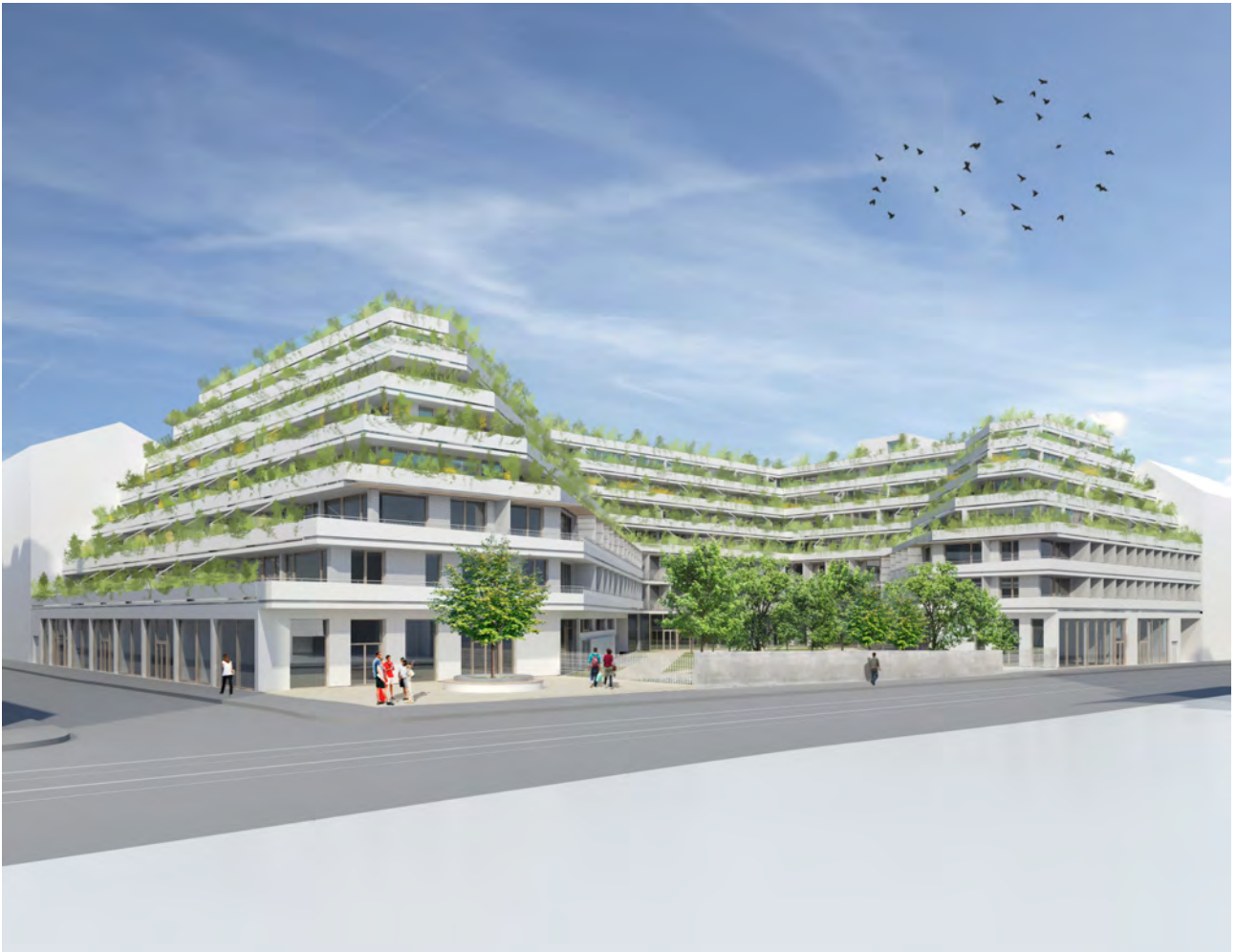
Abb. 81: Blick in den zentralen Innenhof.
