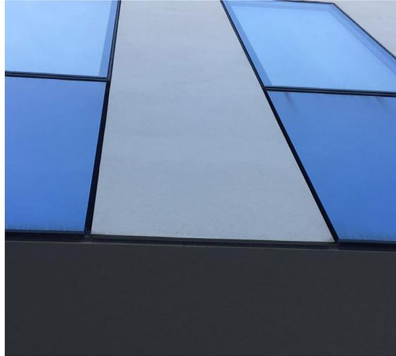
Abb.164. Beispiel - Putzträgerplatte - Fixverglasung
