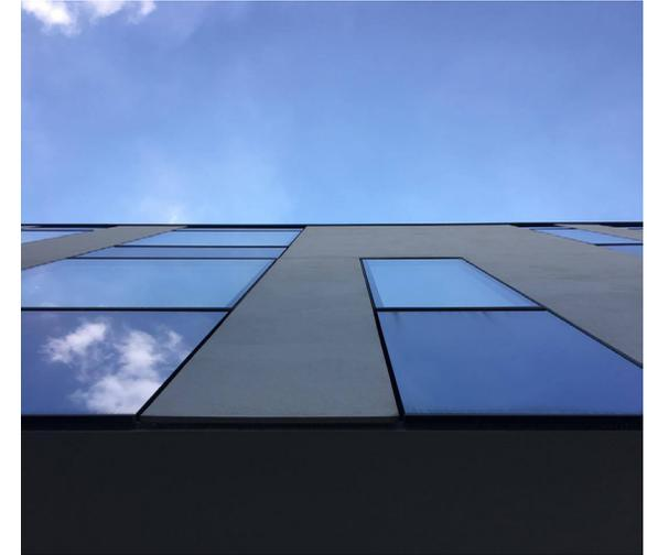
Abb.165. Beispiel - Putzträgerplatte - Fixverglasung
