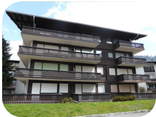
Abbildung 41: Zweitwohnsitzgebäude in Saalbach-Hinterglemm mit geschlossenen Rollläden
