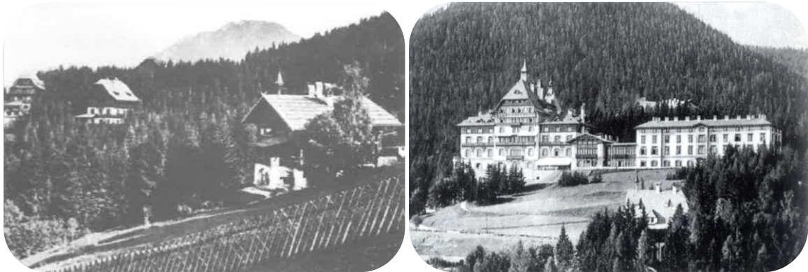
Abbildungen 109 und 110: Villenkolonie um 1900 (Quelle: Vasko, 75 Jahre Kurgemeinde Semmering, S. 10); das erste Hotel am Semmering – Südbahnhof 1903 (Quelle: Pap 1996, S. 70)
