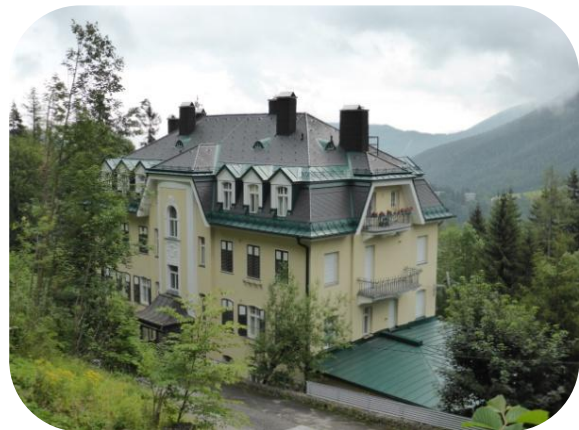
Abbildung 44: Nutzung vorhandener Bausubstanz für Zweitwohnsitze am Semmering
