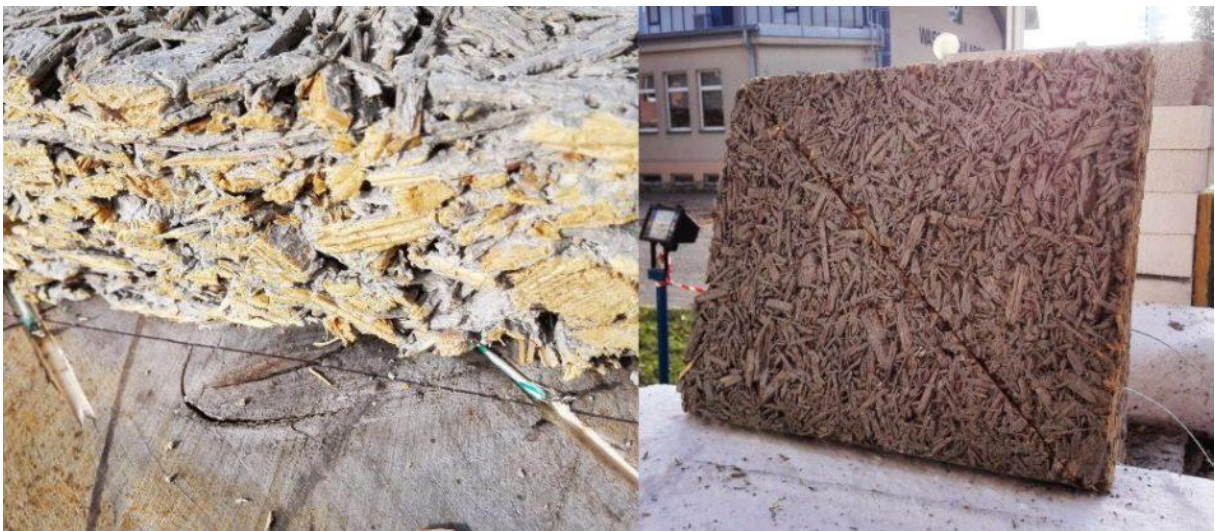
Abbildung 53: Thermoelemente unterhalb der der Verkleidung (links), diagonale Fuge in der Verkleidung des Probekörpers (rechts)
