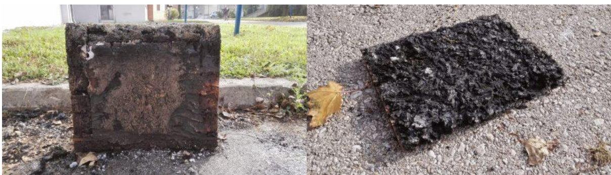
Abbildung 61: Kleberrückstände und verkohlte Holzleichtbetonplatte am Ende einer Brandbeanspruchungsdauer von 90 Minuten
