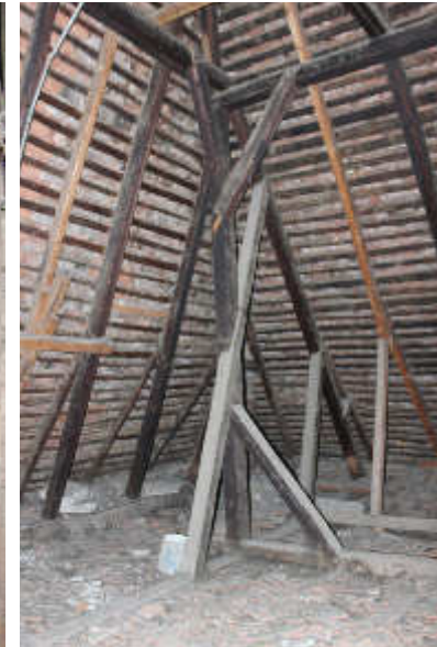
Abb. 102 (links) | Straßenseitige Dachkonstruktion mit integrierter Fledermausgaube
