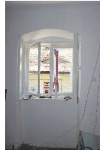
Abb. 86 | zweiflügeliges Doppelfenster
