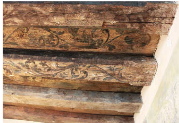
Abb. 172 (links) | Sichtbare Balken mit einem Mittel- tram
