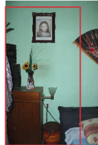
Abb. 90 | Umriss des ehemali- gen Türrahmens
