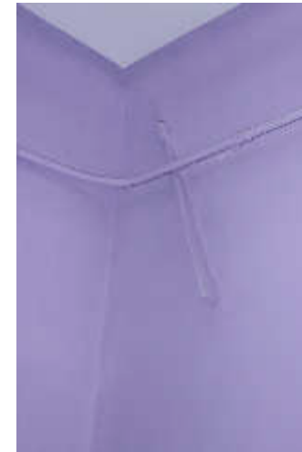
Abb. 142 | Metallaussteifung an der Wand
