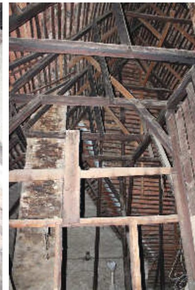
Abb. 104 (links) | Sparrenstreben mit- tels Blattstoß und Holznagel an dem Kehlbalken befestigt
