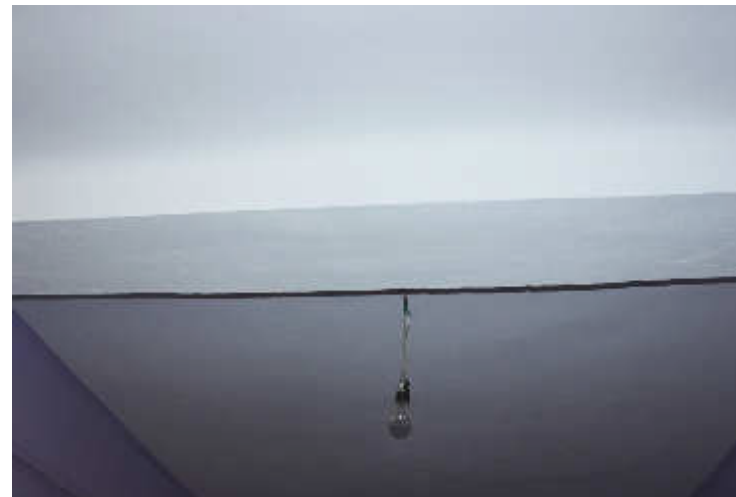
Abb. 143 | Mit Farbfassung be- deckter Mitteltram
