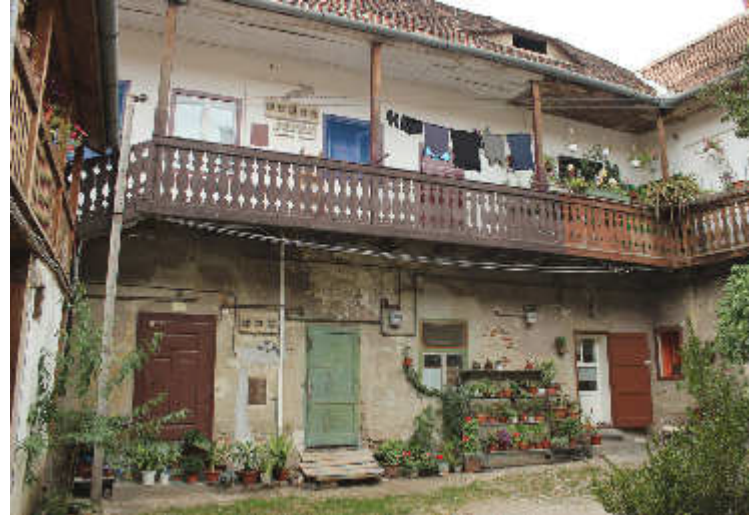
Abb. 36 (links) | Süd-westliche Hoffassade mit der Arkadenloggia
