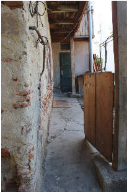
Abb. 154 (links) | Stark deformierte Wandoberfläche im Außenbereich des Raumes A109
