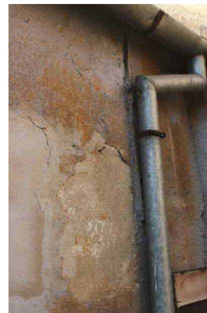
Abb. 166 (links) | Blick auf den Trakt C
