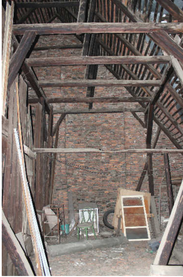
Abb. 185 | Der Dachstuhl des Haupttraktes A
