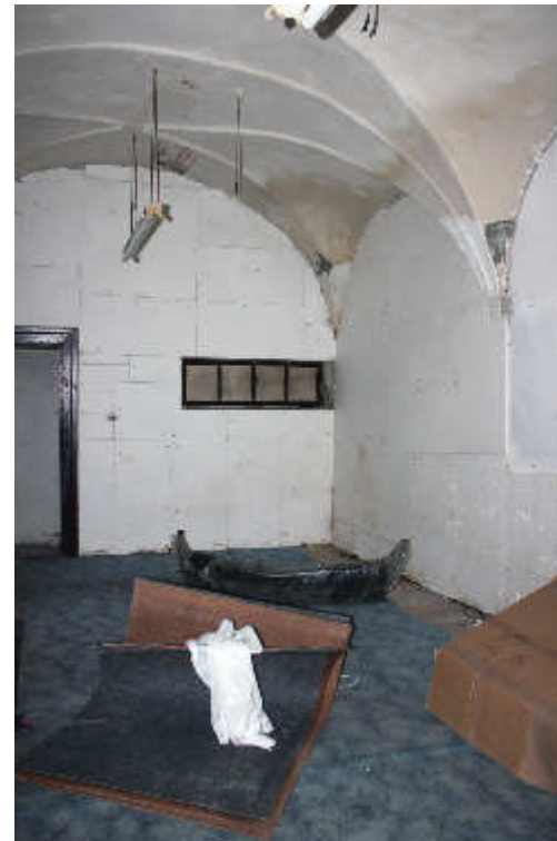
Abb. 175 (links) | Ein Teil des mittelalterlichen Kern des Gebäudes | Trakt A
