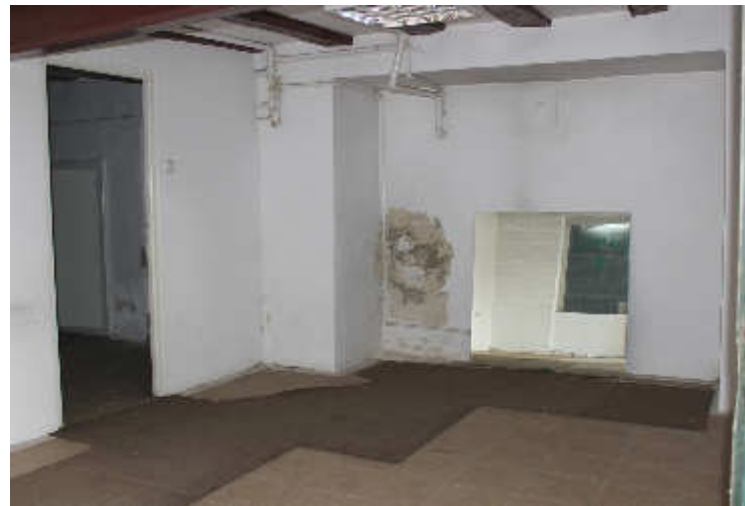
Abb. 43 | Trennwand aus dem 20. Jh.
