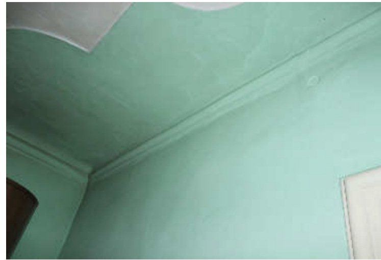
Abb. 91 | Stuckbordüre rund um die Wände
