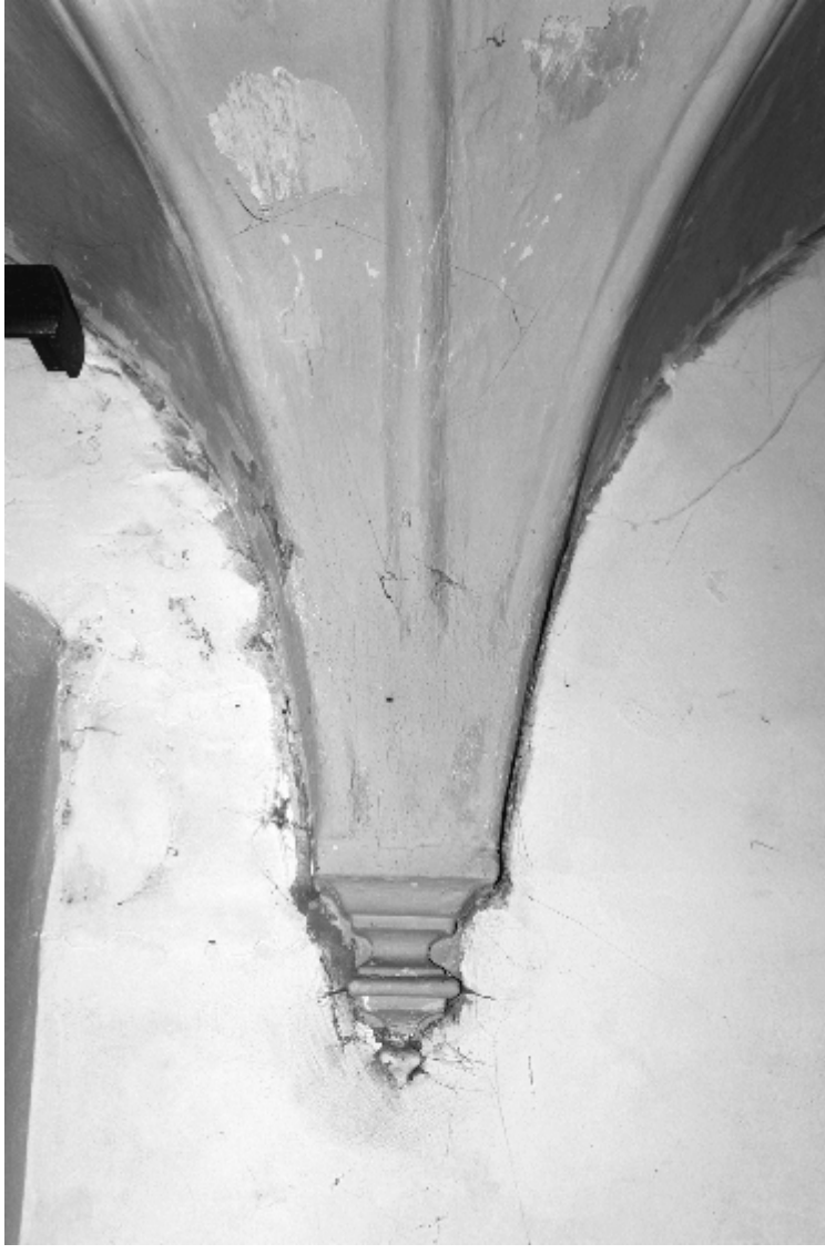
Abb. 174 | Dekorative Rippen und Konsolen eines Kreuzgewölbes | Trakt A
