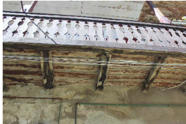
Abb. 179 | Unterkonstruktion der Pawlatschen des Wirtshauses
