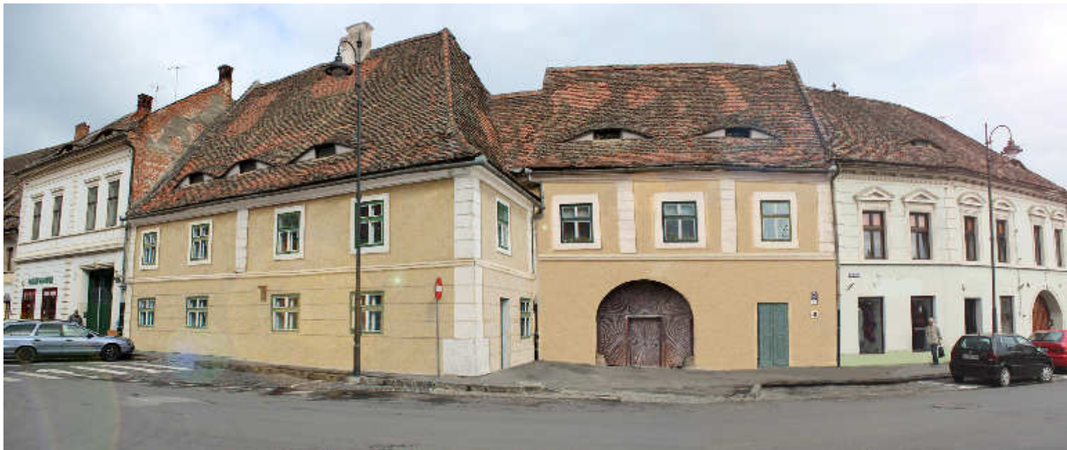
Abb. 204 | Sanierung der Hauptfassade
