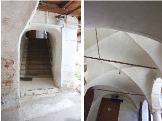
Abb. 34 (rechts) | Kreuzgewölbte Decke der Loggia
