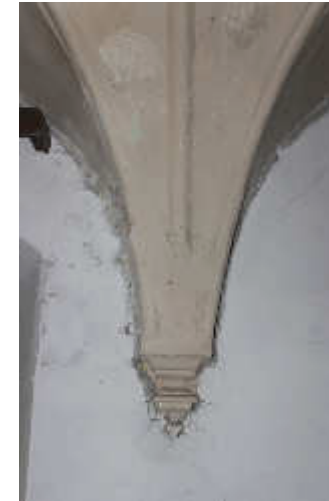
Abb. 48 (links) | kreuzgewölbte Decke
