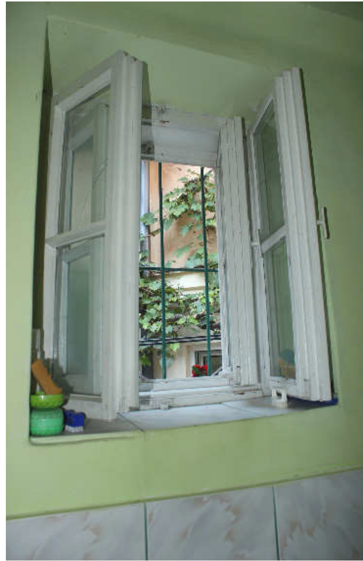
Abb. 146 | Fenster im Sanitär- raum
