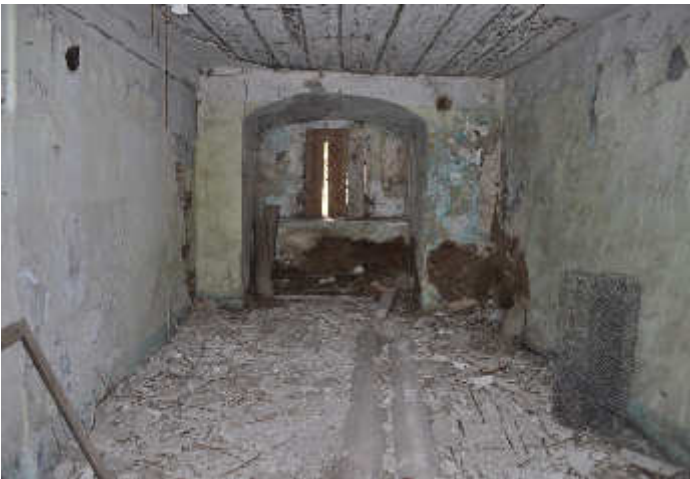
Abb.110. Außenmauer mit Fensteröffnung, Wand a
