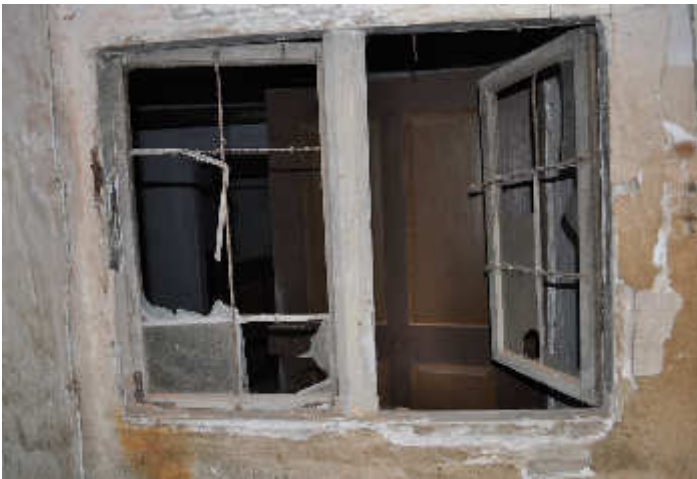
Abb.108. Fensteröffnung, Wand c
