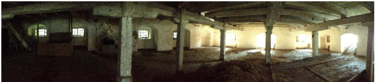
Abb.117. Panoramablick erstes Speichergeschoss
