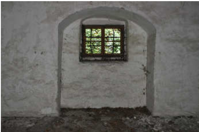
Abb.62. Mauerborgen vor dem Fenster
