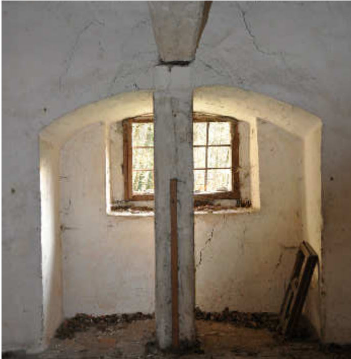
Abb.67. Stütze vor dem Fenster
