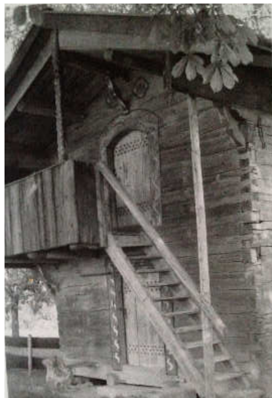
Abb.33. Speicher aus Holz
