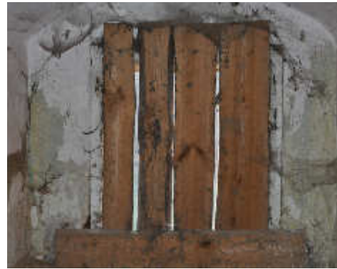
Abb.72. Ansicht Fenster mit bündigem Rahmenstock
