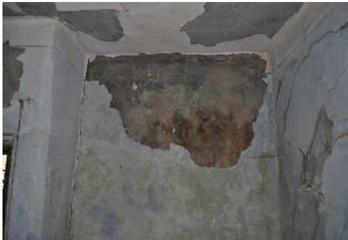
Abb.102. Außenmauer, Wand a
