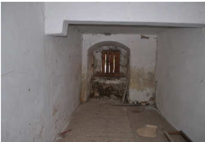
Abb.82. Außenmauer mit Fensteröffnung, Wand b
