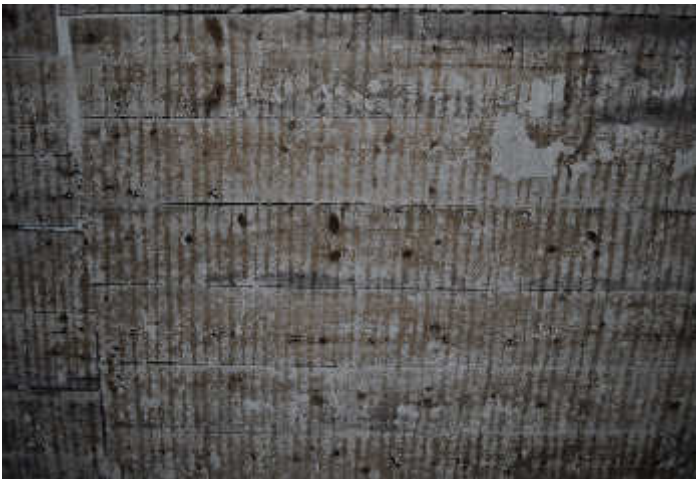
Abb.115. Decke ohne Putzaufbau
