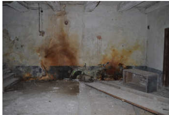
Abb.93. Außenmauer, Wand d.b
