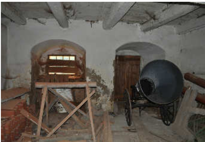
Abb.86. Außenmauer mit Fenster- und Türöffnung, Wand b
