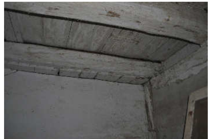
Abb.87. Erkennbare Verkleidung der Decke von Raum 3, Wand a
