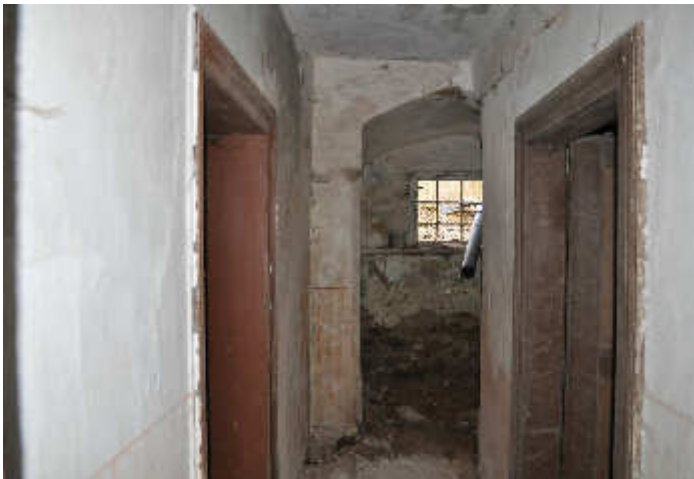
Abb.106. Außenmauer a mit Fensteröffnung, Türöffnungen Wand b/d
