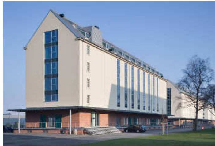
Abb.44. Silospeicher nach dem Umbau
