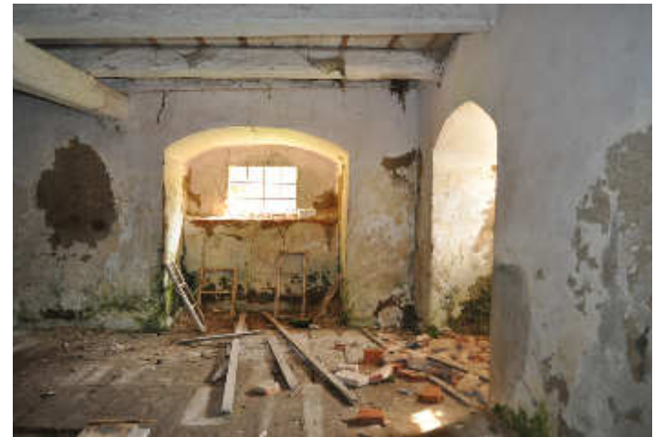
Abb.90. Außenmauer mit Fensteröffnung, Wand c
