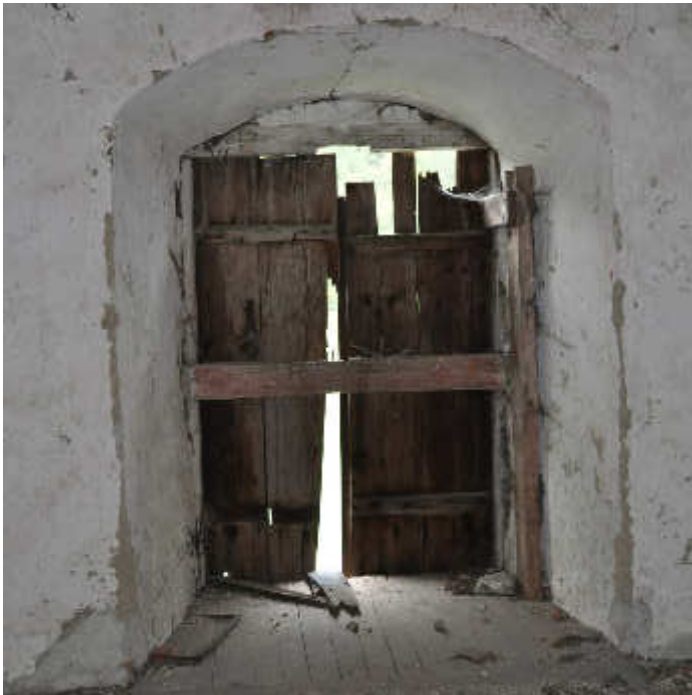
Abb.123. Türe, Wand b
