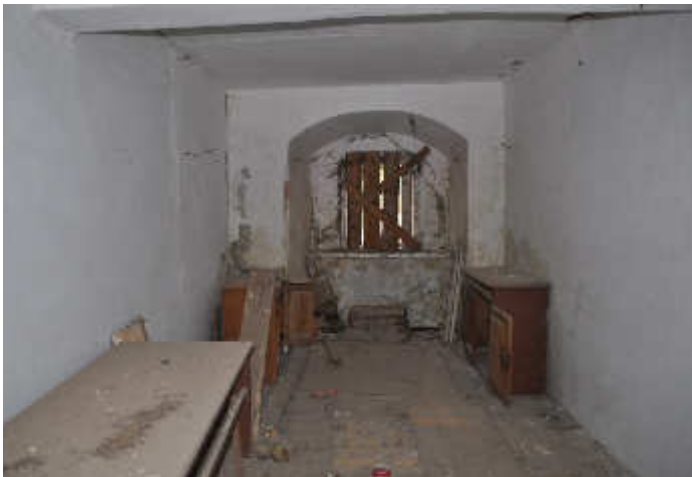
Abb. 78. Außenmauer mit Fensteröffnung, Wand b
