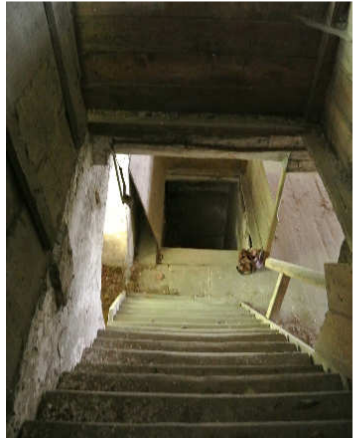
Abb.149. Treppe 2.OG in 1.OG
