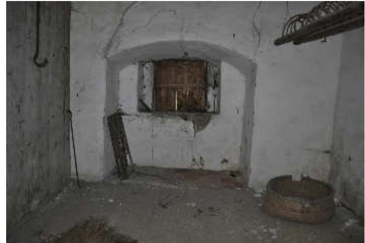
Abb.120. Wand a im abgetrennten Raum
