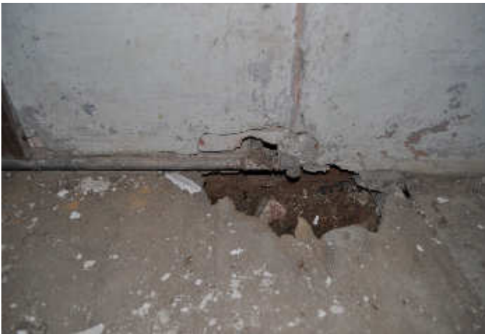
Abb.96. Wasserleitung, Wand a.a
