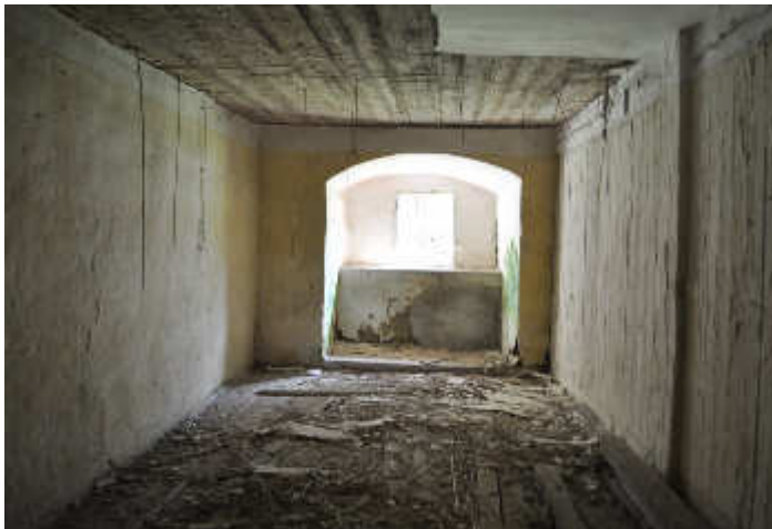
Abb.113. Außenmauer mit Fensteröffnung, Wand c
