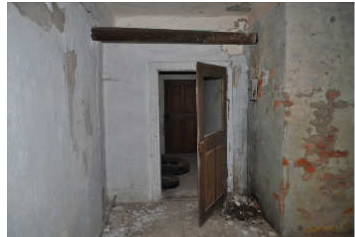
Abb.103. Eingang Raum 9, Wand c
