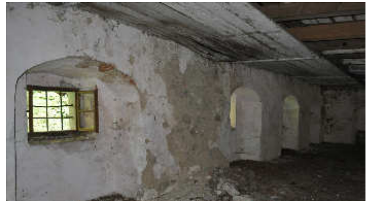
Abb.145. Holzverkleidung der Decke im 2.OG
