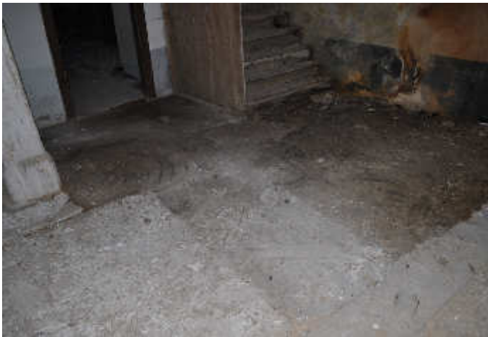
Abb.94. Betonierte Bodenfläche vor der Treppe
