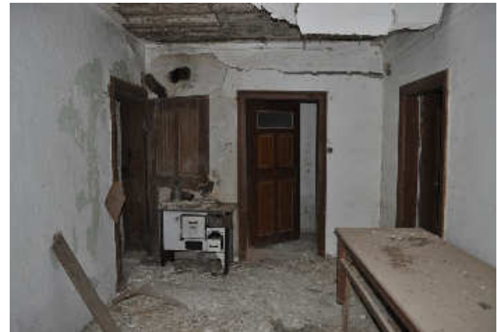
Abb.79. Eingänge Raum 2, Wand a/c/d
