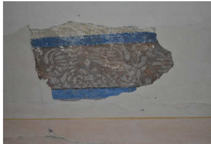
Abb.77. Unterschiedlich erkennbare Farbschichten der Decke
