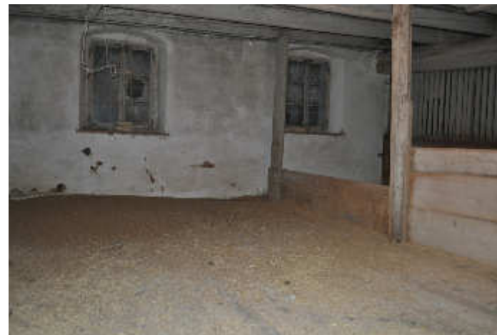
Abb.15. Schüttbodyen in einem alten Bauernhaus in Oberösterreich
