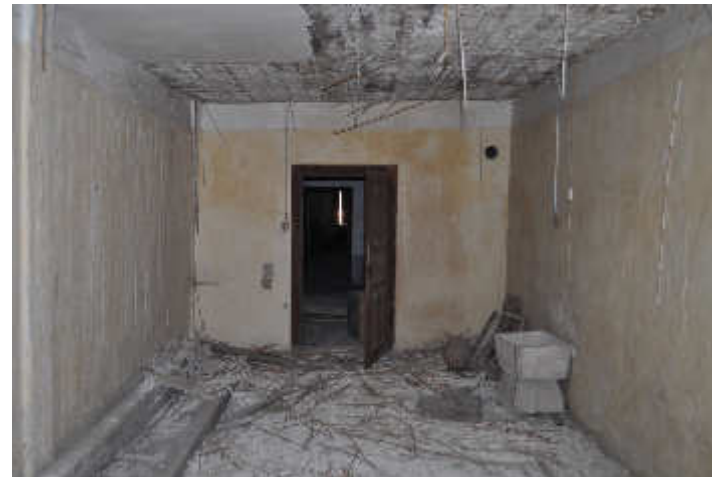
Abb.114. Eingang Raum 12, Wand a
