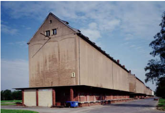
Abb.43. Silospeicher vor dem Umbau
