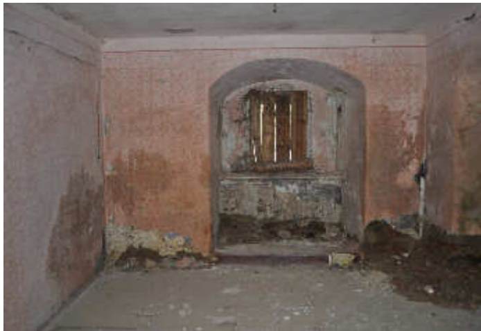
Abb.74. Außenmauer mit Fensteröffnung, Wand b
