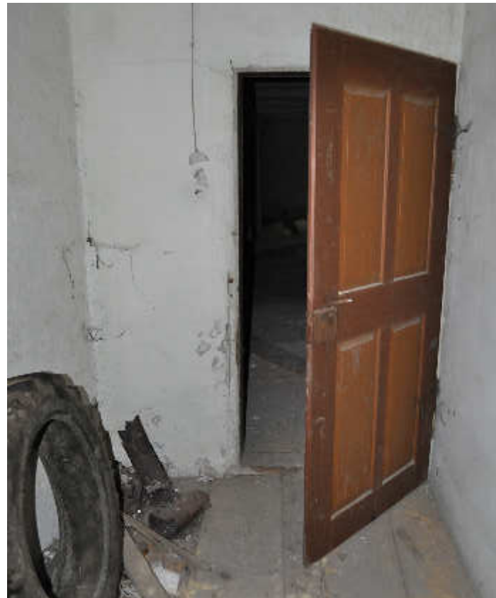
Abb.101. Eingang Raum 8, Wand c
