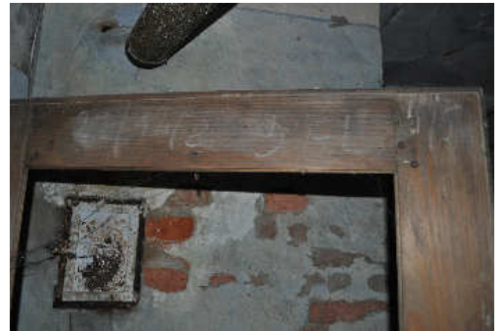
Abb.99. Tür mit Beschriftung, Wand a
