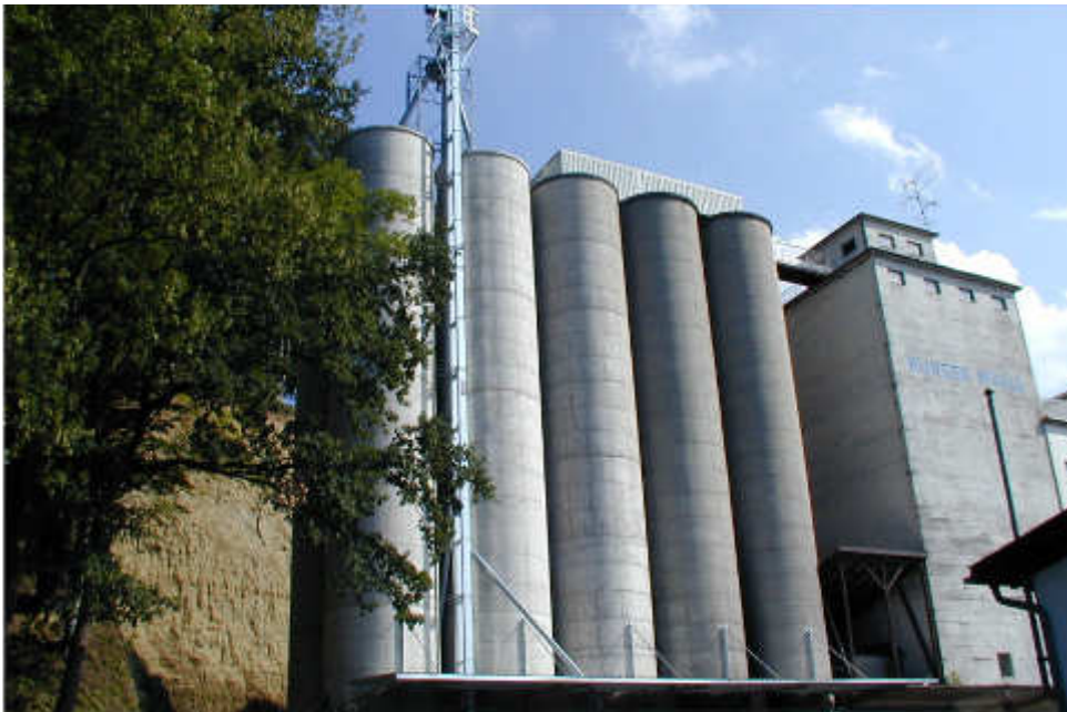
Abb.17. Getreidesilo aus Beton in Gaspoltshofen
