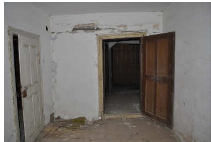
Abb.83. Eingänge Raum 3, Wand a/d
