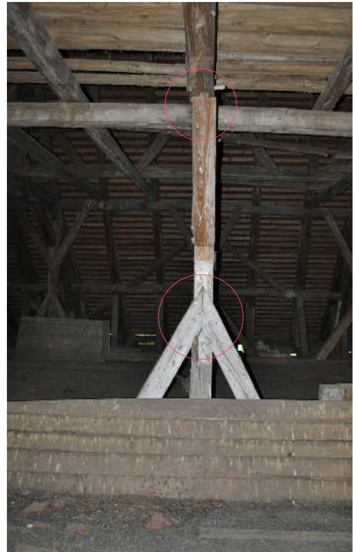
Abb.131. Unten: Verblattung; Oben: Zapfen
