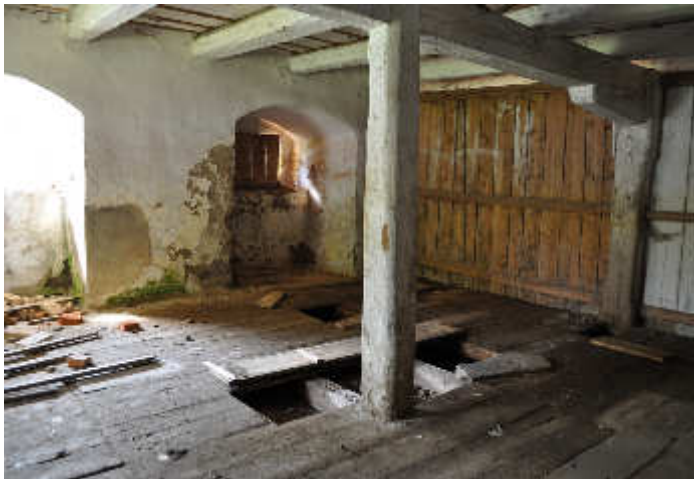
Abb.89. Außenmauer b mit Fensteröffnung & Holzwand a
