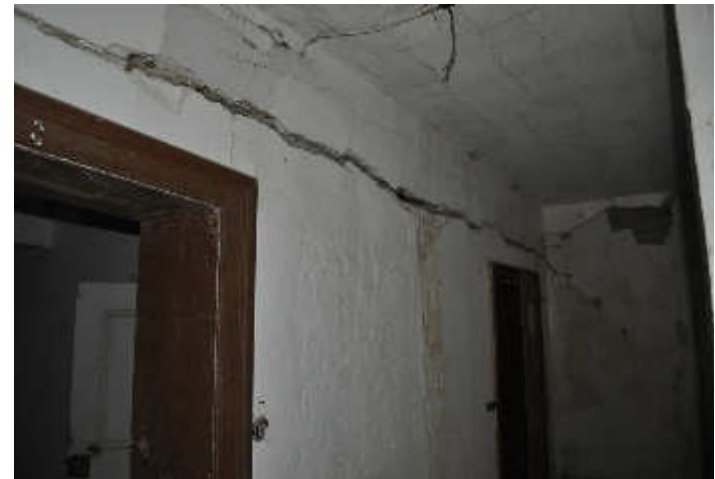
Abb.95. Zwischenmauer mit zwei Türöffnungen, Wand b.a
