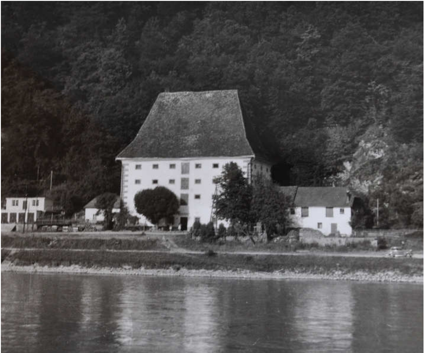
Abb.13. Blick von der Donau auf den Getreidespeicher Obermühl
