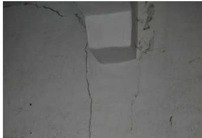
Abb.85. In die Wand eingemauerte Stütze, Wand c
