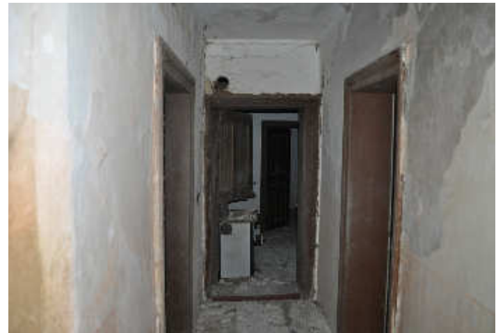
Abb.107. Eingänge Raum 9, Wand b/c/d
