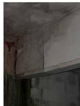
Abb. 4.24: Durchbiegung und Riss im Träger
