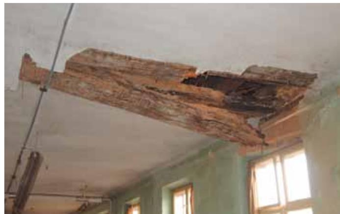
Abb. 4.3: Durchbruch der Doppelbaumdecke
