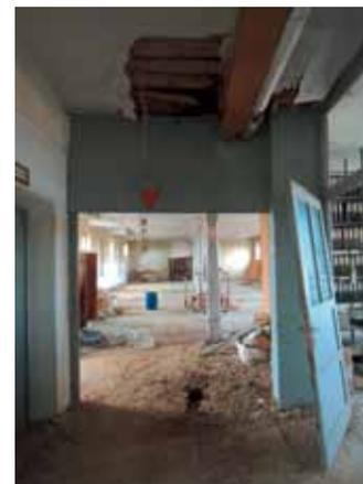
Abb. 4.10: Durchbruch der Doppelbaumdecke im 2. Obergeschoß
