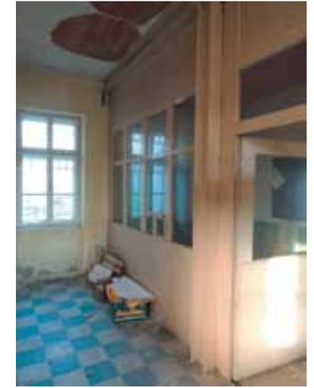
Abb. 3.40 (rechts): Abgebrochene Putzstellen offenbaren Flachziegeldecke
