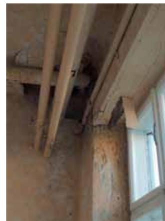
Abb. 4.14: Durchfeuchtung des Mauerwerkes im 2. Obergeschoß
