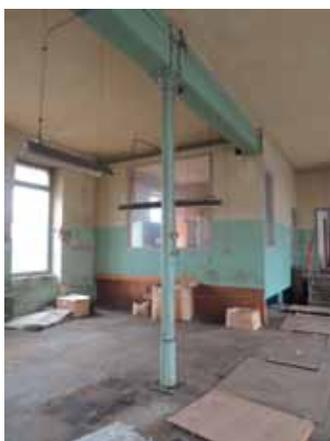
Abb. 3.17 (links): Runde Stahlstütze im Erdgeschoß des Friedhofstraktes mit Kapitell
