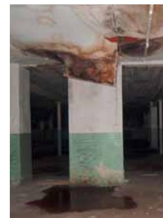
Abb. 4.37: Feuchteschaden an der Decke im Erdgeschoß
