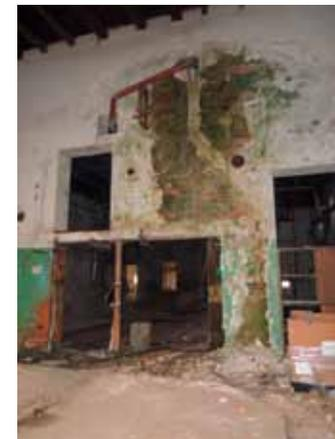
Abb. 4.43: Durchfeuchtete Zwischenwand, schadhafte Innenentwässerung
