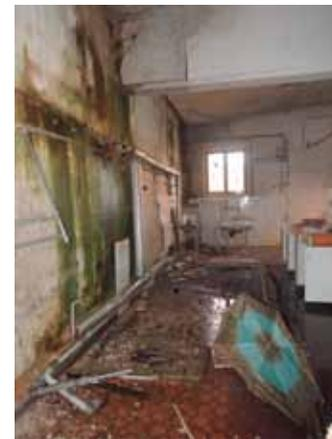
Abb. 4.20: Durchfeuchtete Ziegelwand
