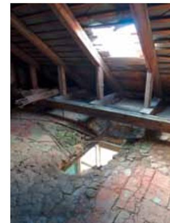
Abb. 4.4: Loch in der Dachdeckung
