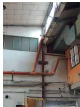
Abb. 4.35: Innenentwässerung an der Seite zu Shed II
