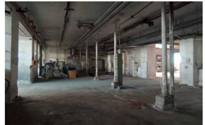
Abb. 3.44: Erdgeschoß Nordtrakt, Unterzug aus Holz und runde Stahlstützen
