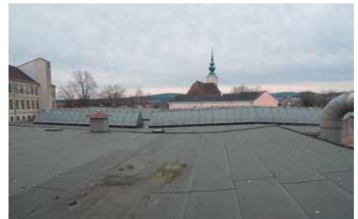
Abb. 3.69: Oberlichtbänder auf dem Dach
