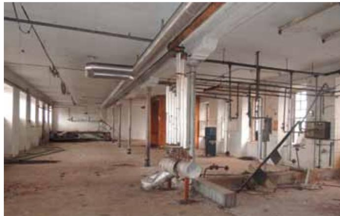
Abb. 3.47: 1. Obergeschoß des Nordtraktes, für einen Zubau erhöhte Parapete auf der linken Seite
