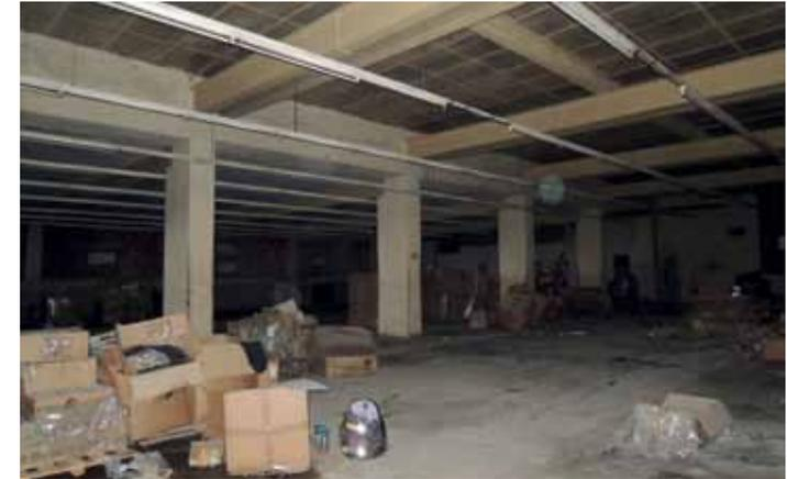
Abb. 3.80: Obergeschoß, Eingriff in statisches System des Friedhofstraktes bei Zubau zur Nutzung der gesamten Raumtiefe, unterschiedliche Raumhöhen des Bereichs unter Friedhofstrakt und Zubau
