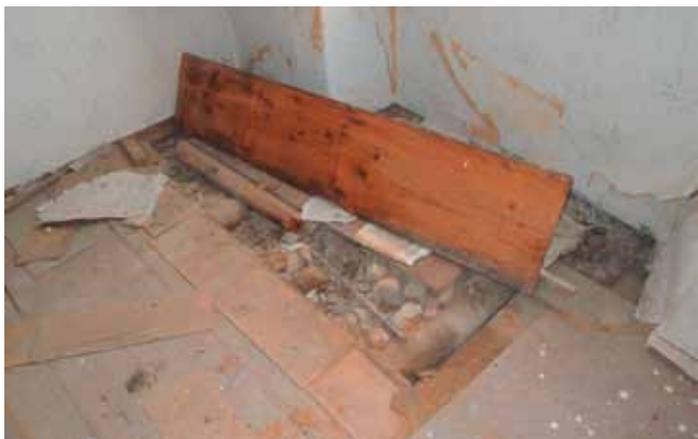
Abb. 3.16: Bodenöffnung zur Feststellung einer Dippelbaumdecke
