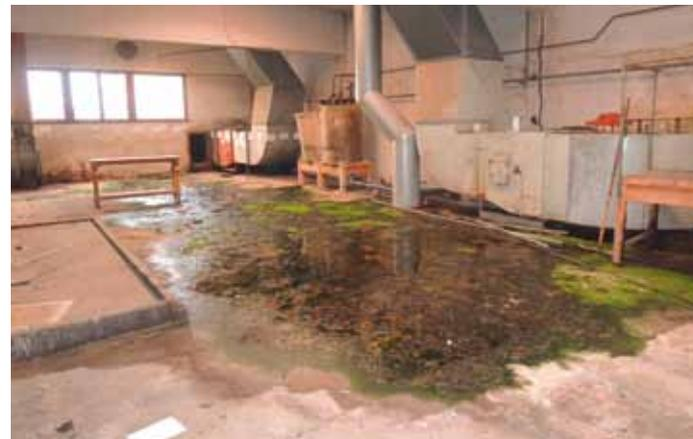
Abb. 4.26: Stehende Wasserlacken auf der Stahlbetondecke im 1. Obergeschoß
