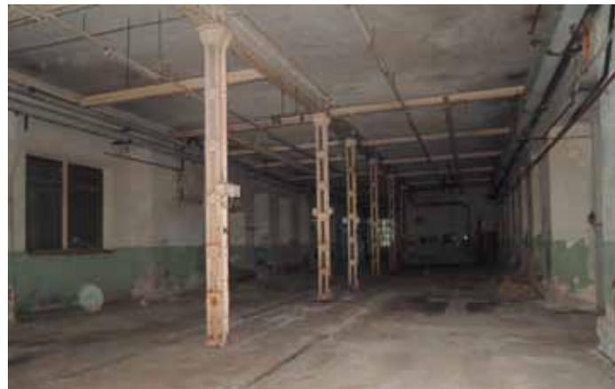
Abb. 3.43: Erdgeschoß Westtrakt, I-Träger als Unterzug und Stahlstützen aus C-Profilen
