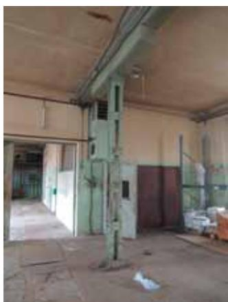
Abb. 3.18 (rechts): Stahlstütze aus C-Profilen in einem Teil des Erdgeschoßes im Friedhofstrakt
