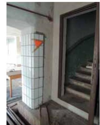
Abb. 3.51 (rechts): Zugang der Stiege zum 2. Obergeschoß, Rohrleitungen durch die Erschließungsfläche vor der Stiege behindern die Zugänglichkeit
