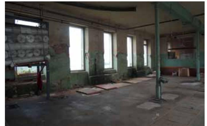
Abb. 4.48: Aufsteigende Feuchtigkeit an der Außenwand im Friedhofstrakt
