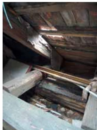
Abb. 4.13: Loch in der Dachdeckung
