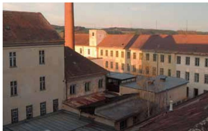
Abb. 2.1: Die niedrigere Höhe des Gebäudeteils in Verlängerung des nördlichen Traktes deutet möglicherweise auf die ursprüngliche Gebäudehöhe vor der Aufstockung hin.
