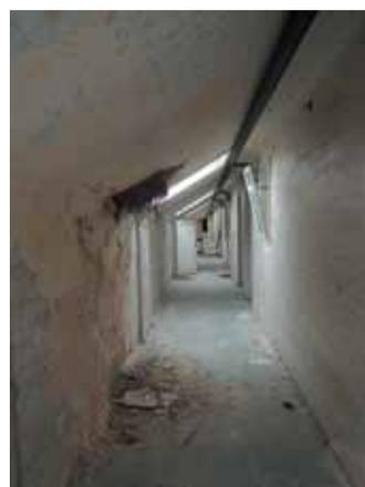
Abb. 4.16: Durchbruch durch Feuchteschaden an der Innenverkleidung
