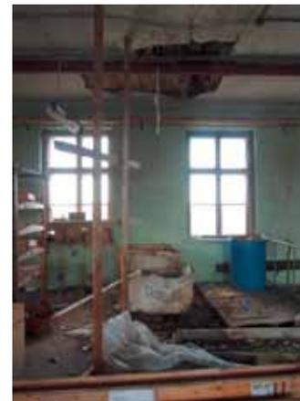
Abb. 4.7: Durchbruch der Doppelbaumdecke im 2. Obergeschoß
