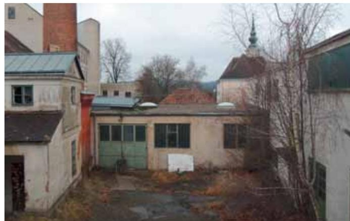
Abb. 3.97: Hoffassade, kiesgedecktes Flachdach des Verbindungsteils mit Lichtkuppeln
