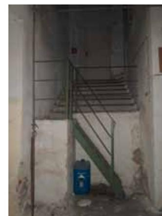
Abb. 3.14 (links): Stahlleiter zu Stiege im Erdgeschoß
