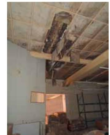
Abb. 4.12: Durchbruch der Doppelbaumdecke im 1. Obergeschoß
