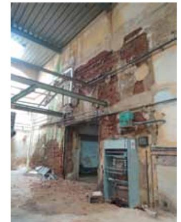
Abb. 4.22: Fortsetzung des Feuchteschadens im Erdgeschoß und in Shed I
