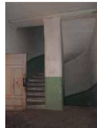
Abb. 3.50 (links): Stiegenhaus mit halbgewendelter Natursteinstiege zwischen West- und Nordtrakt (Aufnahme im 2. Obergeschoß)
