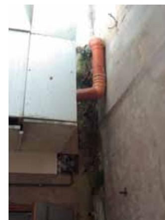
Abb. 4.32: Nach innen geführtes Entwässerungsrohr
