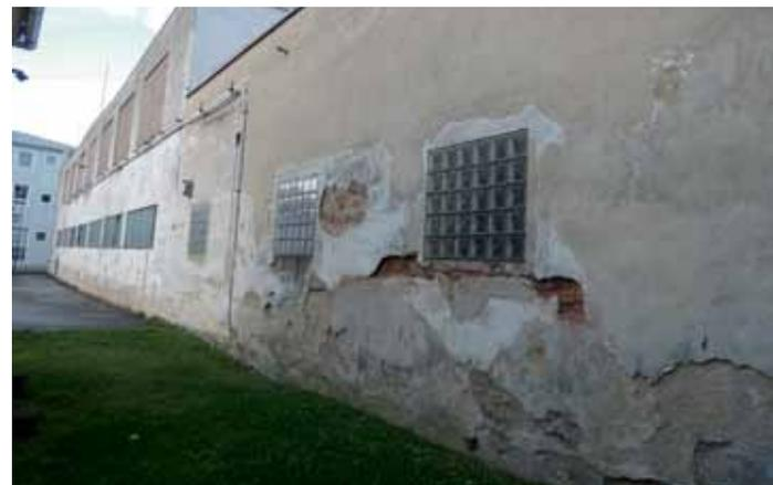
Abb. 4.51: Aufsteigende Feuchtigkeit an der Außenwand der Färberei-Halle II
