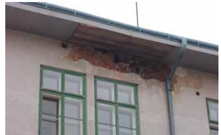
Abb. 4.15: Provisorische Reparatur des Dachvorsprungs
