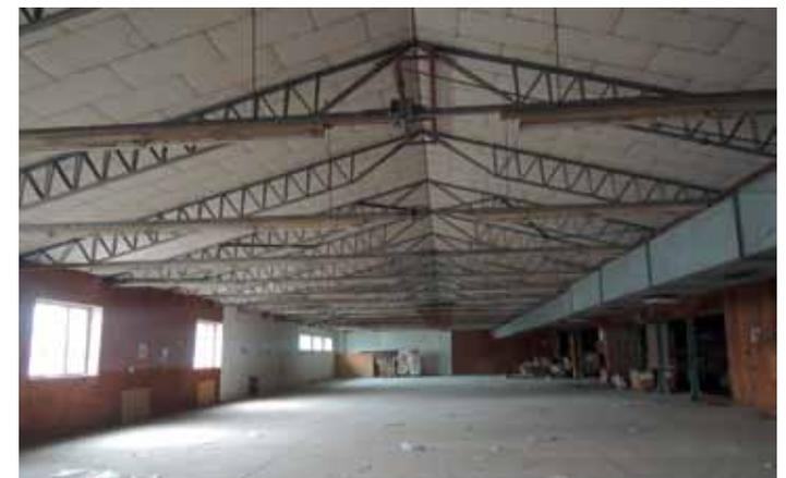
Abb. 3.78: Stützenfreies Obergeschoß mit Stahlfachwerkträgern
