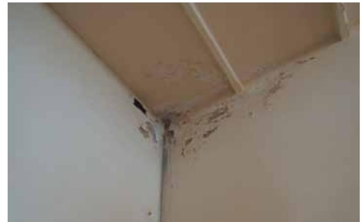
Abb. 4.45: Feuchteschaden an der inneren Raumecke
