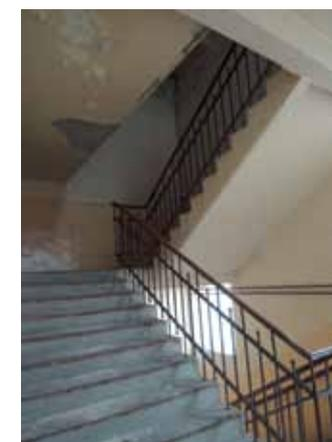
Abb. 3.15 (rechts): Stiege aus Stahlbeton (Aufnahme im 2. Obergeschoß), Untersicht des Steges zu Wohnungen im Dachgeschoß
