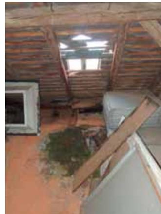
Abb. 4.6: Loch in der Dachdeckung
