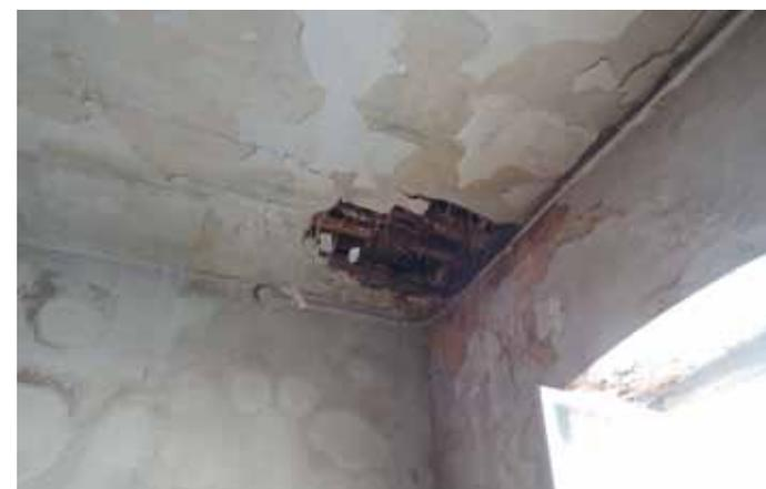
Abb. 4.18: Feuchteschaden an der Untersicht der Dippelbaumdecke im 1. Obergeschoß
