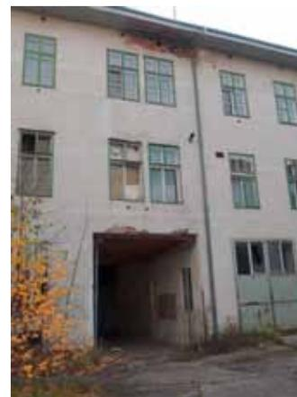
Abb. 4.52: Senkung der Decke über der Einfahrt im Straßentrakt
