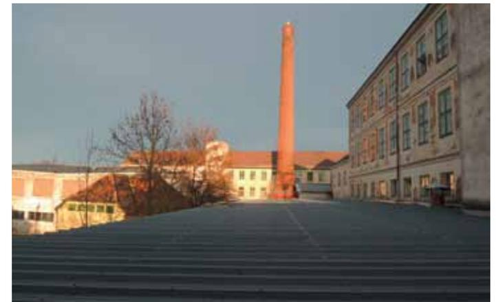
Abb. 3.96: Trapezblechdach, erhöhte Fensterparapete im 1. Obergeschoß des Nordtraktes
