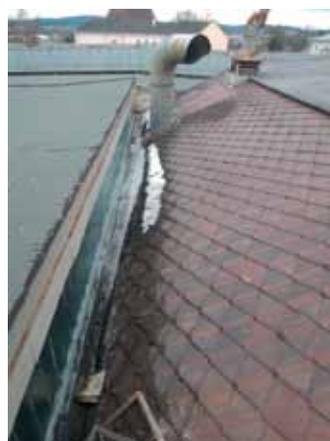
Abb. 4.34: Entwässerungsrinne entlang des Oberlichtbandes
