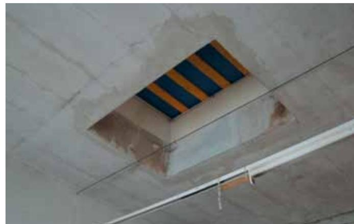
Abb. 4.27: Provisorische Reparatur einer Lichtkuppel
