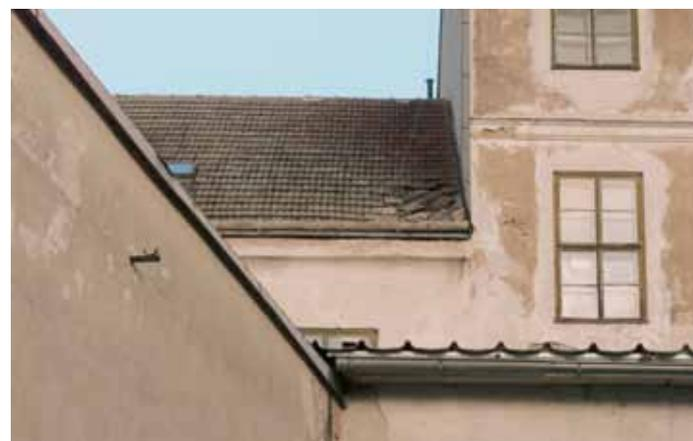
Abb. 4.17: Undichte Stelle in der Ziegeldeckung
