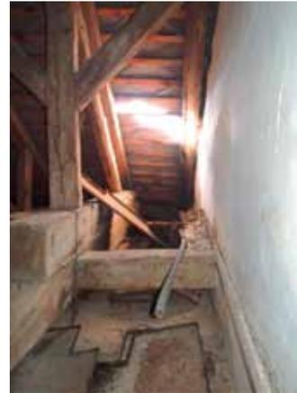
Abb. 4.5: Loch in der Dachdeckung
