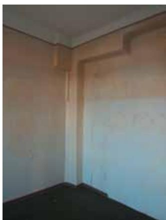
Abb. 3.20 (rechts): Verkleidete Stütze im 1. Obergeschoß des Straßentraktes, vermutlich Holz
