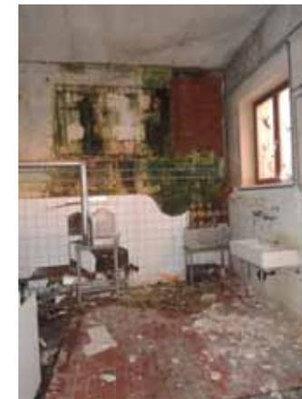
Abb. 4.21: Durchfeuchtete Ziegelwand
