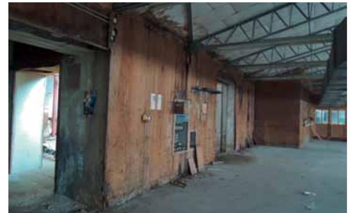
Abb. 4.29: Fortsetzung des Feuchteschadens an der Zwischenwand zur Schlichterei
