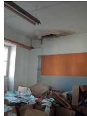
Abb. 4.8: Feuchteschaden an der Decke im 1. Obergeschoß
