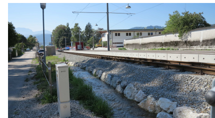
Abbildung 48: offen fließender Bach in der Hochmüllergasse
