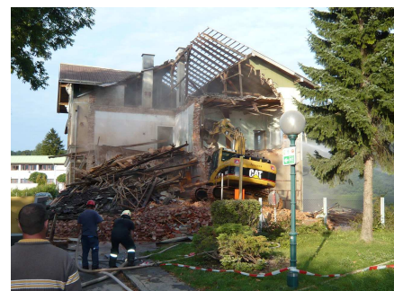
Abbildung 27: 2010 Abbruch des alten Seebahnhofes
