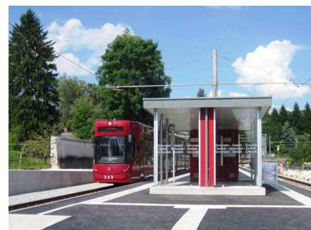
Abbildung 28: 2014 neue Haltestelle Seebahnhof
