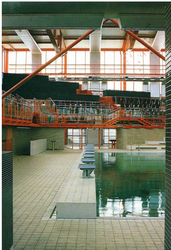
Abb. 20 - Blick auf das Sportbecken und auf die Zuschauertribüne, 1990
