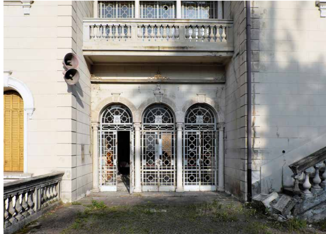
Abb. 94 Detail der Östlichen Fassade. Abblätterung, Flecken und Ablaufstellen des Putzes. Dettaglio della Facciata est. Esfollazione, macchie e colature degli intonaci.
