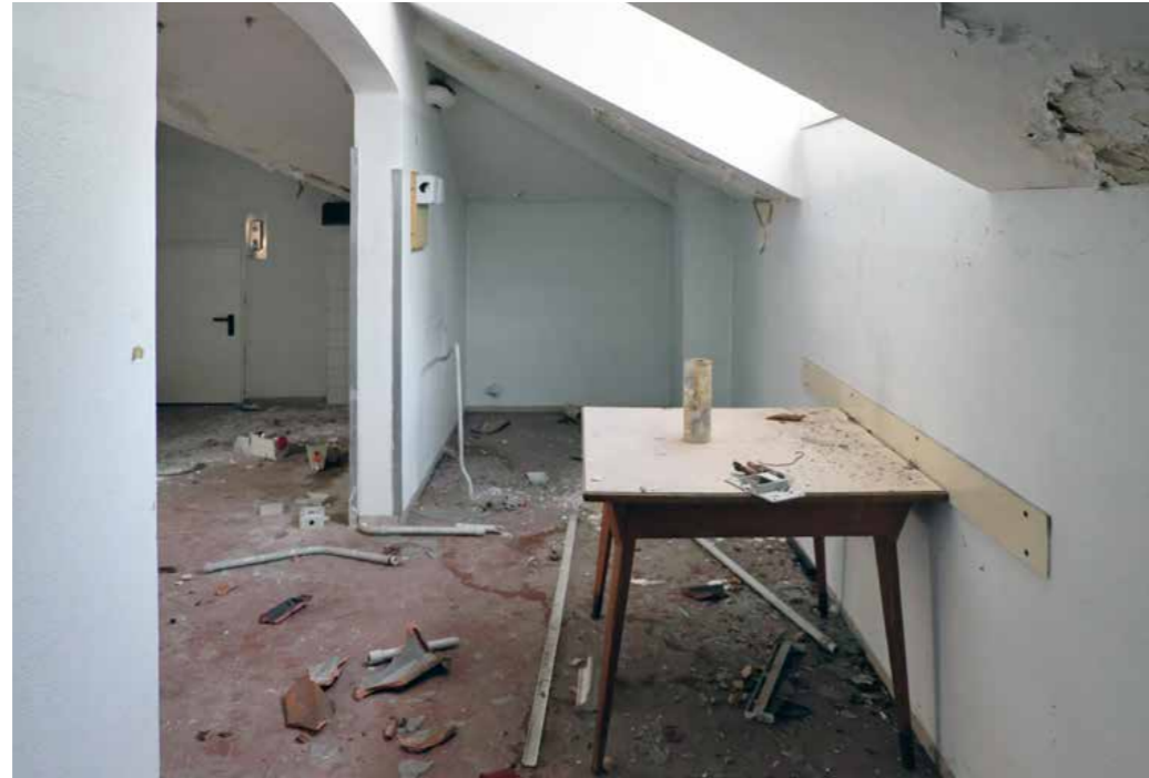
Abb. 220 Raum Nr. 3.03, Küche. Nördlicher Teil. Stanza nr. 3.03, cucina. Parte nord.
