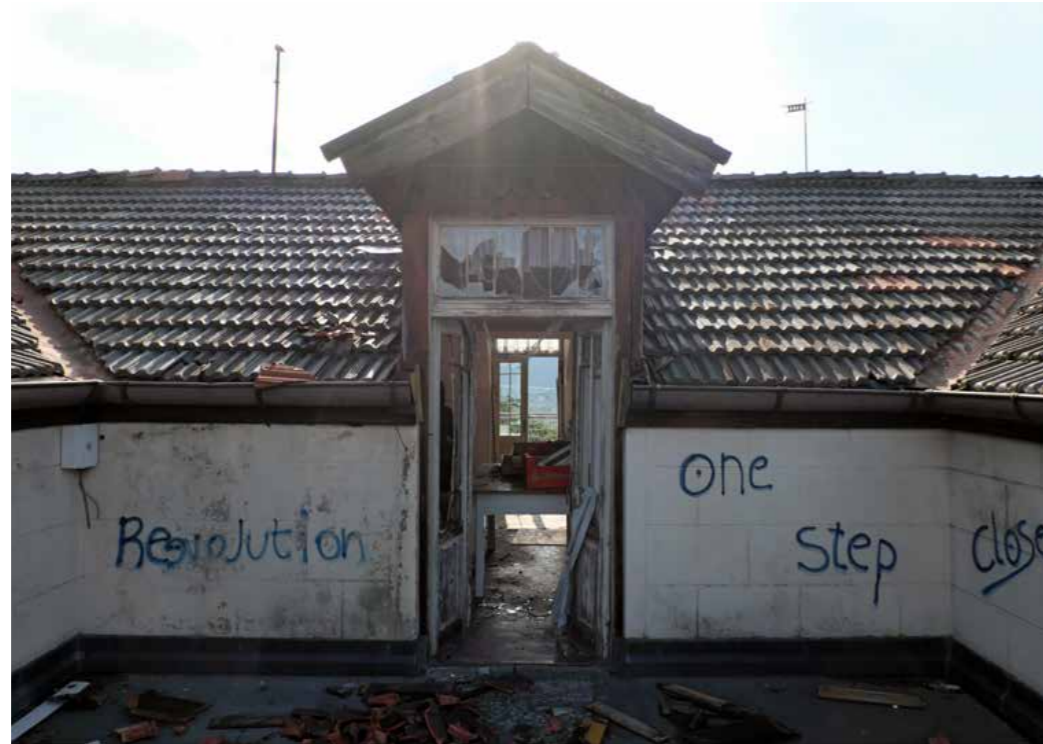
Abb. 103 Dachfenster und Terrasse im 3. OG. Abbaino e terrazza del terzo piano.
