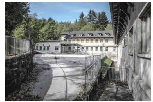
7 LINKS: Abb. 29 Passage zwischen den zwei neuen Gebäuden. Passaggio tra i due nuovi edifici. 8 RECHTS: Abb. 30 Parkplatz. Parcheggio.
