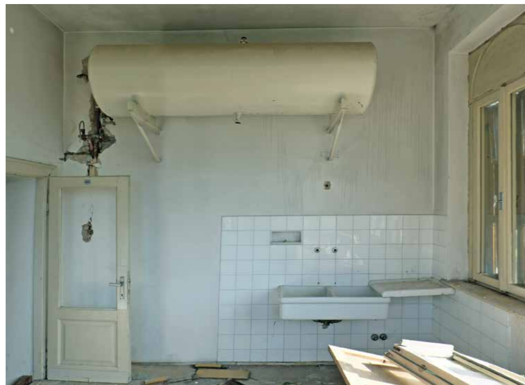
Abb. 234 Eckturm. Nordwand. Torretta rettangolare. Parete nord.
