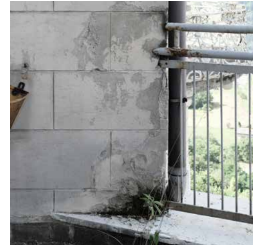
LINKS: Abb. 105 Rissbildung und Salzausblühung. Fessurazione e efflorescenza salina. RECHTS: Abb. 106 Biologischer Befall an dem Mauersockel. Patina biologica sulla base del muro. UNTEN: Abb. 107 Luftbild Westfassade. Foto aerea facciata ovest.
