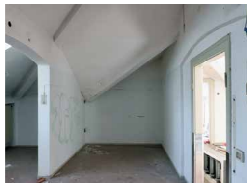
Abb. 223 Raum Nr. 3.03, Küche. Südlicher Teil. Stanza nr. 3.03, cucina. Parte sud.
