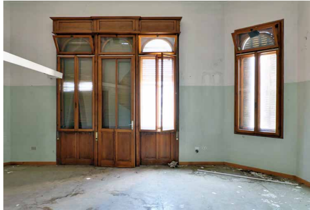
Abb. 181 Raum Nr. 1.11, Untersuchungsraum. Tür-Fenster Kombination. Stanza nr. 1.11, ambulatorio medico. Combinazione porta finestra.
