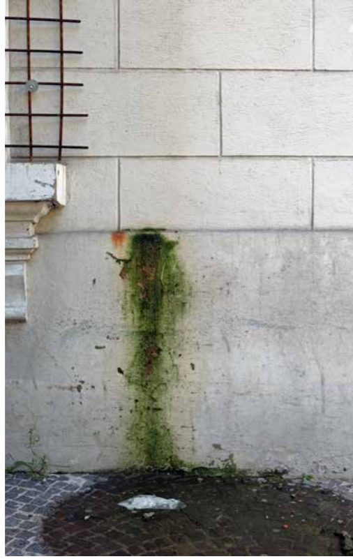
LINKS: Abb. 98 Biologischer Befall an dem Mauersockel. Patina biologica sulla base del muro. RECHTS: Abb. 99 Schlechter Zustand des Fensters. Cattivo stato di conservazione della finestra.
