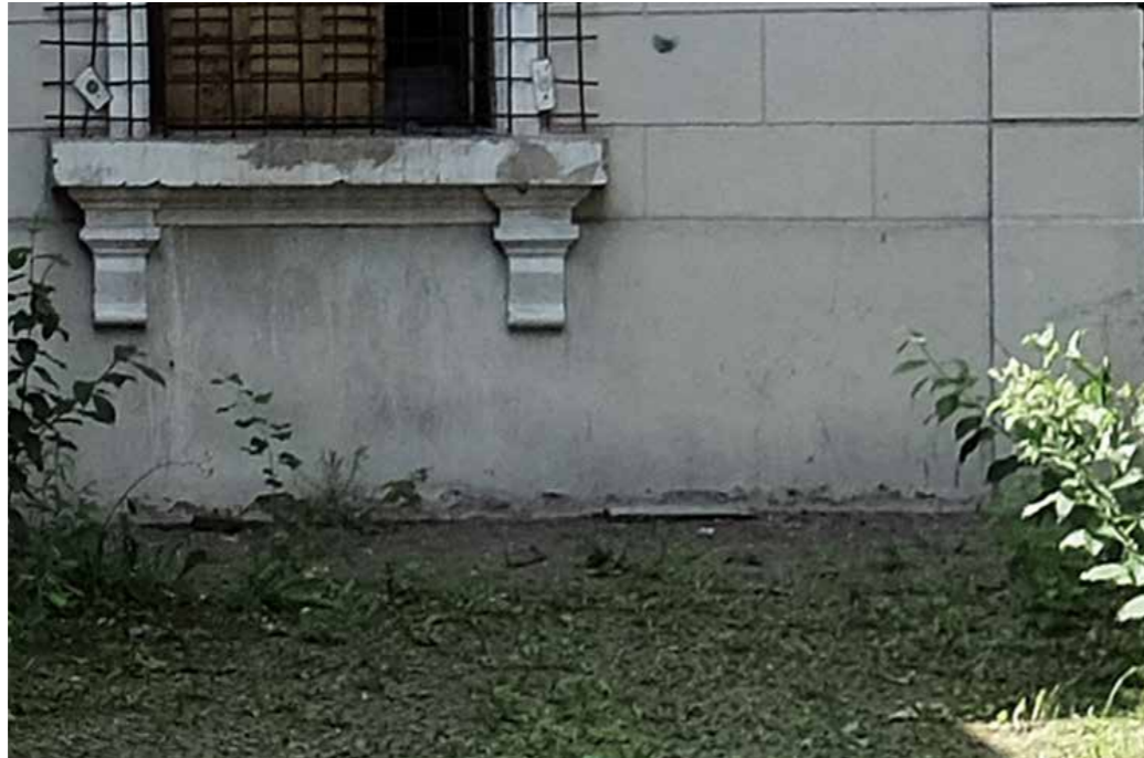
Abb. 100 Abheben und Ablösen des Putzes am Mauersockel. Sollevamento e distacco dell'intonaco alla base del muro.
