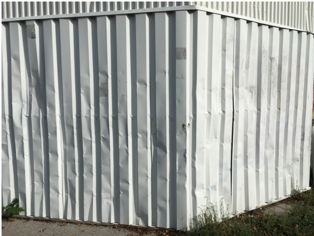
Abb. 42 Schaden Wellblechfassade
