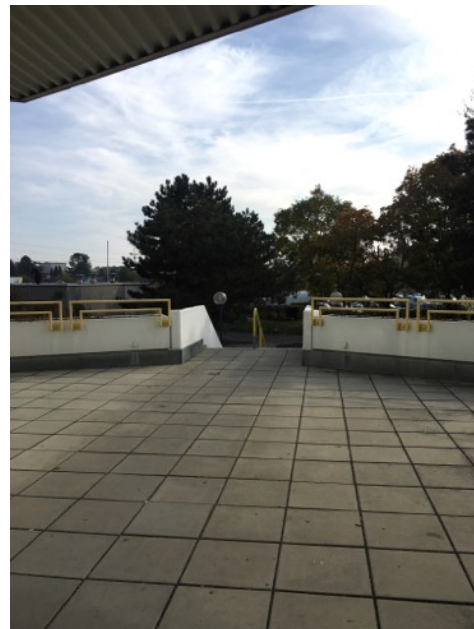
Abb. 32 Waschbetonplatten
