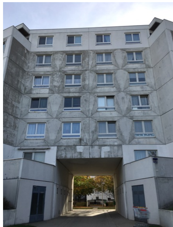
Abb. 65 Verwitterte Betonfassaden
