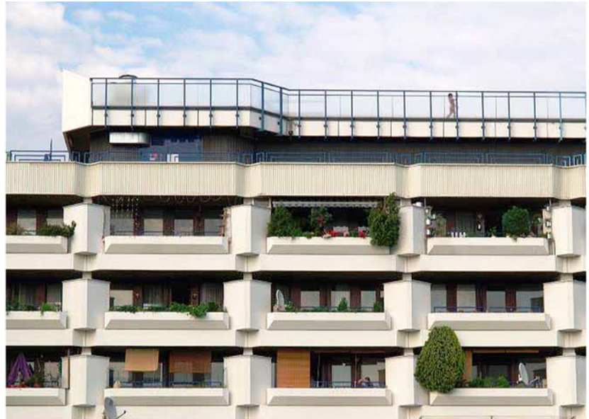
Abb. 18 Heinz-Nittel-Hof Geländer des Schwimmbads
