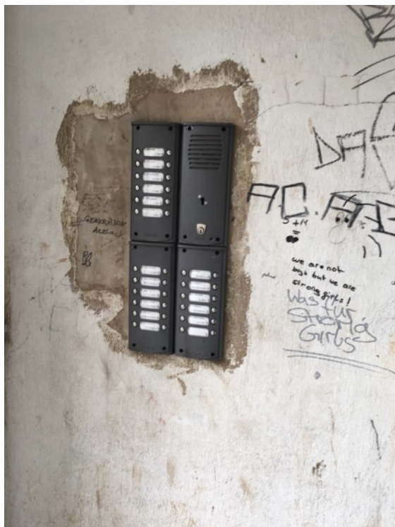
Abb. 64 Beschädigungen Gegensprechanlagen
