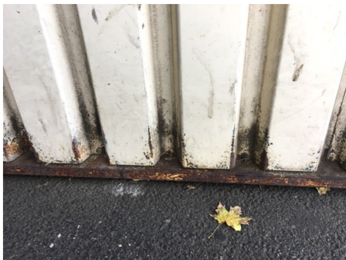
Abb. 69 Korrosion Heinz-Nittel-Hof
