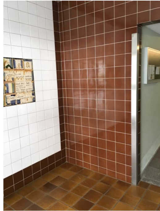
Abb. 55 Eingangssituation Block A
