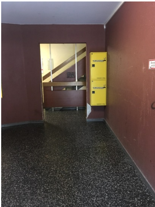
Abb. 56 Eingangssituation Block F
