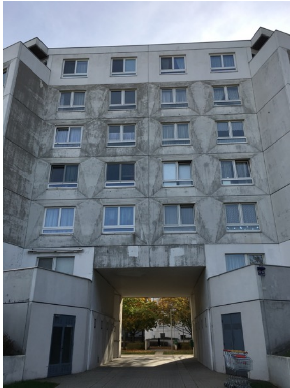
Abb. 46 Fassade Block B Straßenansicht
