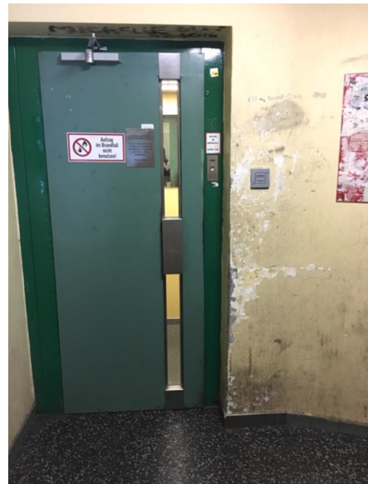
Abb. 57 Bereich vor Lift Eingang Block E
