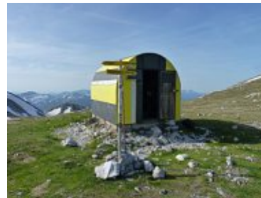
Abb.0 105 Frontansicht mit Zugang
