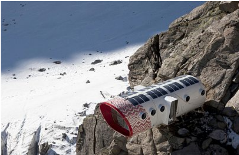
Abb.0 31 Gervasutti Biwak mit Solarzellen am Dach
