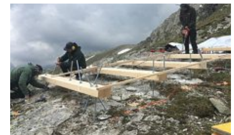
Abb.0 66 Montagearbeiten Fundament
