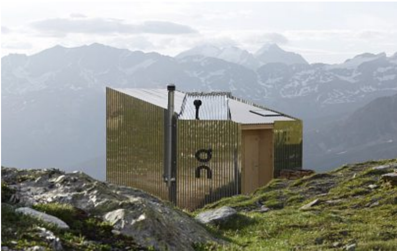
Abb.0 70 Außenansicht mit Eingang ON Hütte
