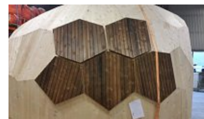
Abb.0 60 Vorfabrikation im Werk
