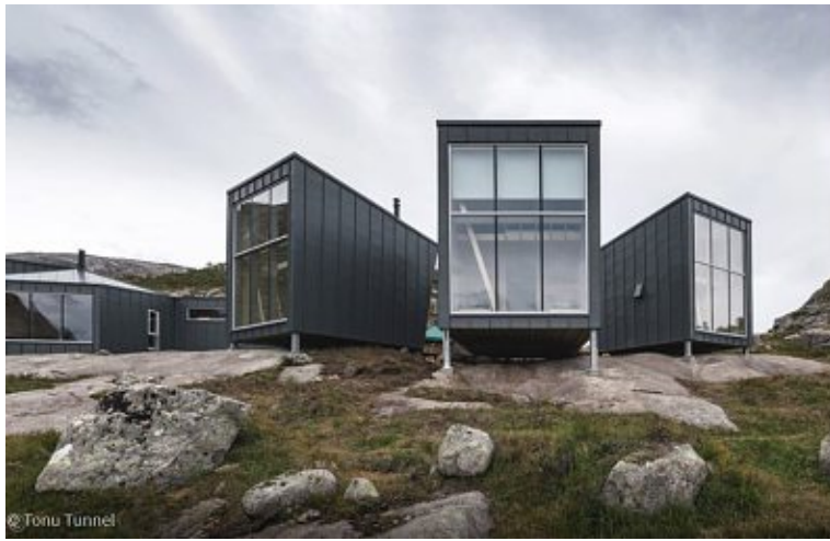
Abb.0 80 Außenansicht Skapet Mountain Cabins
