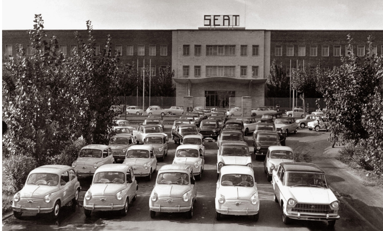
Abb. 1, Produktionshalle Zona Franca 1954
