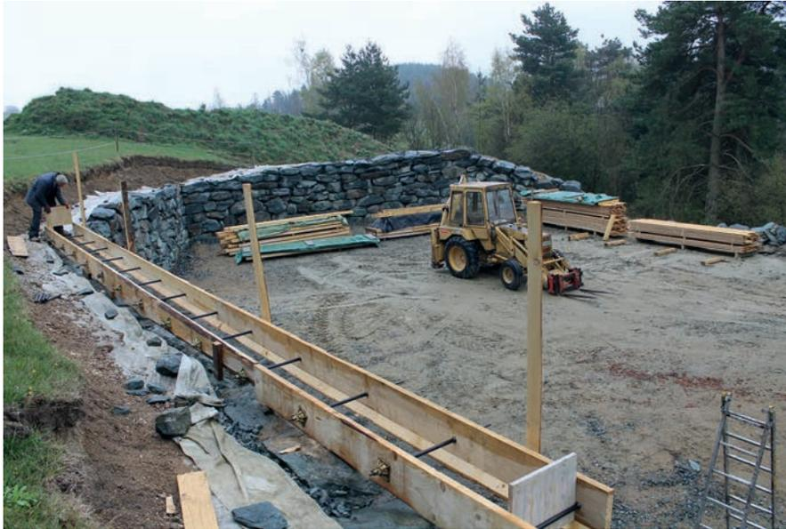
Abb. 77\_Schalung für Betonaufleger
