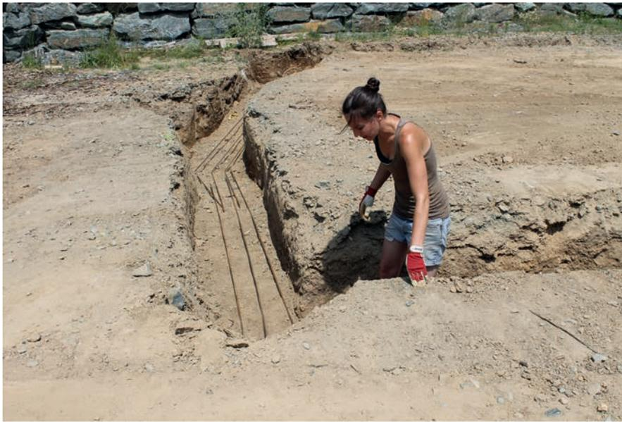
Abb. 87\_Bewehrung für Streifenfundament mit gleichmäßiger Belastung
