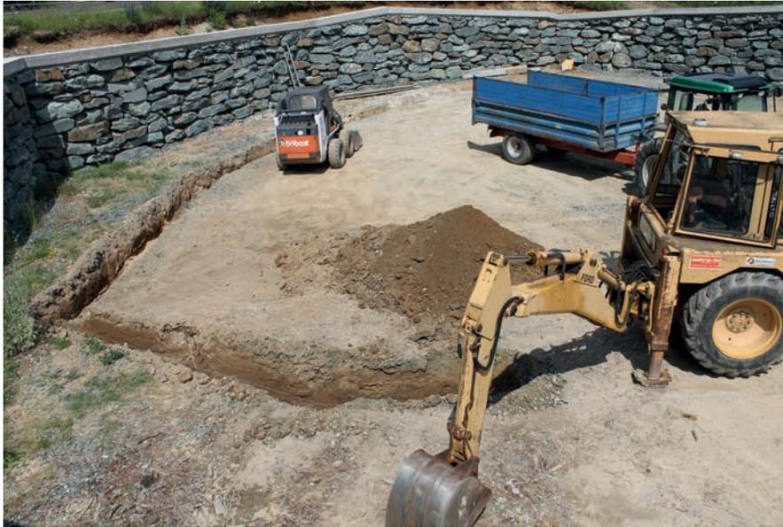
Abb. 67\_Aushub für Fundament
