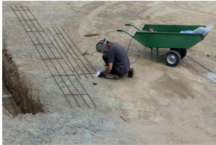
Abb. 88\_Bewehrung für Streifenfundament mit hoher Punktbelastung
