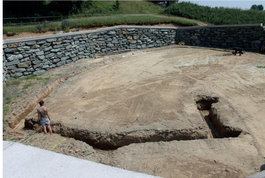
Abb. 68\_Aushub für Außenmauerfundament
