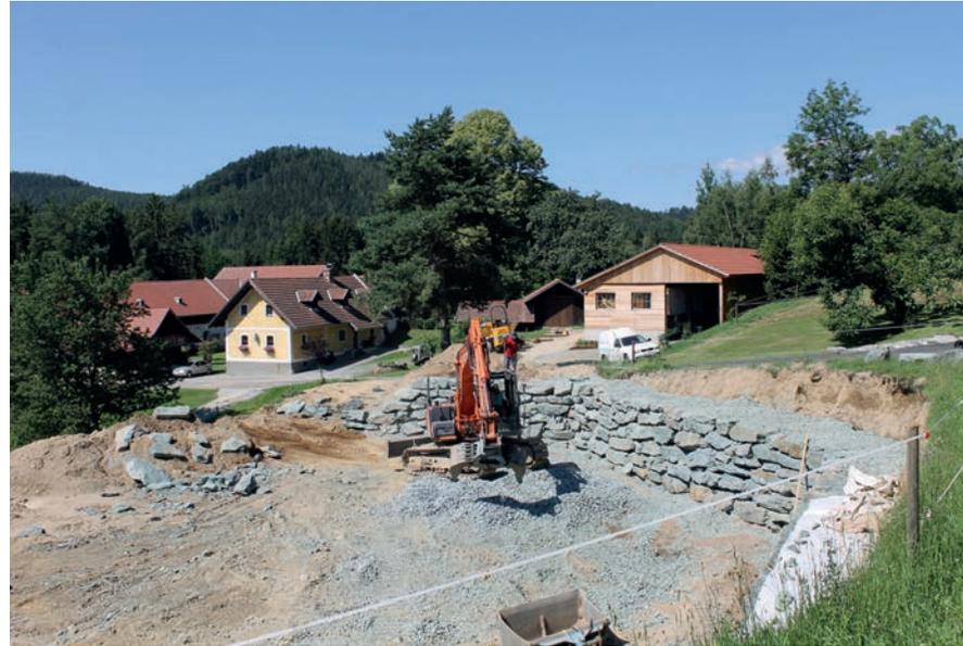
Abb. 63\_Steinmauer wird hinterfüllt
