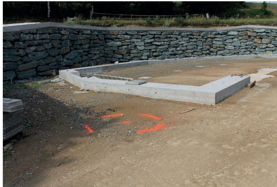
Abb. 70\_fertiges Fundament mit Markierung für Außenstütze
