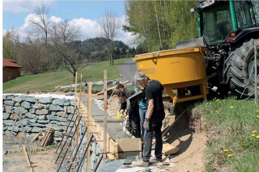
Abb. 78\_Befüllung der Schalung
