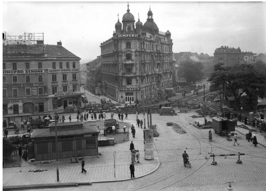
Abb. 87 - historisches Foto vom Bestandsgebäude (links im Bild)
