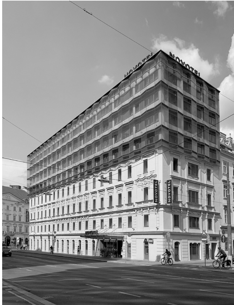
Abb. 81 - Adolf Krischanitz, Aufstockung Novotel, Wien, 2007
