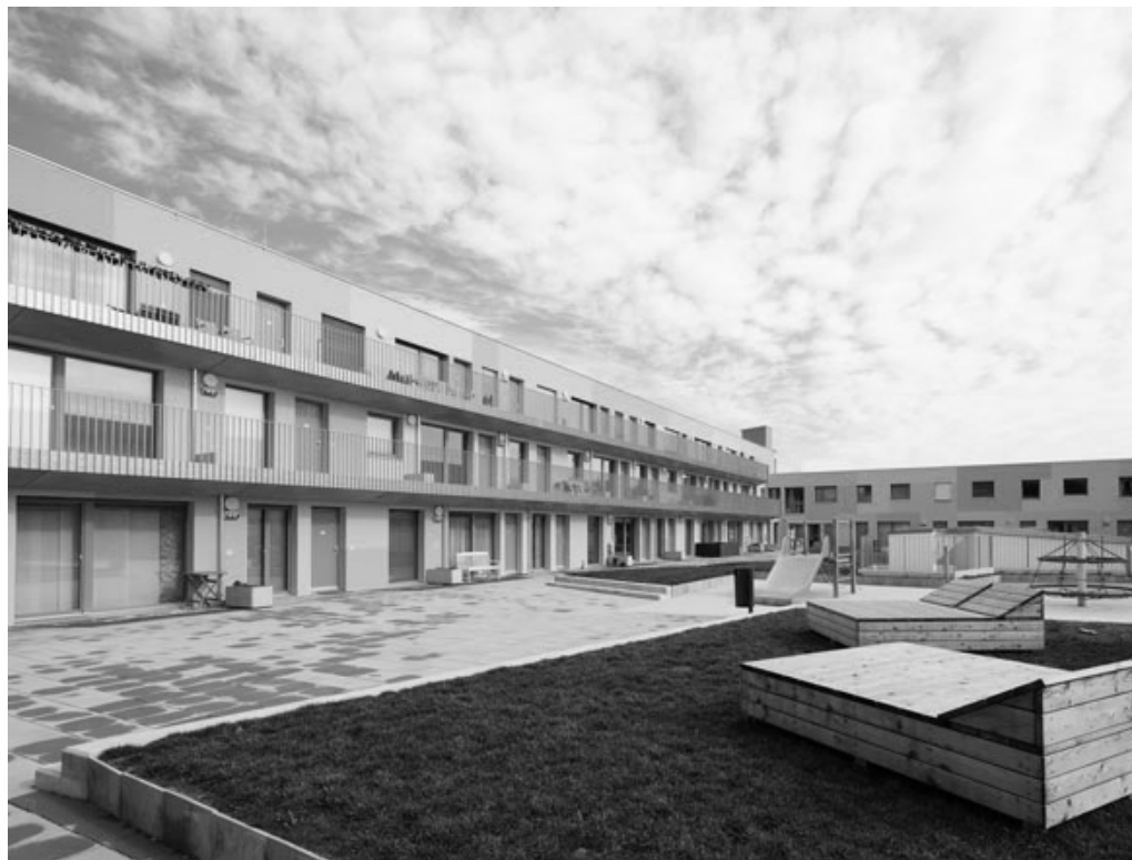
Abb. 06 - querkraft, Aufstockung Auhof-Center, Wien, 2015
