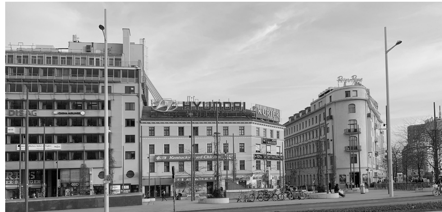
Abb. 88 - Foto vom Bestandsgebäude (mittig im Bild)
