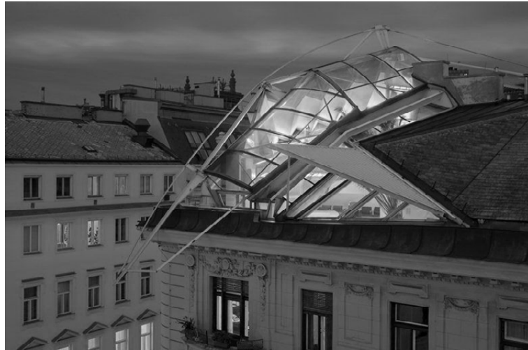
Abb. 79 - Coop Himmelblau, Dachgeschossausbau Falkenstraße, Wien, 1983
