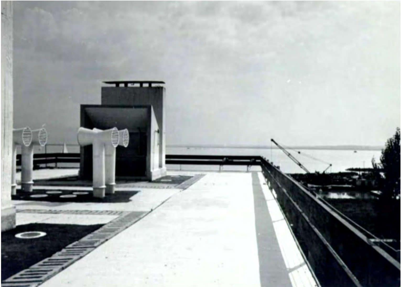
Abb. 52: Ansicht von dem Dach
