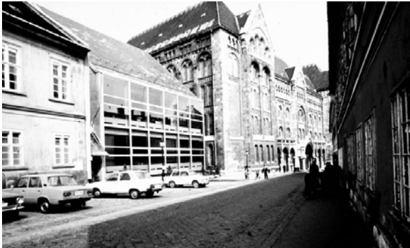
Abb. 13: Budavárer staatliches elektrisches Transformatorhaus vom Csaba Virág
