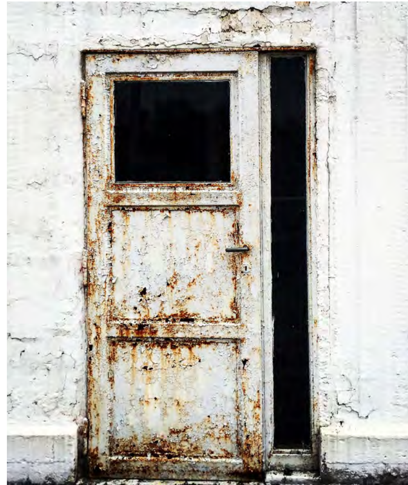
Abb. 61 Stahltür auf dem Dach
