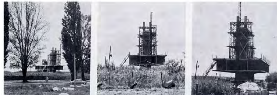
Abb. 59yx: im Laufe der Rohbau-Phase
