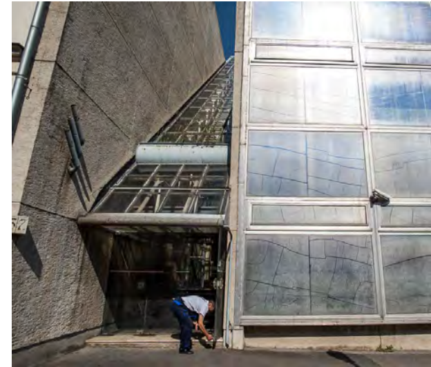
Abb. 36: Eingang des Transformatorhauses
