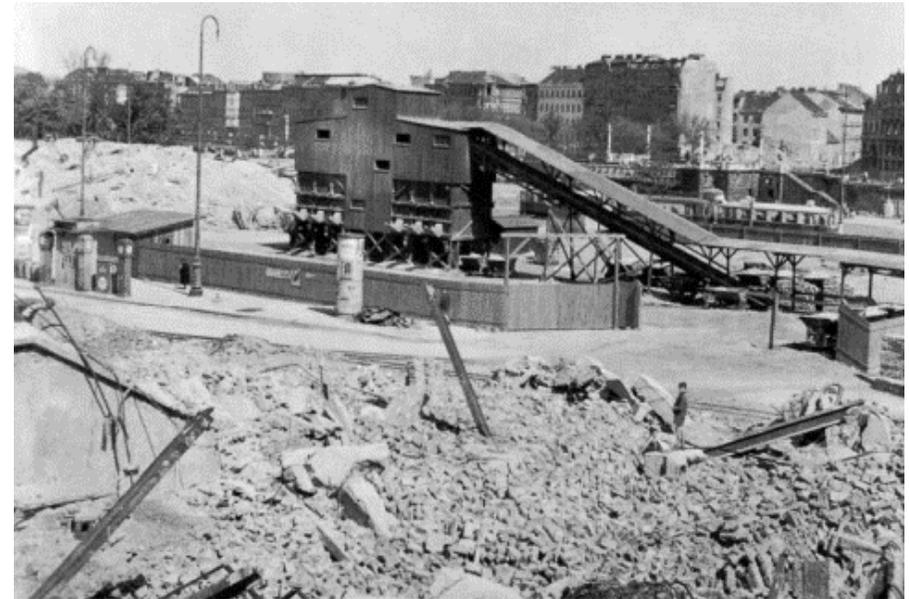
*Abbildung 59 Schwedische Maschine mit der Bausteine aus Schutt gepresst wurden, Quelle: Quelle: 150 Jahre Wiener Stadtbauamt, Seite 50*
