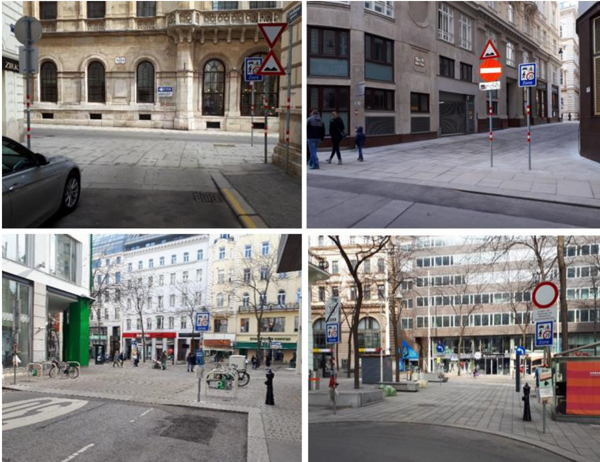
Abbildung 100: Belagswechsel beim Übergang zur Begegnungszone aus Seitengassen kommend (oben: Begegnungszone Herrengasse, unten: Begegnungszone Mariahilfer Straße Ost)
