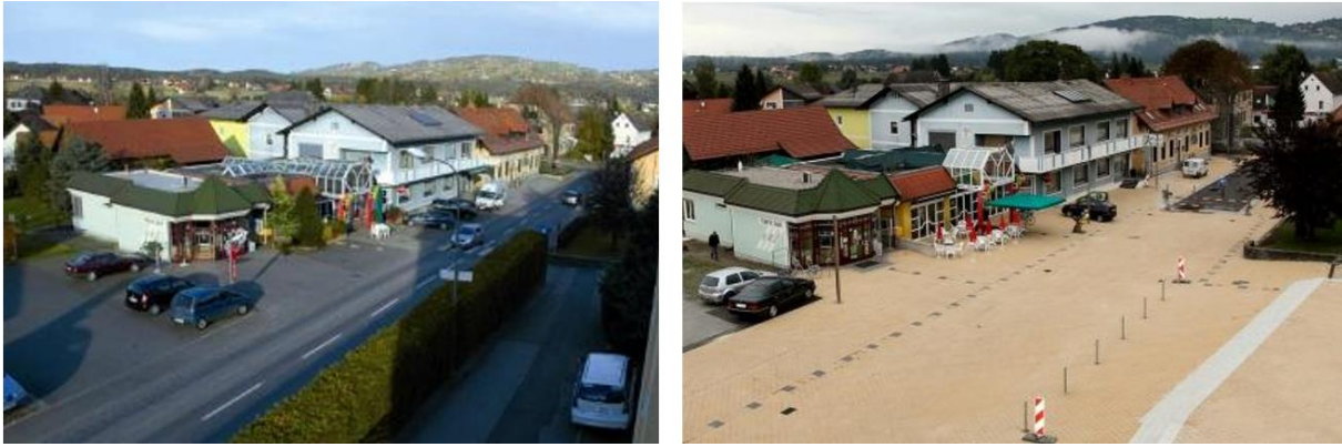
Abbildung 2: Ortsdurchfahrt Gleinstättens vor und nach der Umgestaltung nach dem „Shared Space“-Prinzip (Verkehrsabteilung Steiermark 2017, Online)
