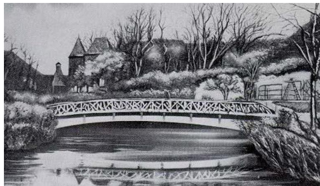
Abbildung 1.1: Erste Eisenbetonbrücke der Welt bei Chazelet, Frankreich; Spannweite 16,5 m [3]
