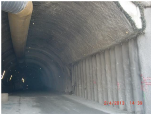
Fensterstollen Ampass, Deckelstrecke / finestra Ampass, tratto con coperta
