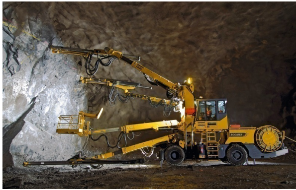
(a) 4-armiger Bohrwagen (3 Bohrarme und zusätzlich eine Hebebühne) [3]
