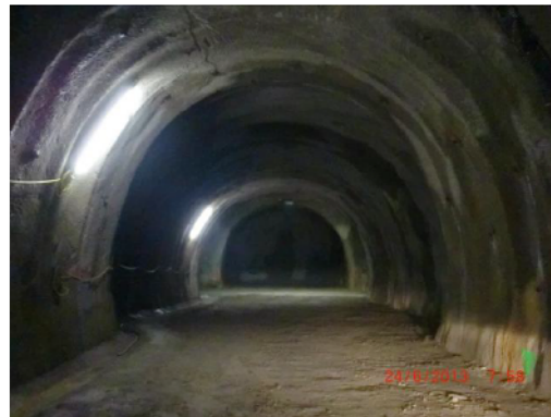
Kreuzungsbereich Fensterstollen – Rettungsstollen / zona d'incrocio finestra – cunicolo di soccorso
