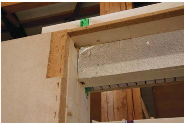
Abb. 210: Foto Detail Fensterlaibung - Rollladen, Longin
