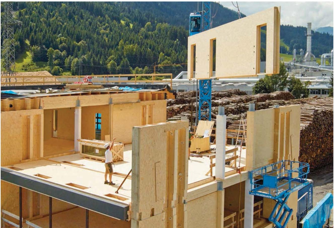
Abb. 78: Foto Stammhaus Egger, Versetzen der Wände
