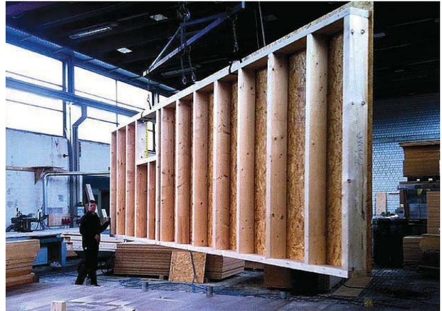
Abb. 65: Foto Holzriegelwand
