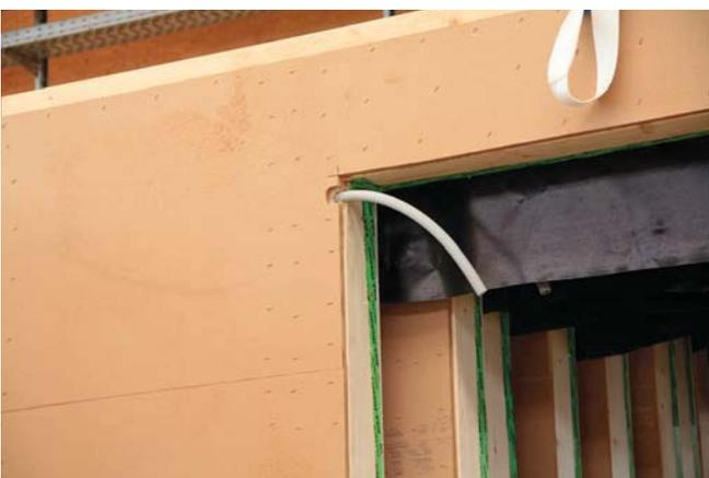
Abb. 192: E-Auslass in Vertigteilwand Diesner
