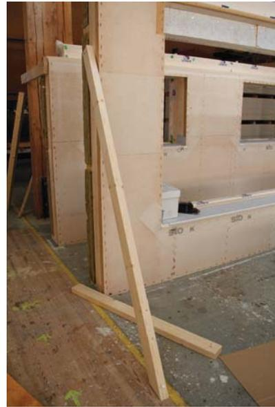
Abb. 212: Foto Sicherung Wand, Longin
