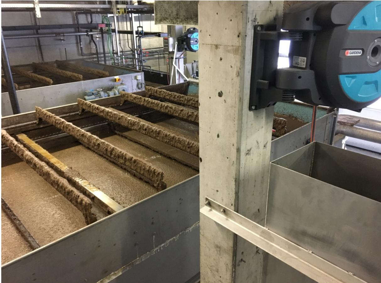
Abbildung 24: Flotation 1 (Hintergrund) und Flotation 2 (Vordergrund) mit Räumersystem und Flotatschlammteppich.
