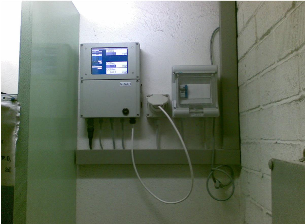
Abbildung 3: Steuergerät Messsonde
