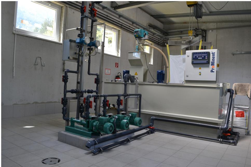
Abbildung 9: Polymerstation Flotationen
