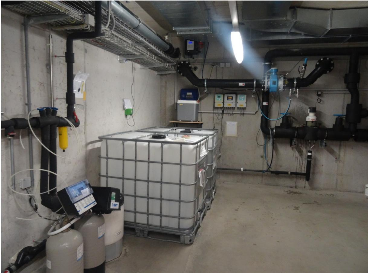
Abbildung 1: Abwasser-Neutralisations-/Mess-/Probenahmeeinrichtung eines Milchverarbeitungsbetriebes, Ausführung abgestimmt mit dem SV.
