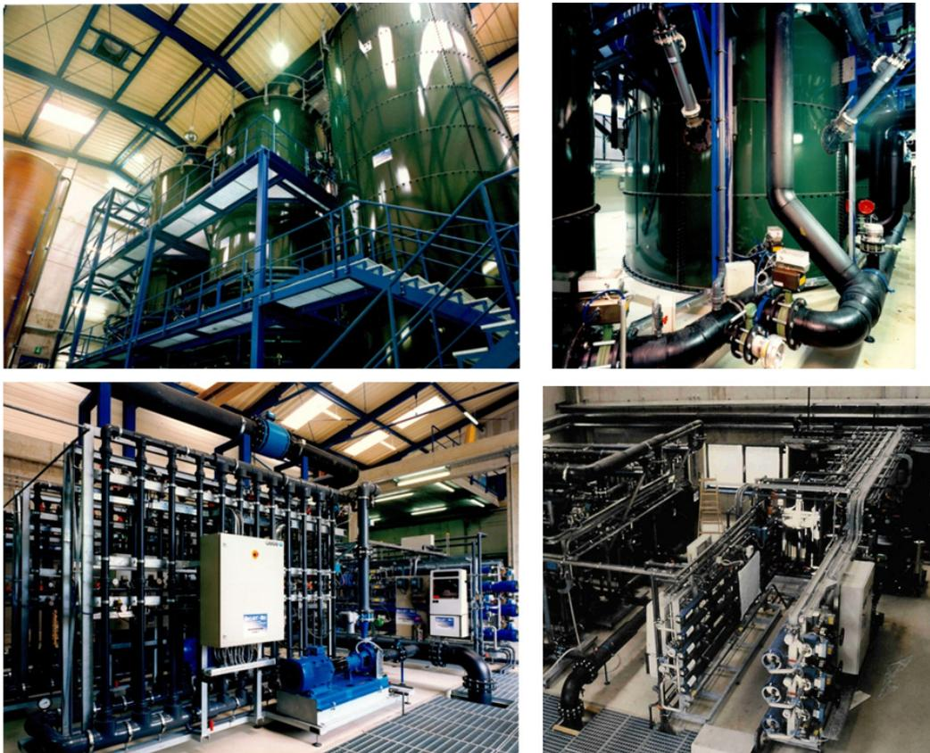
Abbildung 1: Großanlage zur Deponiesickerwasseraufbereitung
