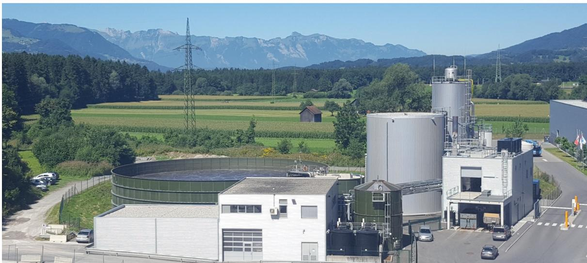
Abbildung 27: Altanlage (links altes Betriebsgebäude mit Rolltor, dahinter Belebungsbecken in grün) und Neuanlage (rechts Becken in Silber + Betriebsgebäude neu). Die neue Flotationshalle schließt an das alte Betriebsgebäude an (links im Vordergrund).
