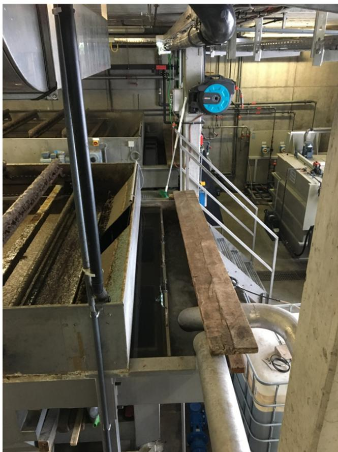
Abbildung 23: Flotationsstraßen 1 (Hintergrund) und 2 mit Flotatschlammabwurf (links) und Klarwasserüberlauf (rechts).
