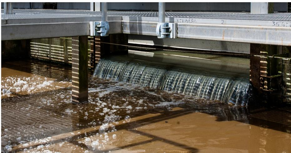
Abbildung 5; Flotation 1.1 Ablauf-Regelschieber
