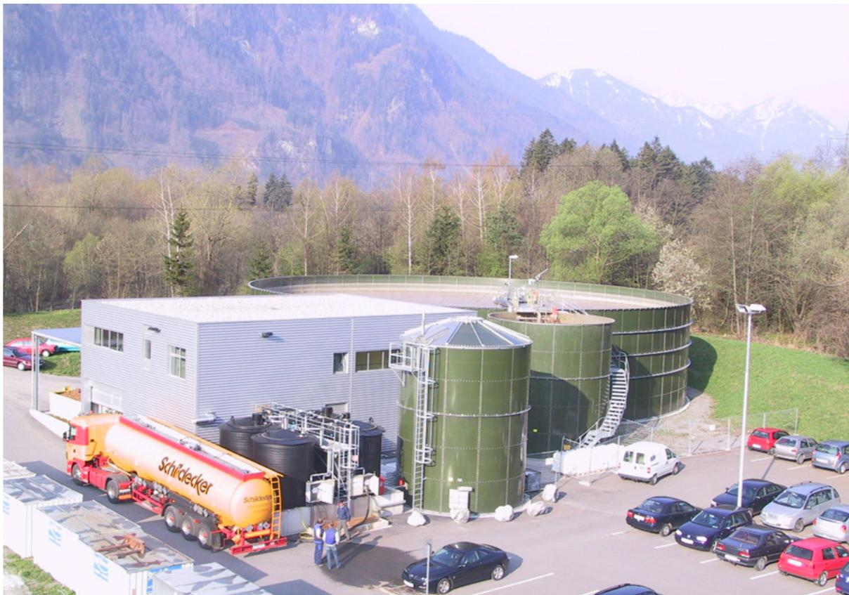
Abbildung 25: Betriebliche Abwasseranlage (erste Ausbaustufe) mit dem Betriebsgebäude mit Schlammplatz (links) Schlammbehälter (vorne Mitte), Selektorbecken (rechts) und Belebungsbecken (rechts hinten).
