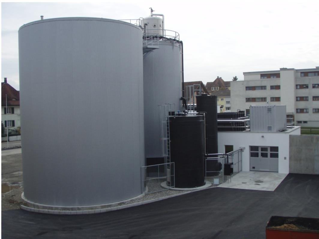
Abbildung 17: Misch- und Ausgleichsbehälter (Vordergrund), dahinter Reaktor
