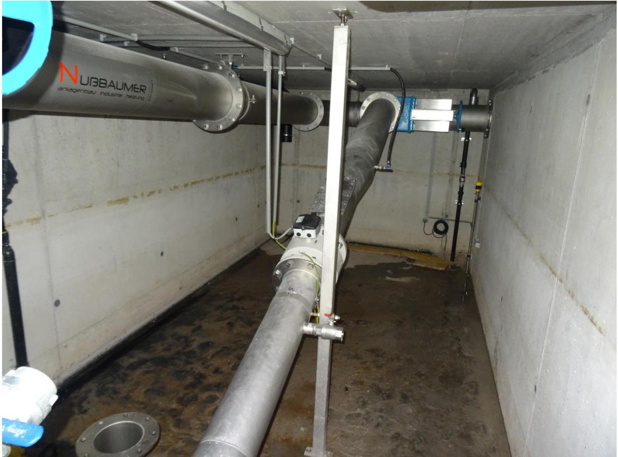
Abbildung 2: Abwasser-Messeinrichtung (MID) mit Ansteuerung eines mengenproportional betriebenen Probenahmegerätes bei einem Industriebetrieb.
