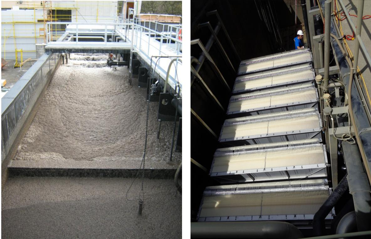
Abbildung 4: Abwasseraufbereitung in der Galvanik/Metalloberflächenbehandlung
