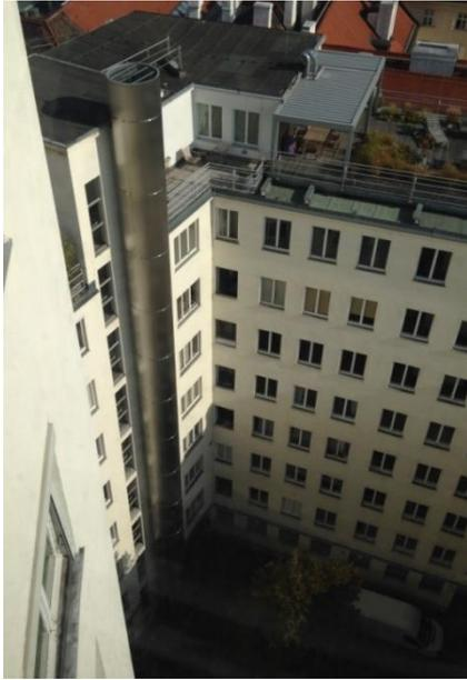
84. Abb. Entlüftungsrohr des Restaurants Vapiano über die Fassade des Haupthofes des Hochhauses Herrengasse, 2017
