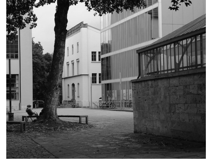
Abb. 20: Werkstattgebäude südlich des Hauptgebäudes, AV1 Architekten
