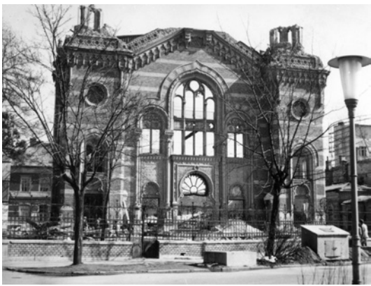
Abb. 51: Synagoge während der Abbrucharbeiten
