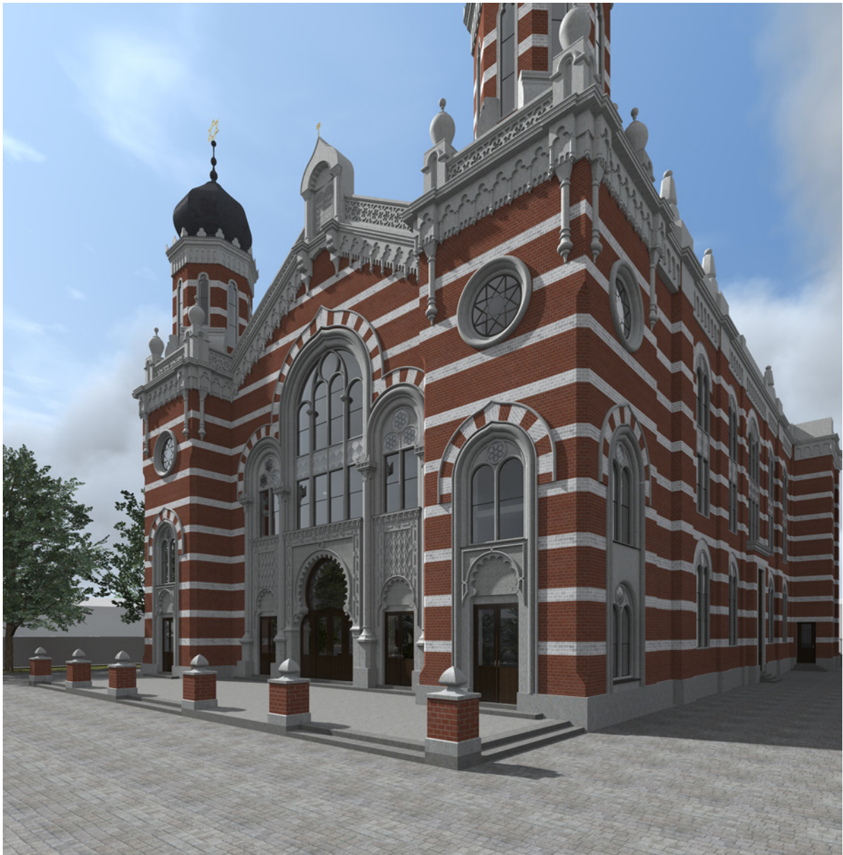
Abb. 131: Ansicht von Vorplatz auf Eingangsfassade
