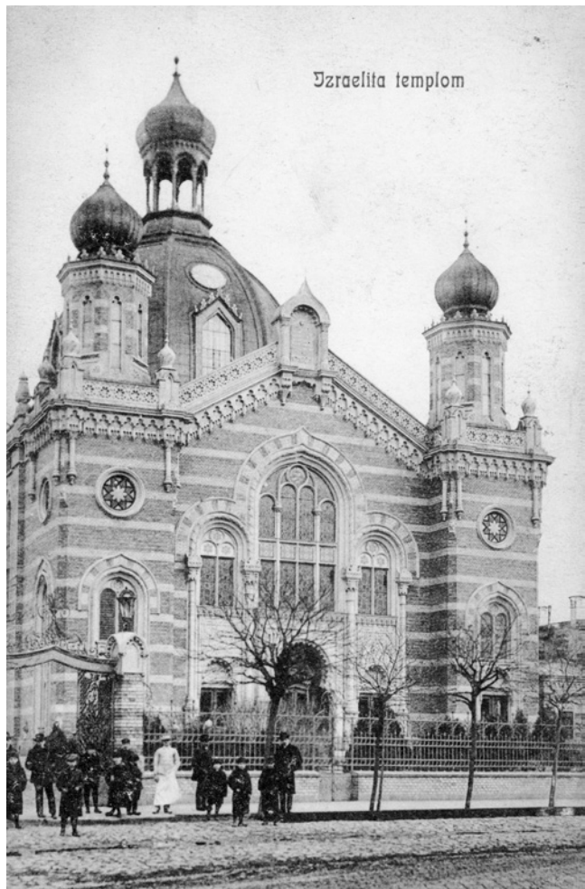
Abb. 52: Bild der Synagoge mit Blick auf Eingangstor
