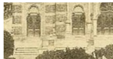
Abb. 64: Bild - Detail Stufen Eingang
