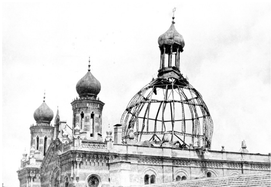
Abb. 20: Stahlkonstruktion vor Abriss
