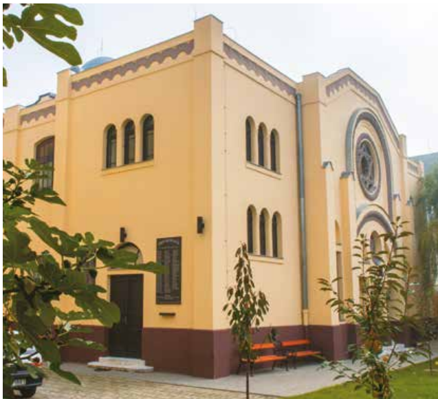
Abb. 04: Aussenaufnahme der Synagoge in der Kapolnasi Strasse
