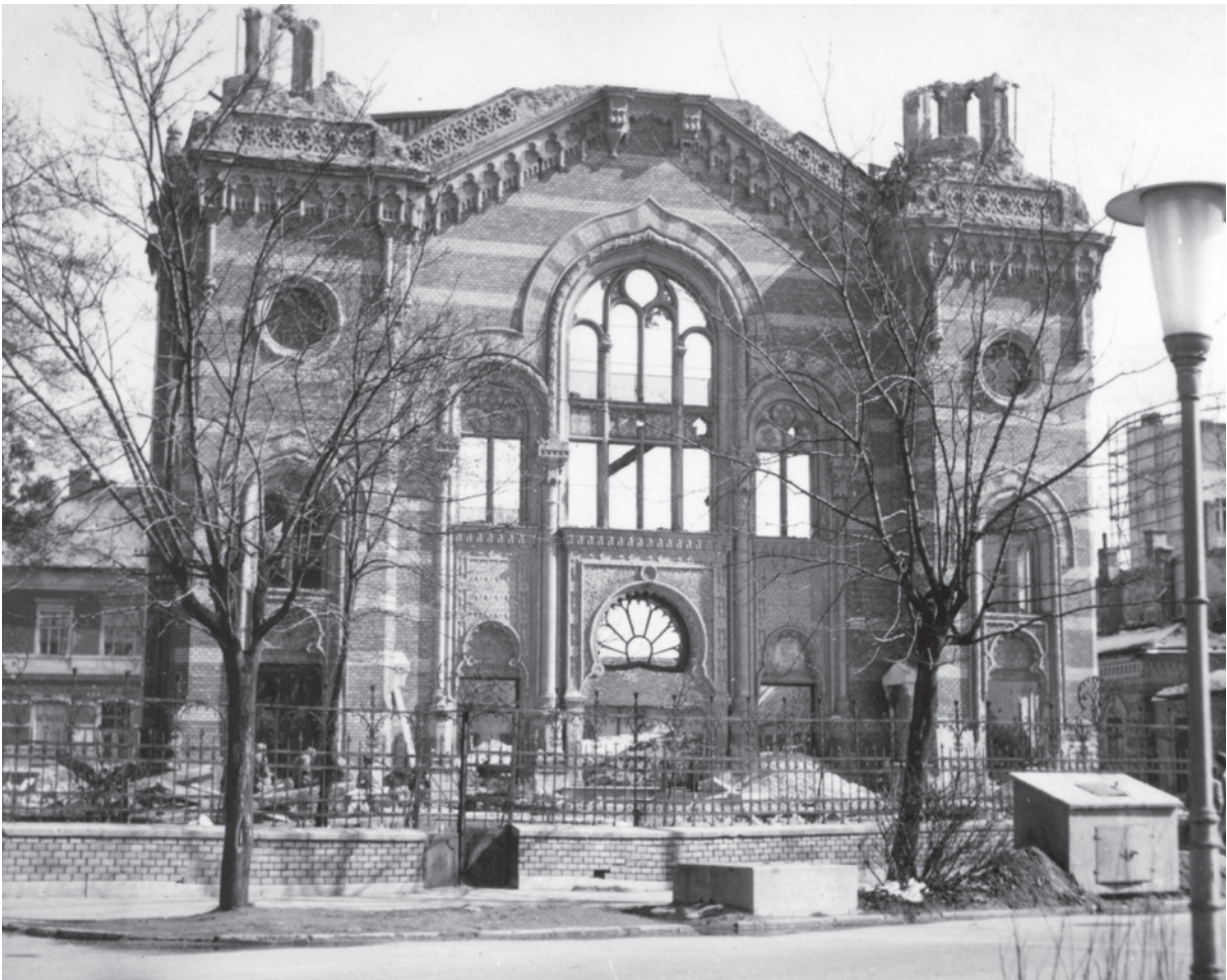
Abb. 27: Synagoge während Abbrucharbeiten
