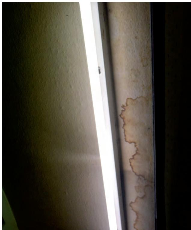
Abb.33 Wasserflecken Auslagendecke Hartinger
