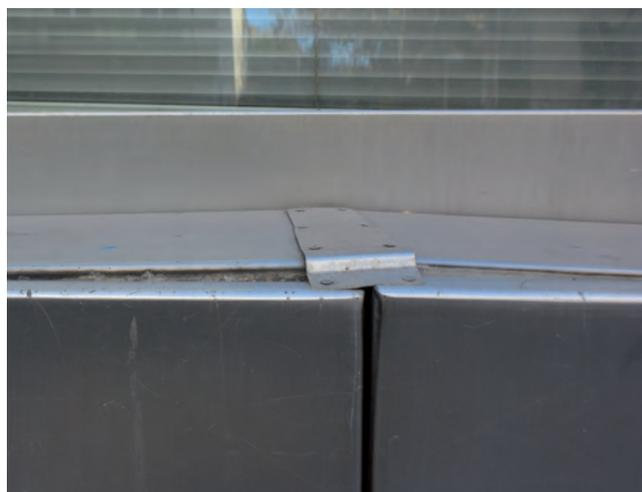
Abb.49 Fensterbankschäden Funder
