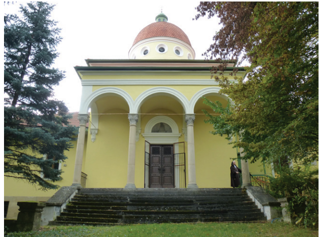
46. Der Portikus des Faniteums, Foto 2017
