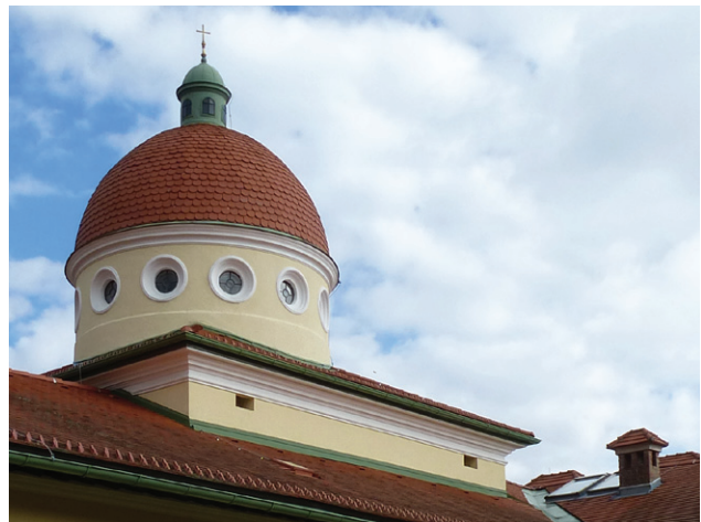
48. Die Kuppel des Faniteums von außen, Foto 2017
