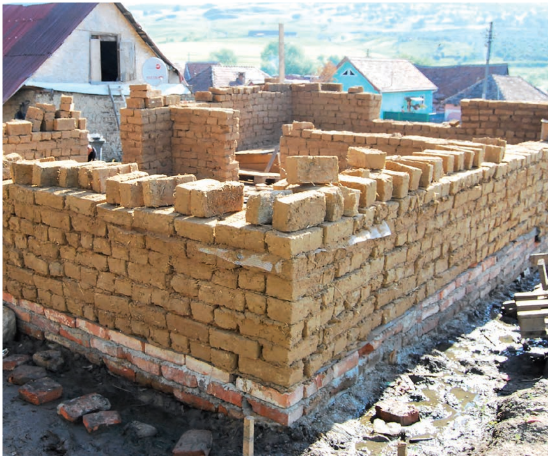
Abb. / Fig.67 Eckaussteifung Consolidarea colțurilor Roșia, 2016
