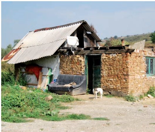
Abb. / Fig. 48 Haus neben der Brücke, 2016 Casa de lângă pod, 2016
