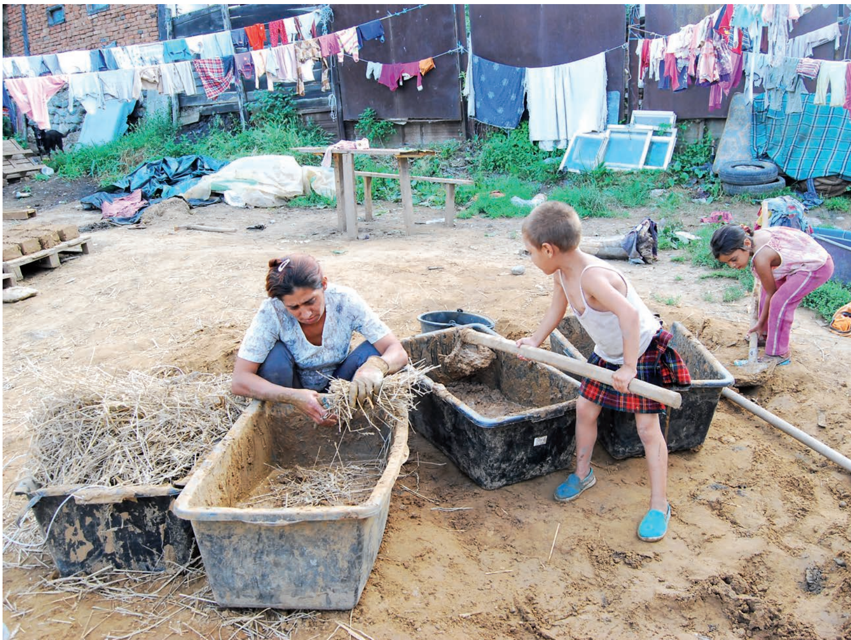
Abb. / Fig. 46 Claudia bereitet das Stroh für die Lehmziegel vor Claudia pregătește palele pentru cărămizi Roșia, 2016
