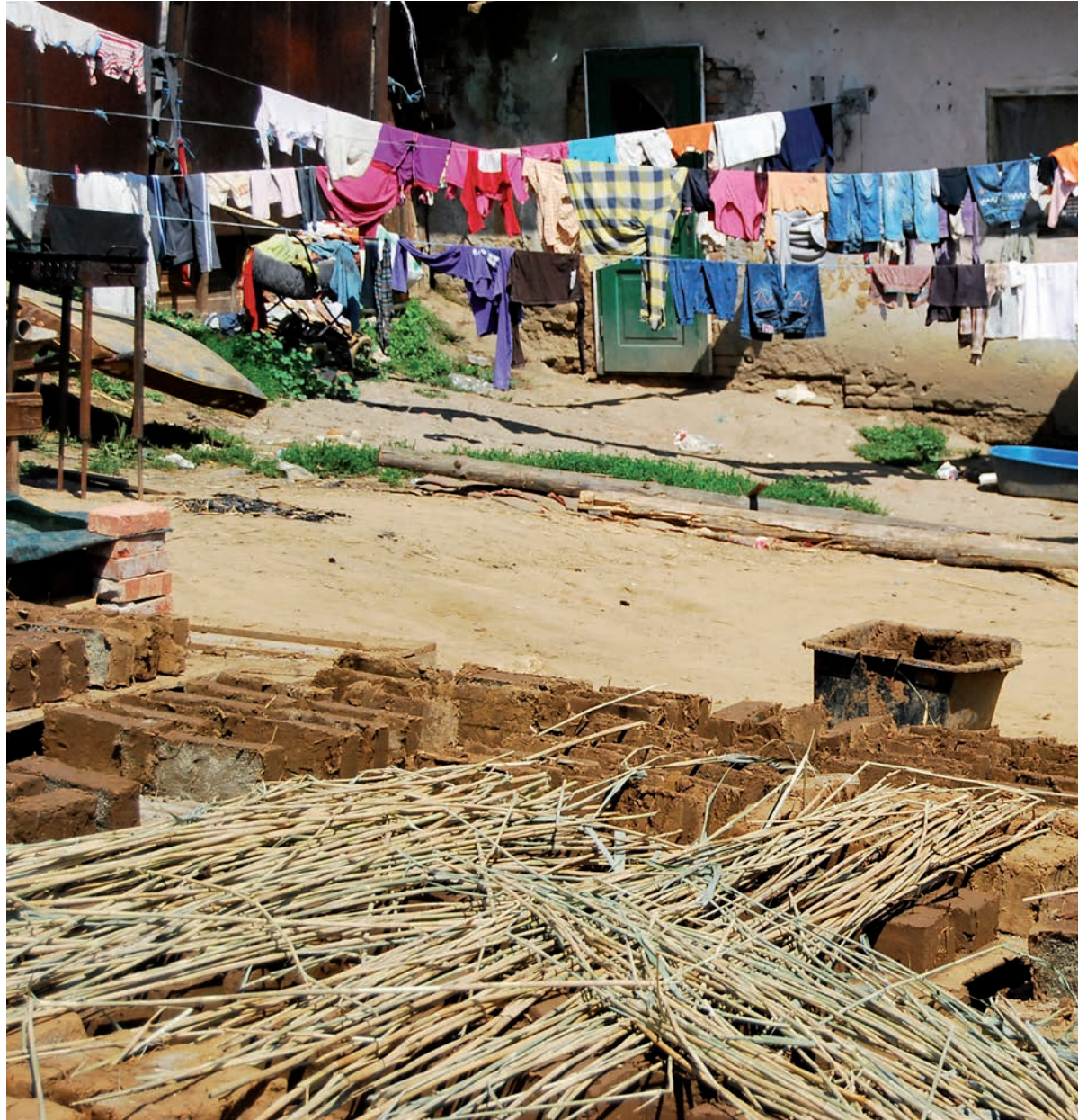
Abb. / Fig. 48 Die neuen Lehmziegel werden mit Stroh und Schilf gedeckt um den Trocknungsprozess zu verlangsamen Cărămizile din pământ proaspăt turnate se acoperă cu paie sau trestie pentru a încetini procesul de uscare Roșia, 2016
