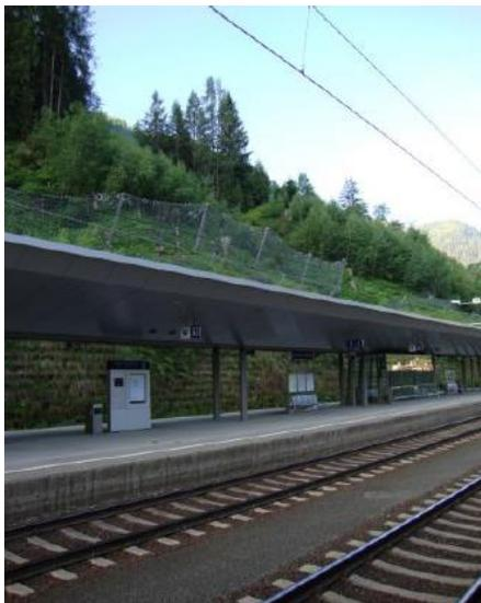
Abbildung 22: Steinschlagschutz für den Bf. St. Anton
