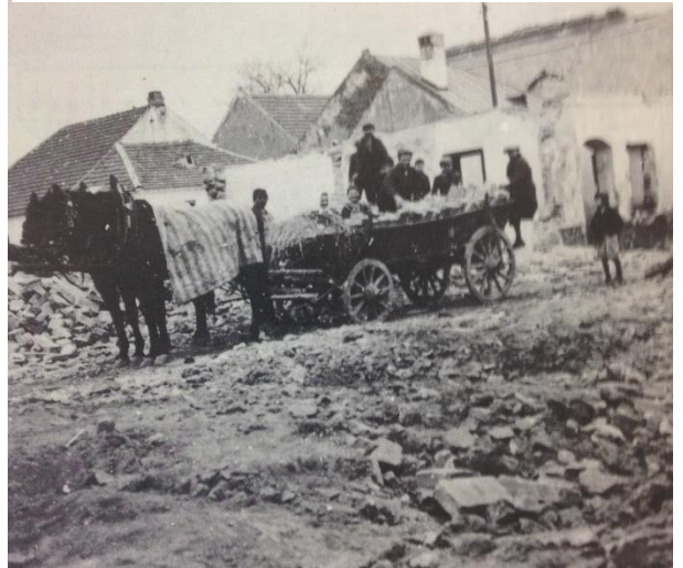
Abbildung 46 Synagoge während des Abbruchs [14]
