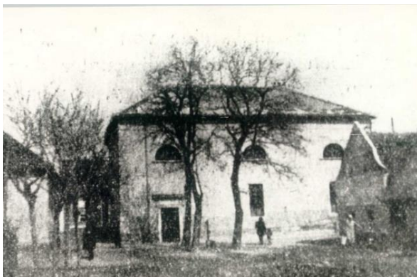
Abbildung 41 Synagoge während des Abbruchs [8]
