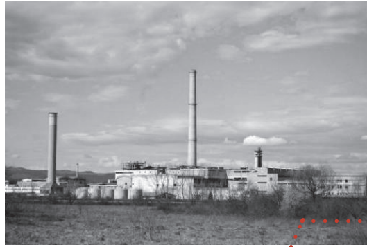
Abb.44 Alte Fabrik Incel
