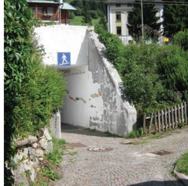
15: nicht barrierefreie Unterführung
