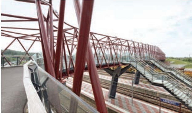
46: Überbrückung Bahnhof Aarschot (Belgien)
