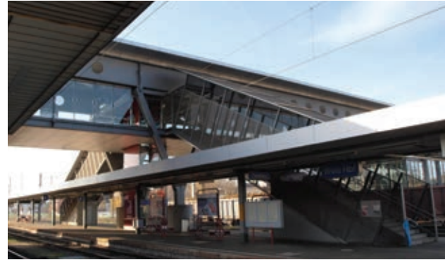
47: Überbrückung Bahnhof Wels
