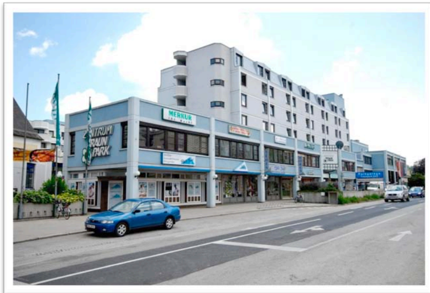
Abbildung 5 Ansicht Adlerstraße, Ansicht Hotel, Foto conwert Immobilien
