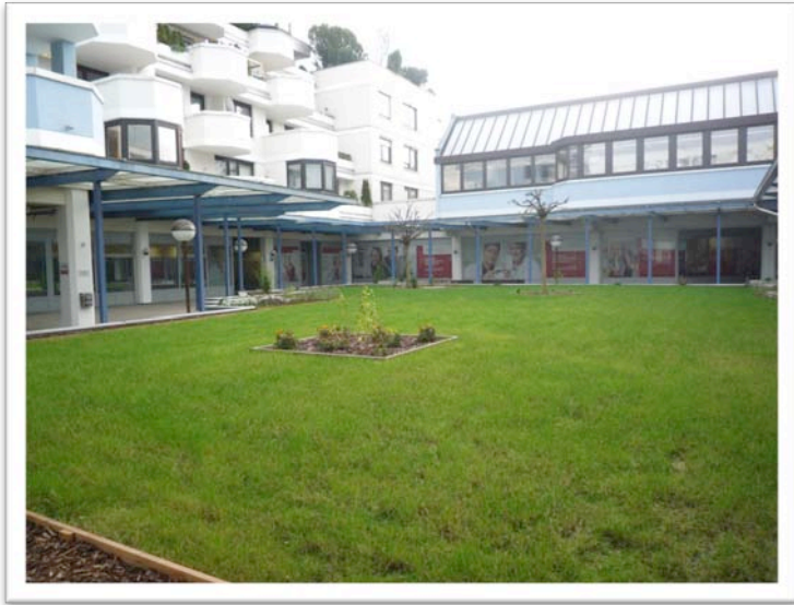
Abbildung 22 Nach Sanierung, Ansicht FH Wels, Foto Anwander
