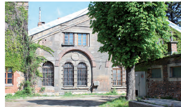
Abb. 69 Foto der Gösserhalle (Quelle: Wessendorf, 2011, S. 25)
