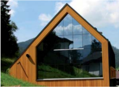
Abb.88: verspiegeltes Glas im Saunabereich
