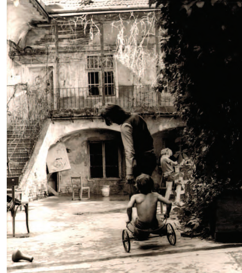
Ab.04.24 Der Hof des Amerlinghauses zur Zeit der Besetzung
