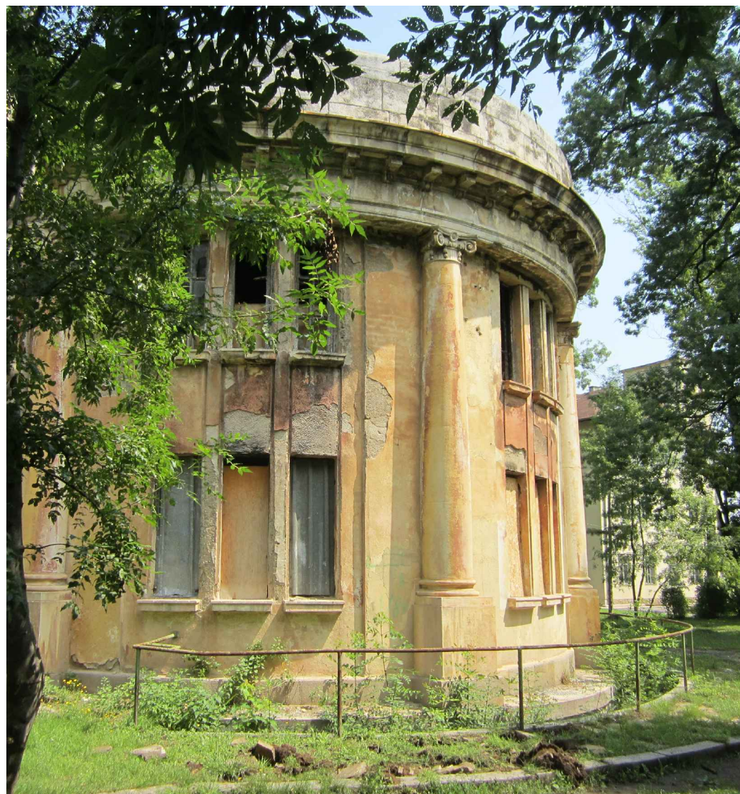
Abb. 36 | Südwestseite des Bades
