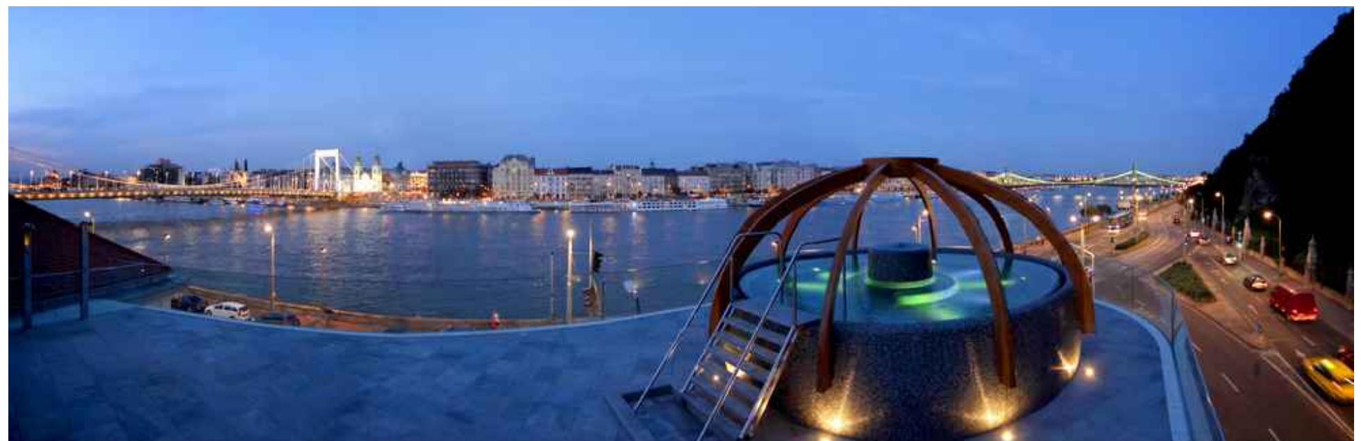
Abb. 73 | Dachterrasse auf dem neuen Zubau
