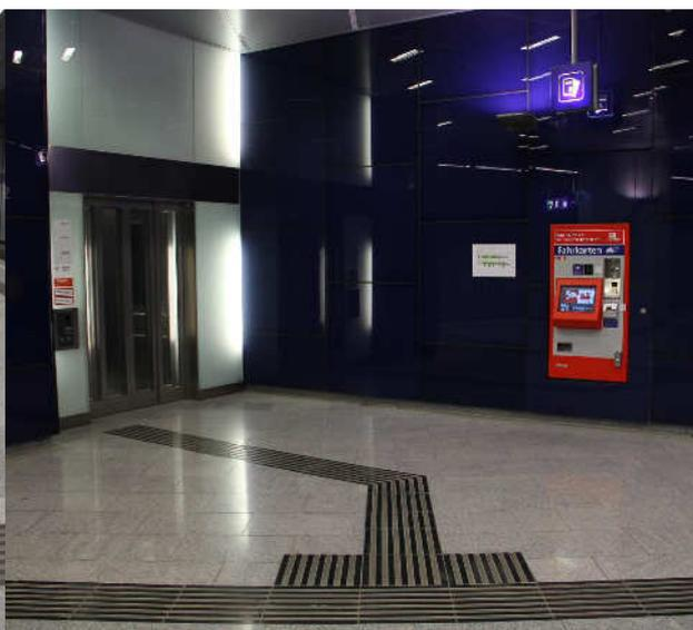
Abbildung 64: Blindenleitsystem zum Aufzug, Bahnsteig S-Bahn
