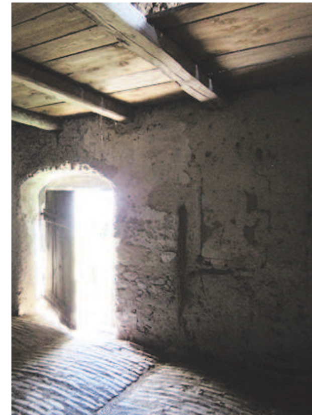
Abb. 5.84 Rechts im Bild ist eine zugemauerte Fensteröffnung in der Ostwand erkennbar
