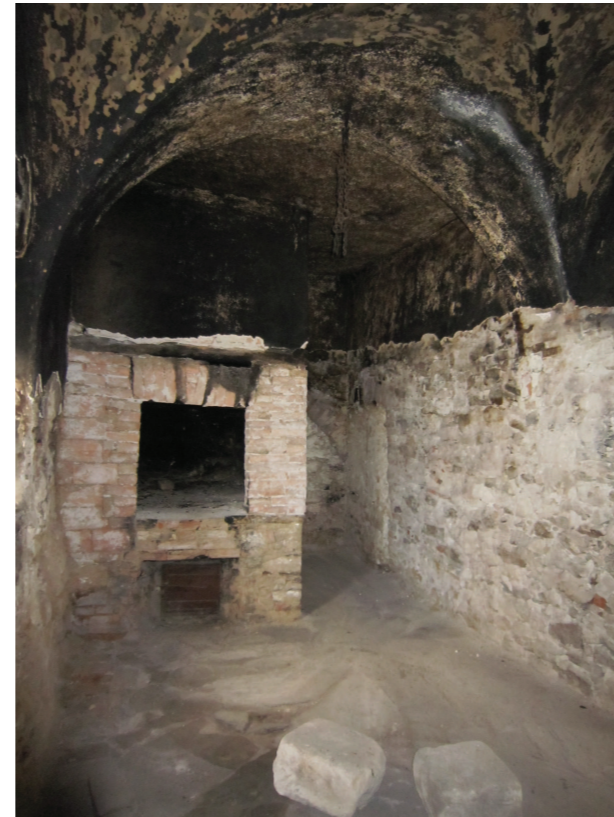
Abb. 5.65 Raum A.1.04 Blickrichtung Nord-Ost
