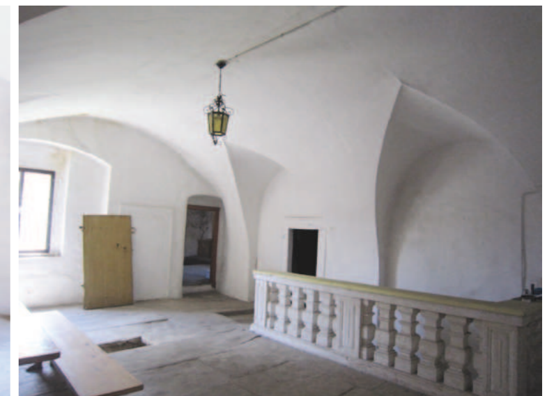
Abb. 5.52 Raum A.1.01 Blickrichtung Süd-West
