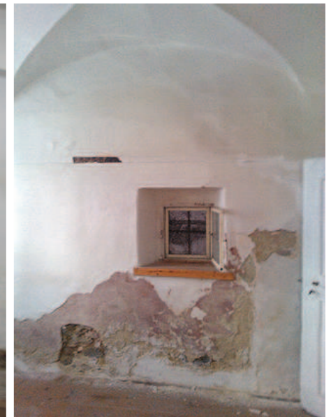
Abb. 5.16 Öffnung in der Ostmauer, darüber ist das Metallband sichtbar
