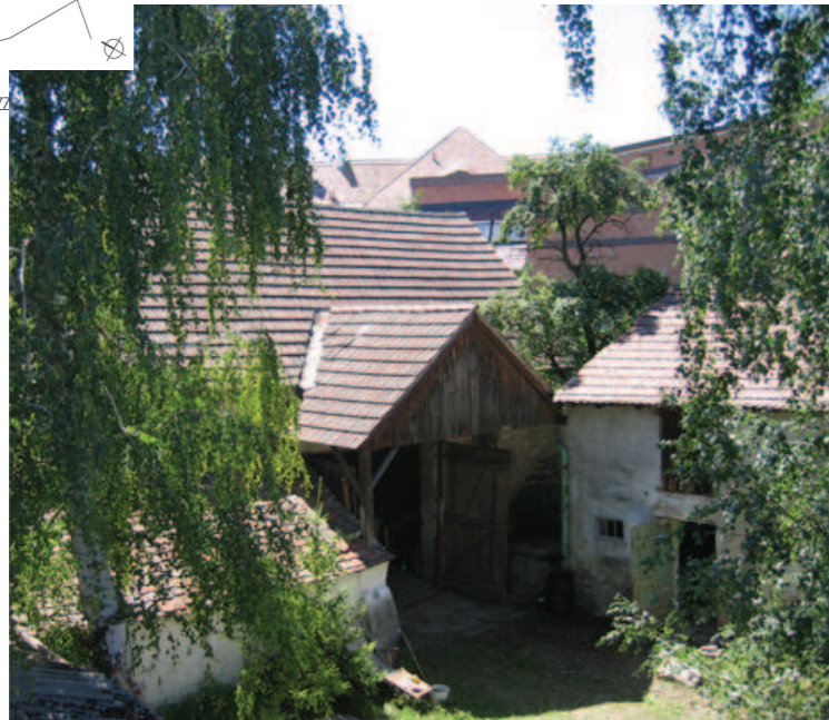
Abb. 5.115 Innenhof Ansicht Gebäude C und B
