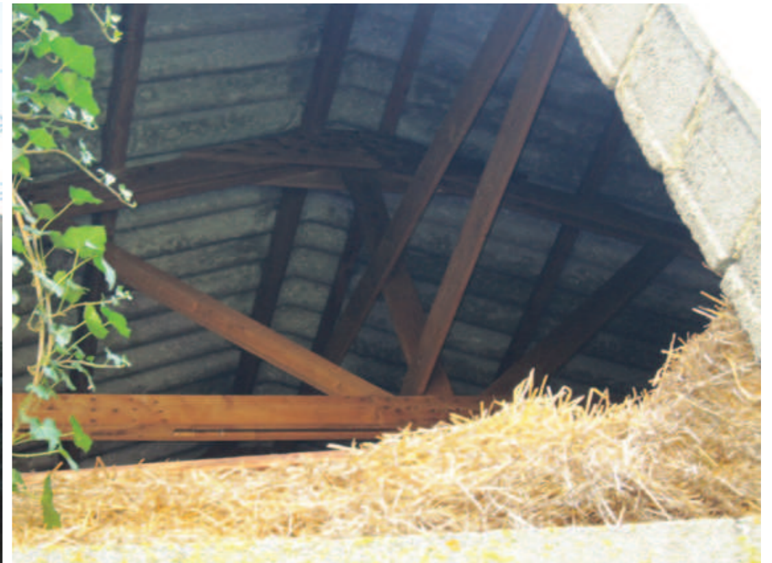
Abb. 5.134 Dachstuhlkonstruktion in Raum D.1.01
