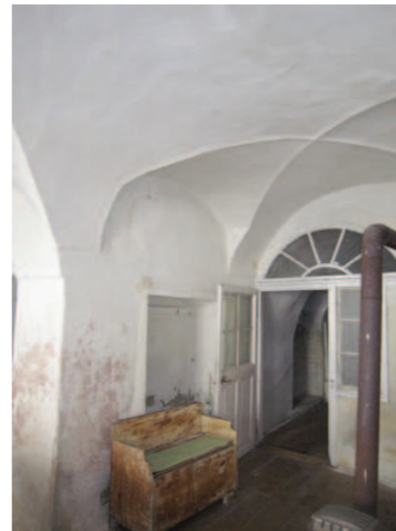
Abb. 5.14 Kassettentür mit rundbogigem Oberlicht
