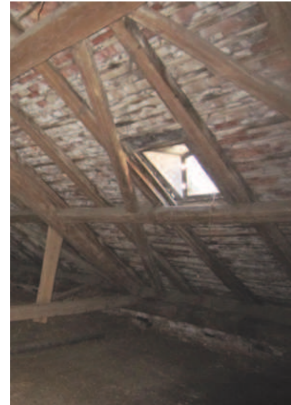
Abb. 5.92 Metallgaube in der nördlichen Dachfläche
