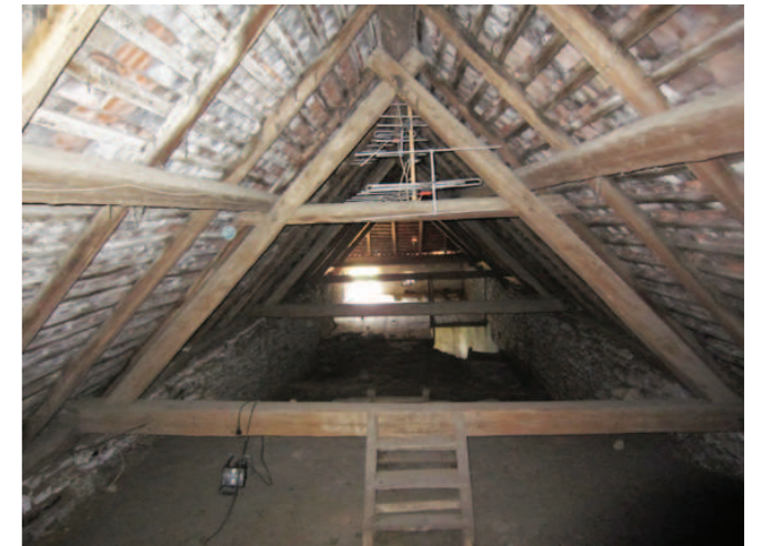
Abb. 4.16 Dachgeschoss Raum A.2.02 Blickrichtung Süd-Ost
