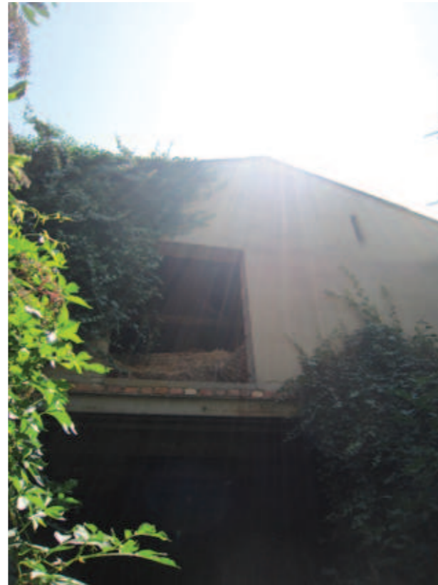
Abb. 5.133 Gebäude D Nordfassade
