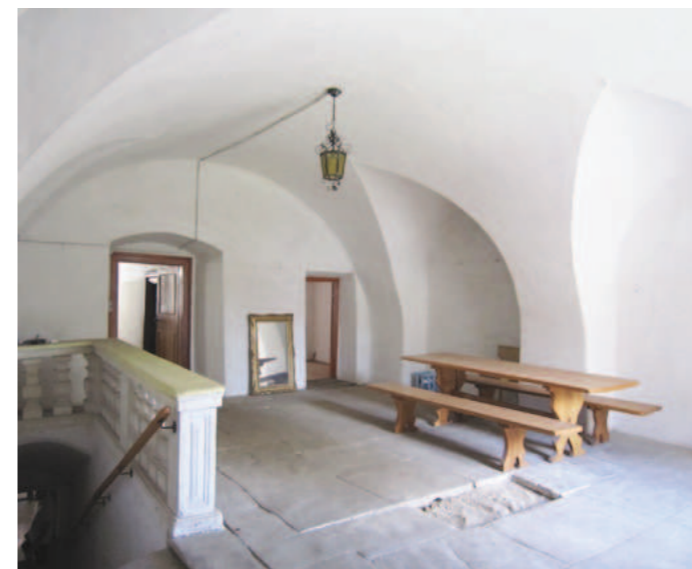
Abb. 5.51 Raum A.1.01 Blickrichtung Nord-Ost
