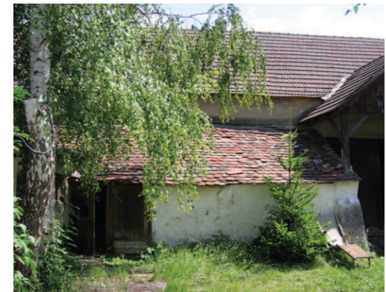
Abb. 4.19 Zubau der Scheune im Norden
