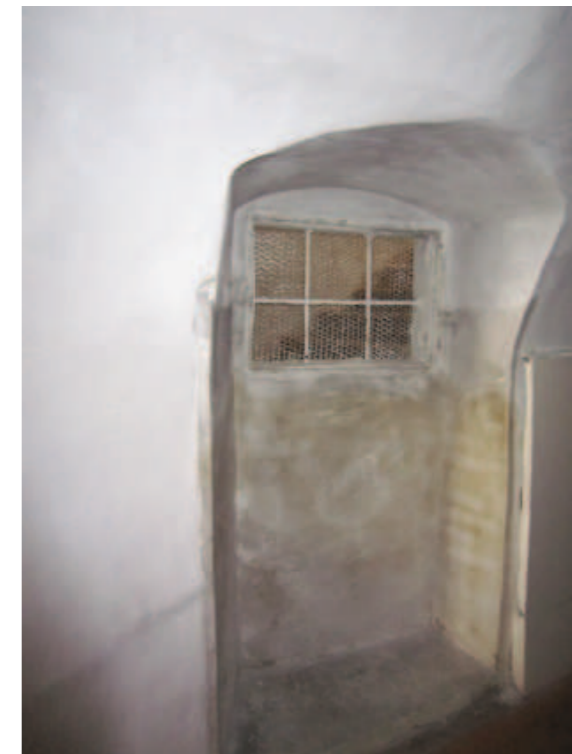
Abb. 5.19 Nische mit rechteckiger Öffnung in der Ostmauer
