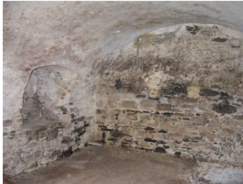
Abb. 5.36 Raum A.-1.01 Blickrichtung Süd-Ost, in der Ostwand ist die zugemauerte Öffnung erkennbar
