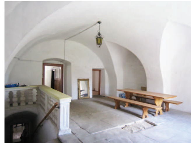
Abb. 4.14 Halle im Obergeschoss Raum A.1.01 Blickrichtung Norden
