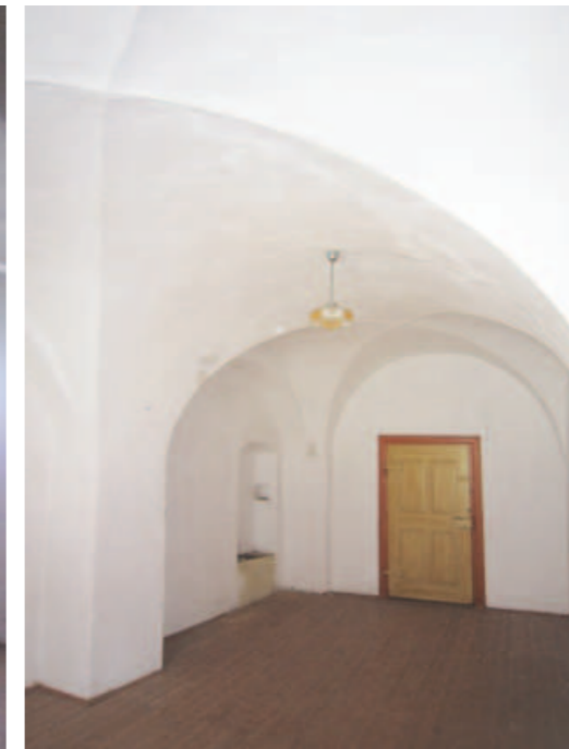
Abb. 5.63 Raum A.1.03 Blickrichtung Süd-Ost
