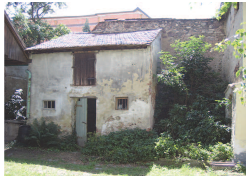
Abb. 5.102 Gebäude B Fassadenansicht
