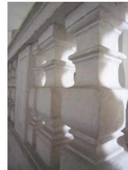
Abb. 5.50 Balustrade in Raum A.1.01
