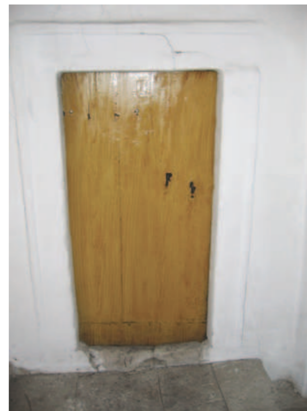
Abb. 5.67 Zugang zu Raum A.1.04
