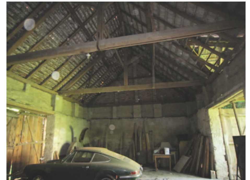
Abb. 5.125 Raum C.0.01 Blickrichtung Westen
