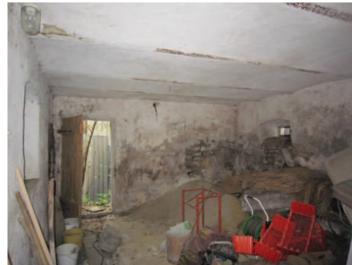
Abb. 5.41 Raum A.0.07 Blickrichtung Süd-West
