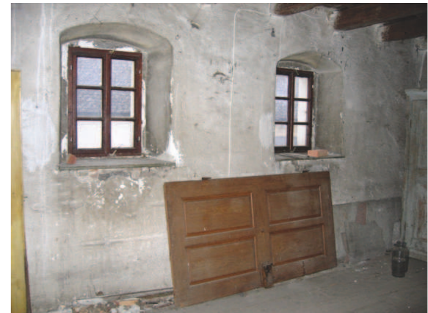
Abb. 5.73 Fensteröffnungen in der Ostwand
