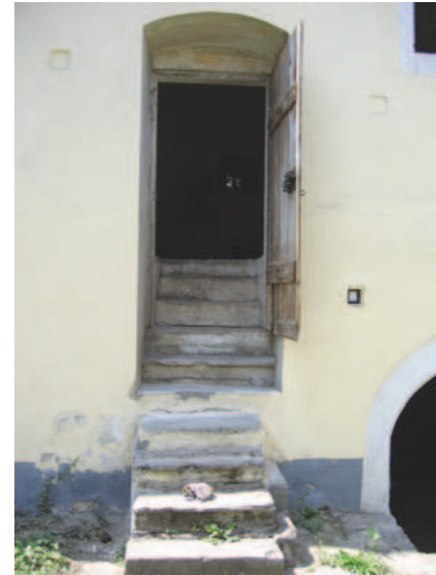
Abb. 5.78 Zugang zu Raum A.1.06
