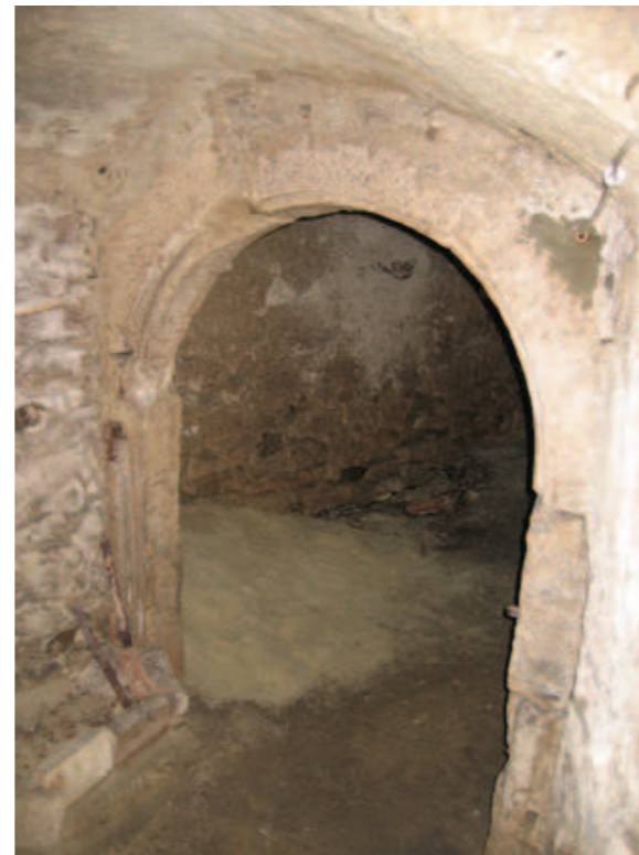
Abb. 5.120 Rundbogenportal, Zugang zu Raum C.-1.01
