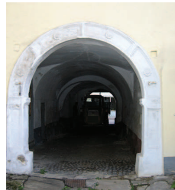
Abb. 5.07 Profiliertes Sandsteingewände der Toröffnung zum Innenhof
