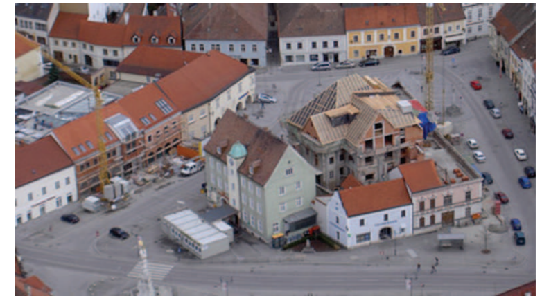
Abb.7.17 Das "Grätzl" während der Bauarbeiten
