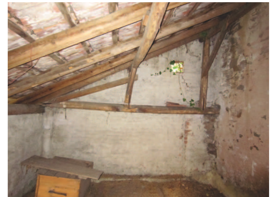
Abb. 5.113 Raum B.1.01 Blickrichtung Süden
