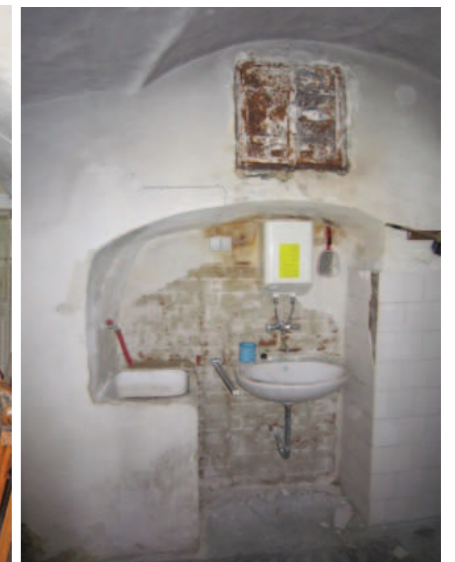
Abb. 5.21 Nische in der Südmauer, darüber die Öffnung des südlichen Kaminzuges
