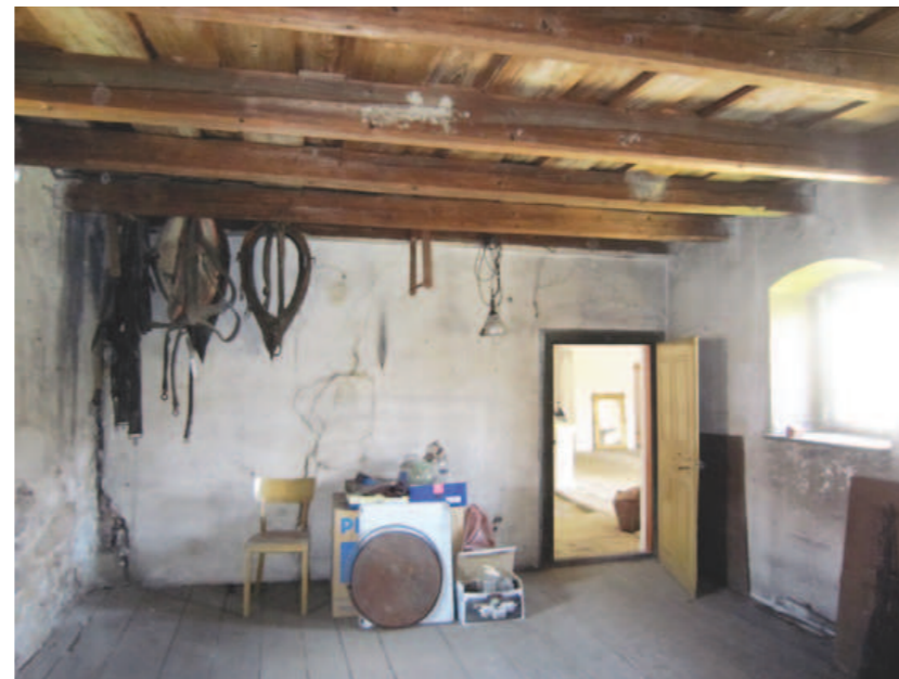
Abb. 5.74 Raum A.1.05, Blickrichtung Norden
