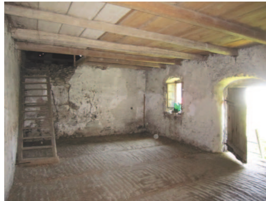
Abb. 5.85 Raum A.1.05, Blickrichtung Nord-Ost
