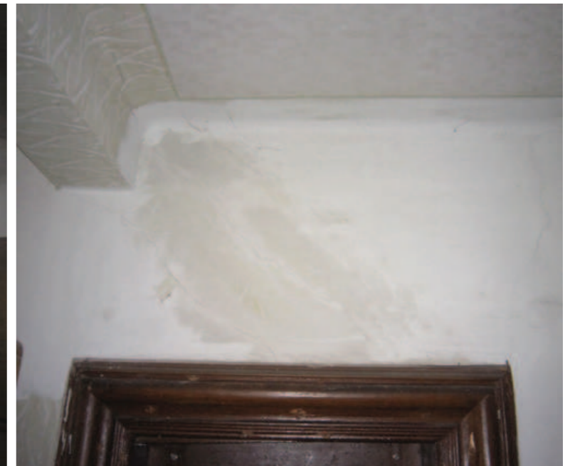
Abb. 5.58 Rissbildung in der Ostmauer über der Tür zu Raum A.1.03
