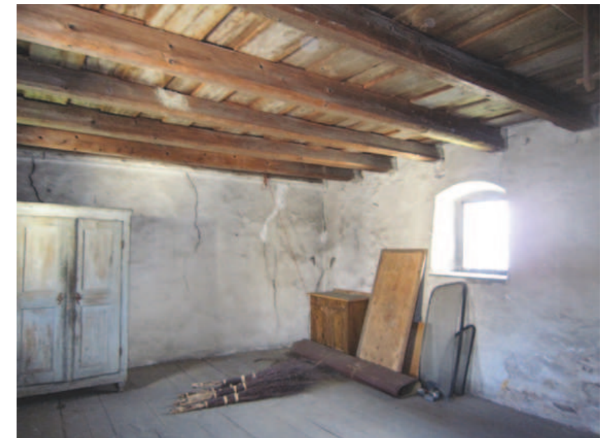
Abb. 5.75 Raum A.1.05, Blickrichtung Süd-West
