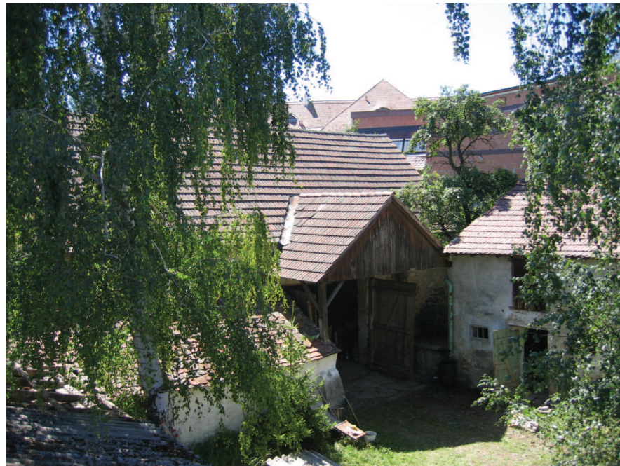
Abb. 4.20 Blick in den Innenhof auf die Scheune mit Vordach
