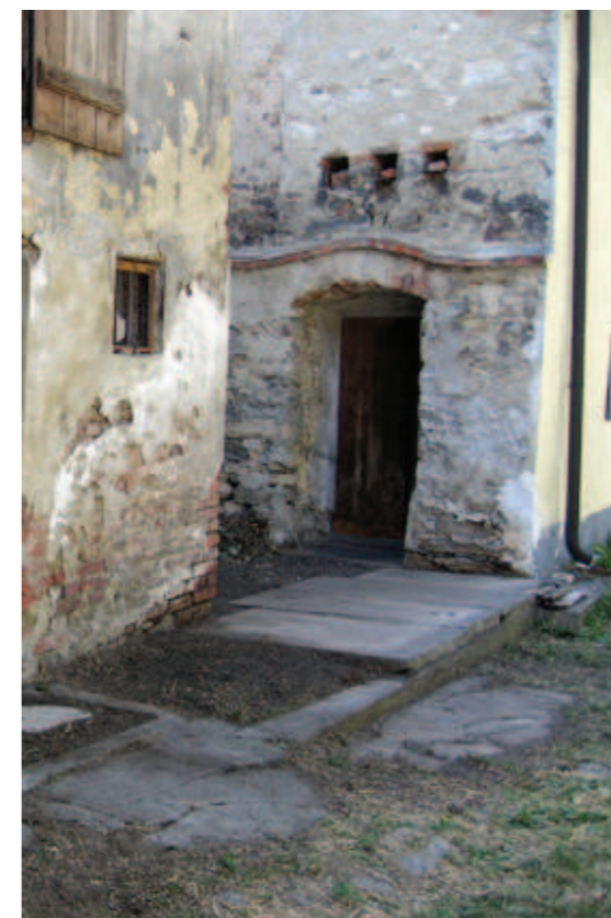
Abb. 5.40 Zugang zu Raum A.0.07 in der Südwand
