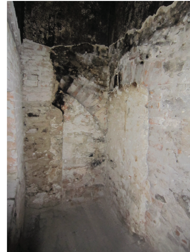
Abb. 5.69 Inhomogenes Mauerwerk der Nord- und Ostwand
