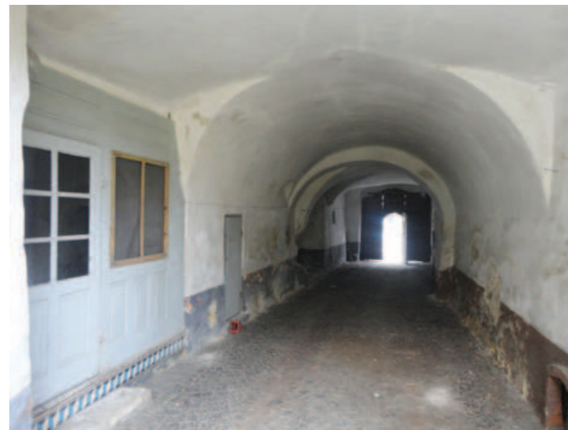
Abb. 5.08 Raum A.0.01 Blickrichtung Nord-West
