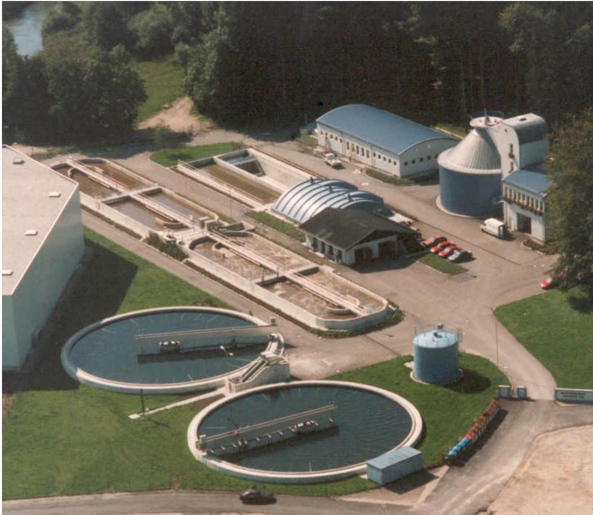
Abbildung 3: Verbandskläranlage des RHV Wallersee-Süd (In der linken oberen Bildecke: der Vorfluter, die Fischach)
