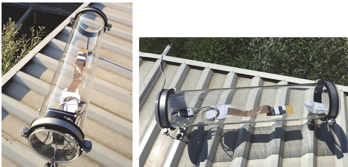
Abbildung 43: Messaufbau am Dach der Station (Foto: Autor)
