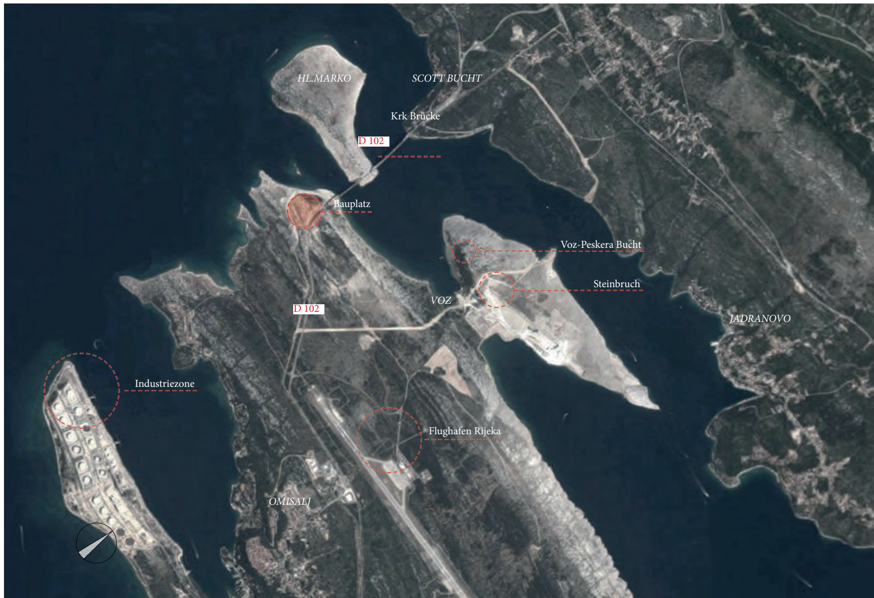
Abb.38 Überblick - Bauplatz Umgebung
