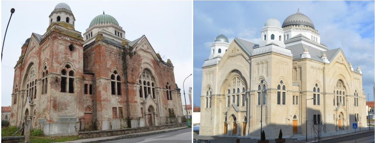
Abb. 21 - Vergleich der Synagoge in Lučenec 2014 (links) und 2017 (rechts) - Außen
