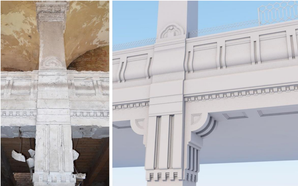
Abb. 67 - Brüstung der Empore
