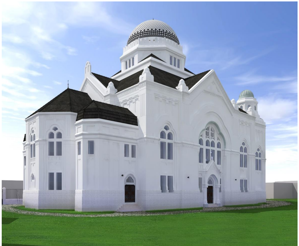
Abb. 98 - Gartenseite - Blickrichtung Südwest
