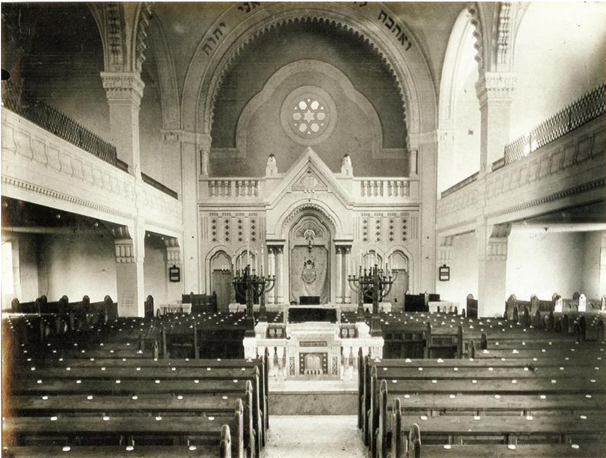
Abb. 14 - Innenraum der Neuen Neologischen Synagoge (Blickrichtung Ost)
