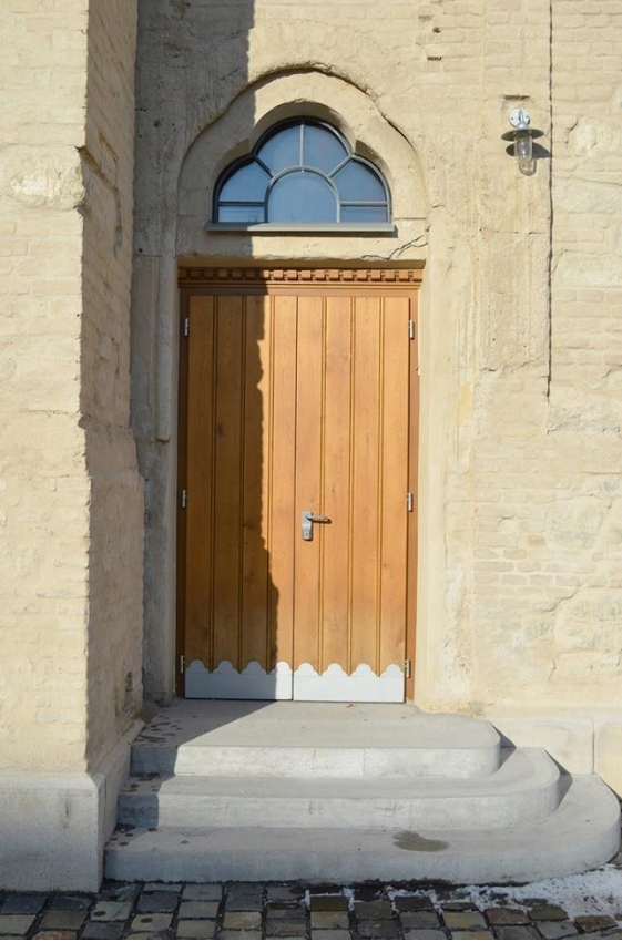
Abb. 116 - Eingang Treppenhaus Ostseitig (2017)
