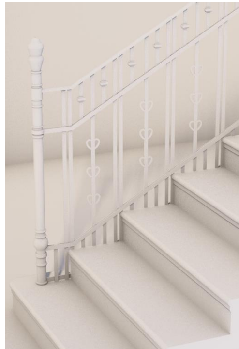
Abb. 80 - Weststiege Geländer Rekonstruiert
