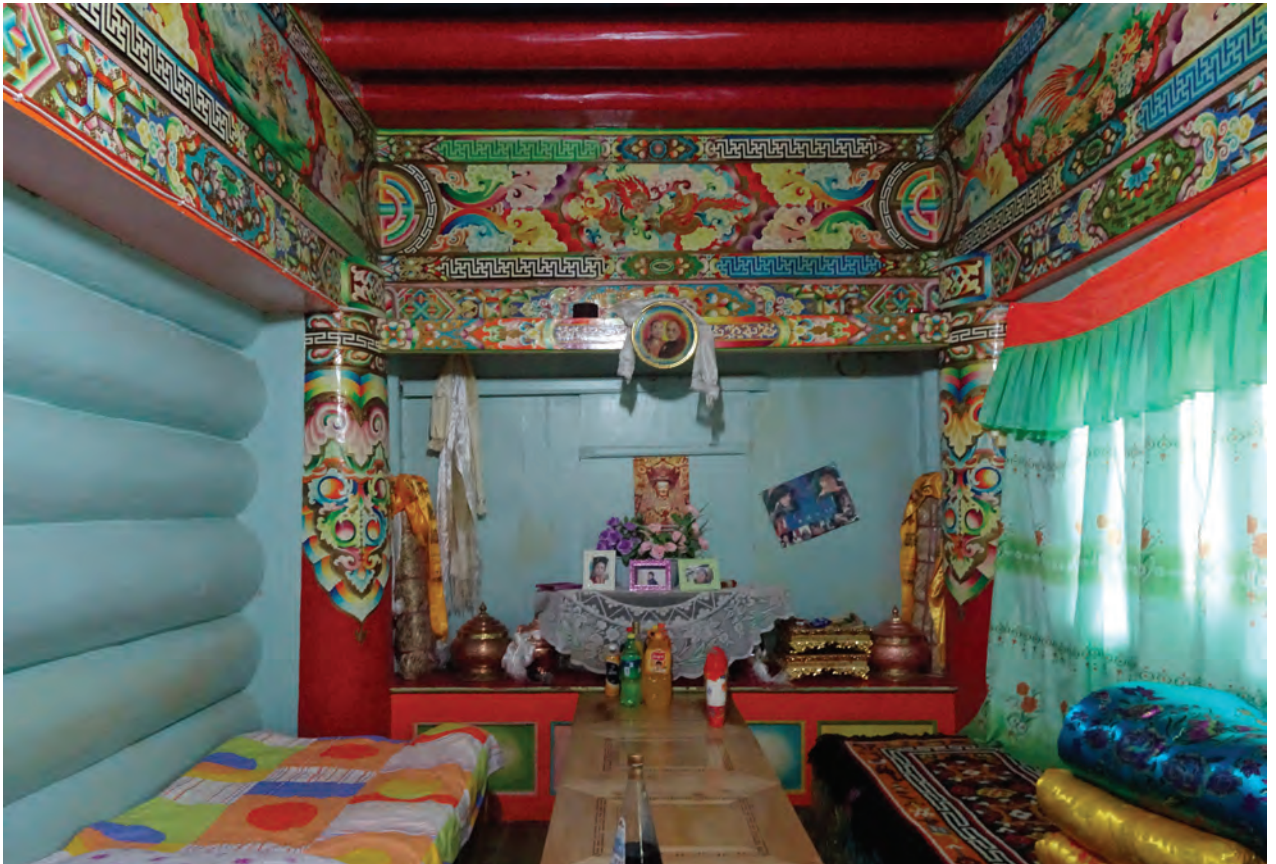
Abb. 144 Verzierungen im Inneren des Hauses. Der Fokus liegt auf den Hauptelementen der Tragstruktur. Die Träger sind mit aufwendigen Bildern und Mustern Handbemalt. Haus Yalo bei Dawu.
