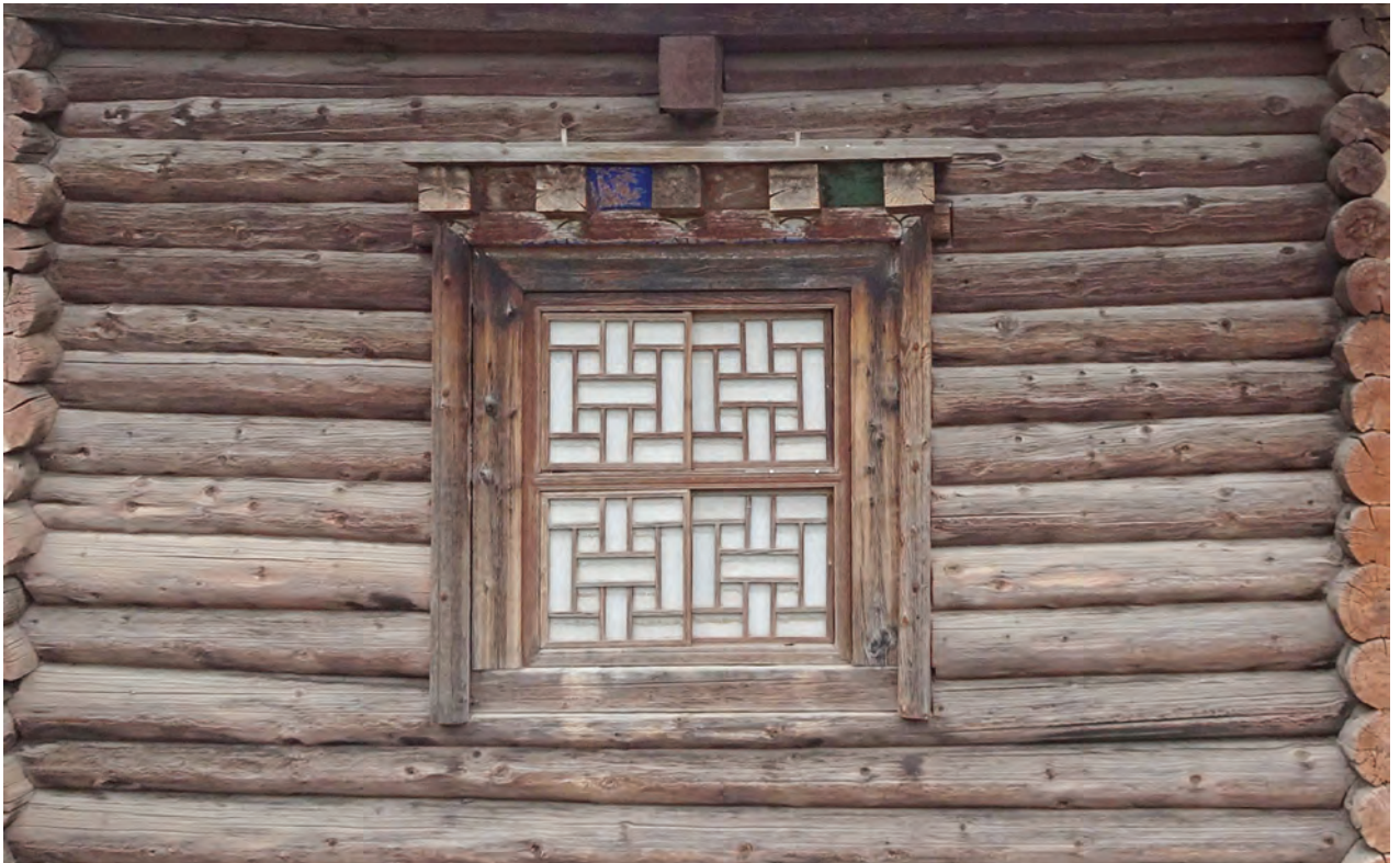
Abb. 119 Außenfenster beim Haus der zwei Schwestern, Landkreis Derge
