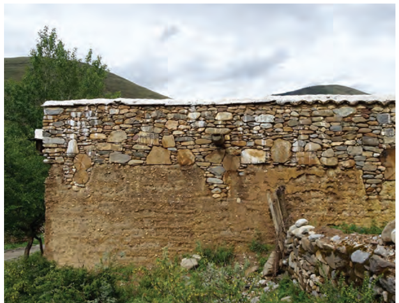
Abb. 105 und 106 Geschlossene Nordfassade mit einem Materialmix aus Stampflehm und Naturstein. Häuser im Dorf Chüpshey bei Dawu.
