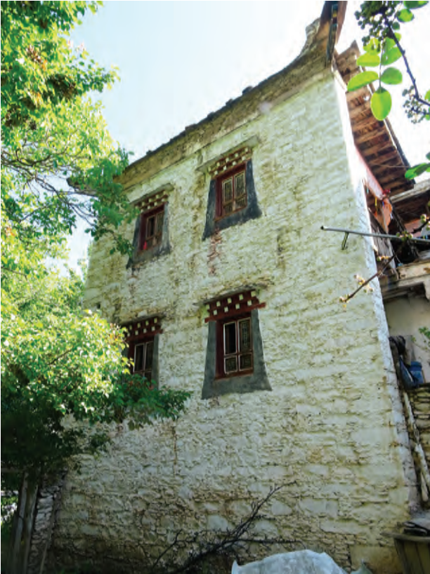
Abb. 133 Fassade aus Naturstein. Die Fenster tragen das typische Fries mit den kleinen quadratischen Holzquerschnitten und ein Vordach. Die Schwarze Umrandung lassen sie massiver wirken.
