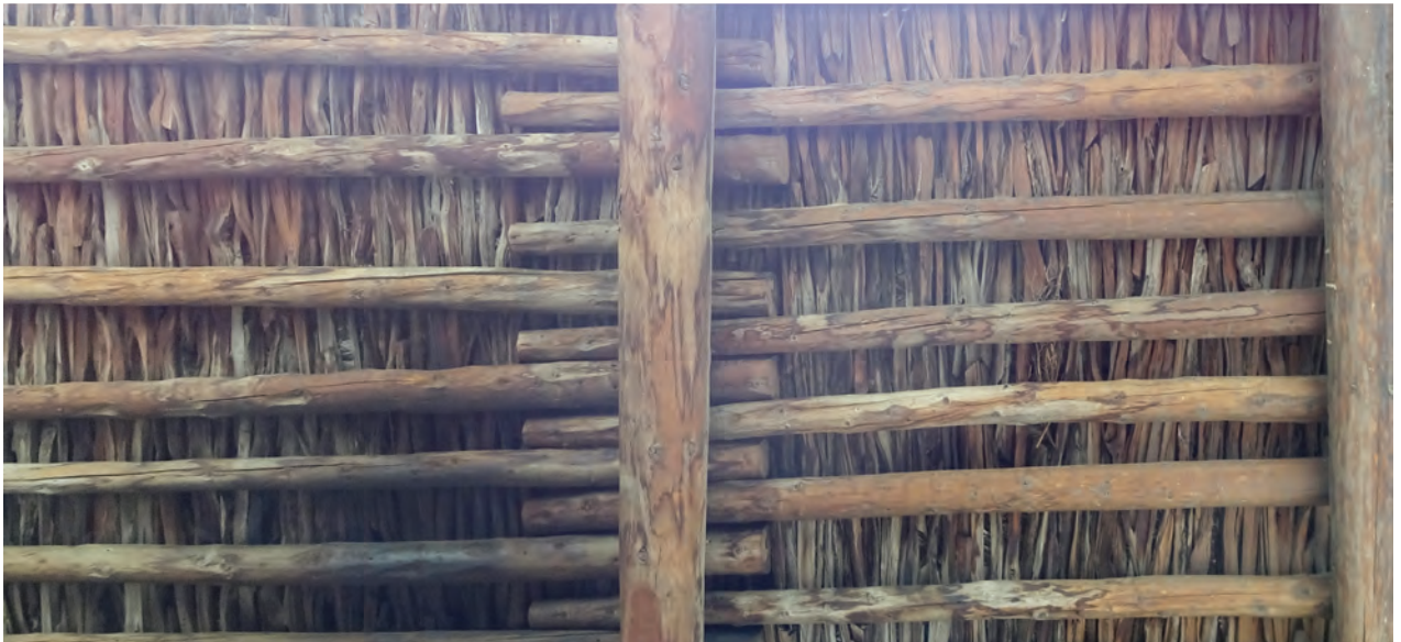
Abb. 128 Dachuntersicht. Ein Baum in seiner kompletten Verarbeitung. Haus der zwei Schwestern bei Derge.
