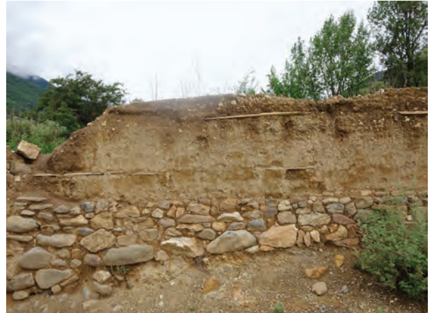
Abb. 139 und 140 Der Wandaufbau zeigt die Schichten einer Stampflehmwand auf einem Steinfundament. Zwischen den Lehmschichten sind Holzbretter eingelegt, die der Stabilität dienen. Ruine am Dorfrand von Chüpshey bei Dawu.
