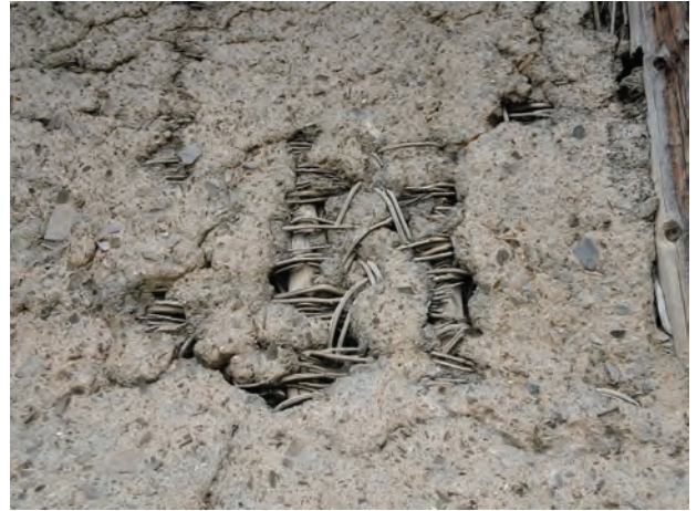
Abb. 127 Hauswand mit geflochtenen Ruten und Lehmerde. Haus der zwei Schwestern bei Derge.
