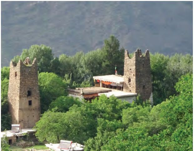
Abb. 30 Das untersuchte Haus in Zhonglu ist direkt an einen Turm gebaut.
