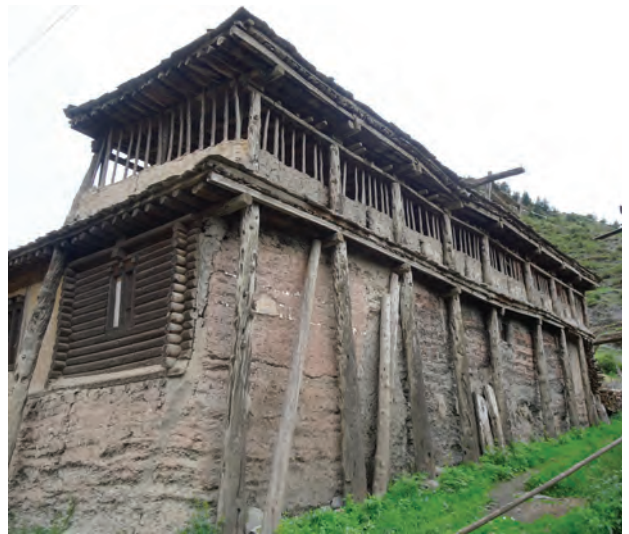
Abb. 124 An der Nordfassade ragen Holzstützen über alle drei Geschosse und tragen das Dach. Haus der zwei Schwestern bei Derge.
