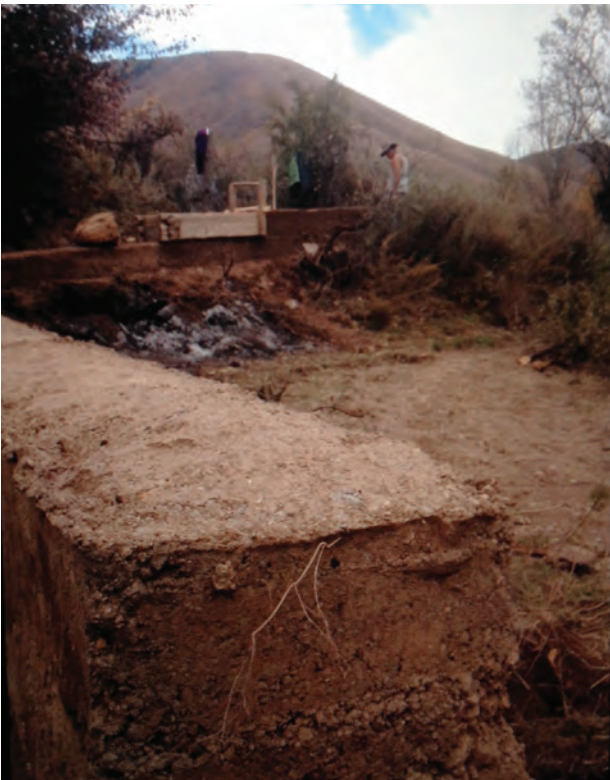
Abb. 141 Herstellung der Stampflehmwand. Dorf Chüpshey bei Dawu.
