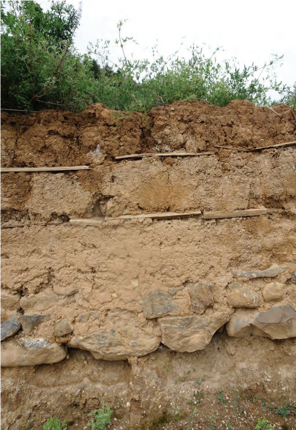
Abb. 139 und 140 Der Wandaufbau zeigt die Schichten einer Stampflehmwand auf einem Steinfundament. Zwischen den Lehmschichten sind Holzbretter eingelegt, die der Stabilität dienen. Ruine am Dorfrand von Chüpshey bei Dawu.
