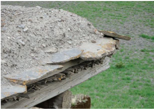
Abb. 142 Die Schieferplatten schützen die Holzkonstruktion vor Feuchtigkeit. Die dicht gepresste Erde bildet die wasserdichte Schicht. Haus der zwei Schwestern bei Derge.
