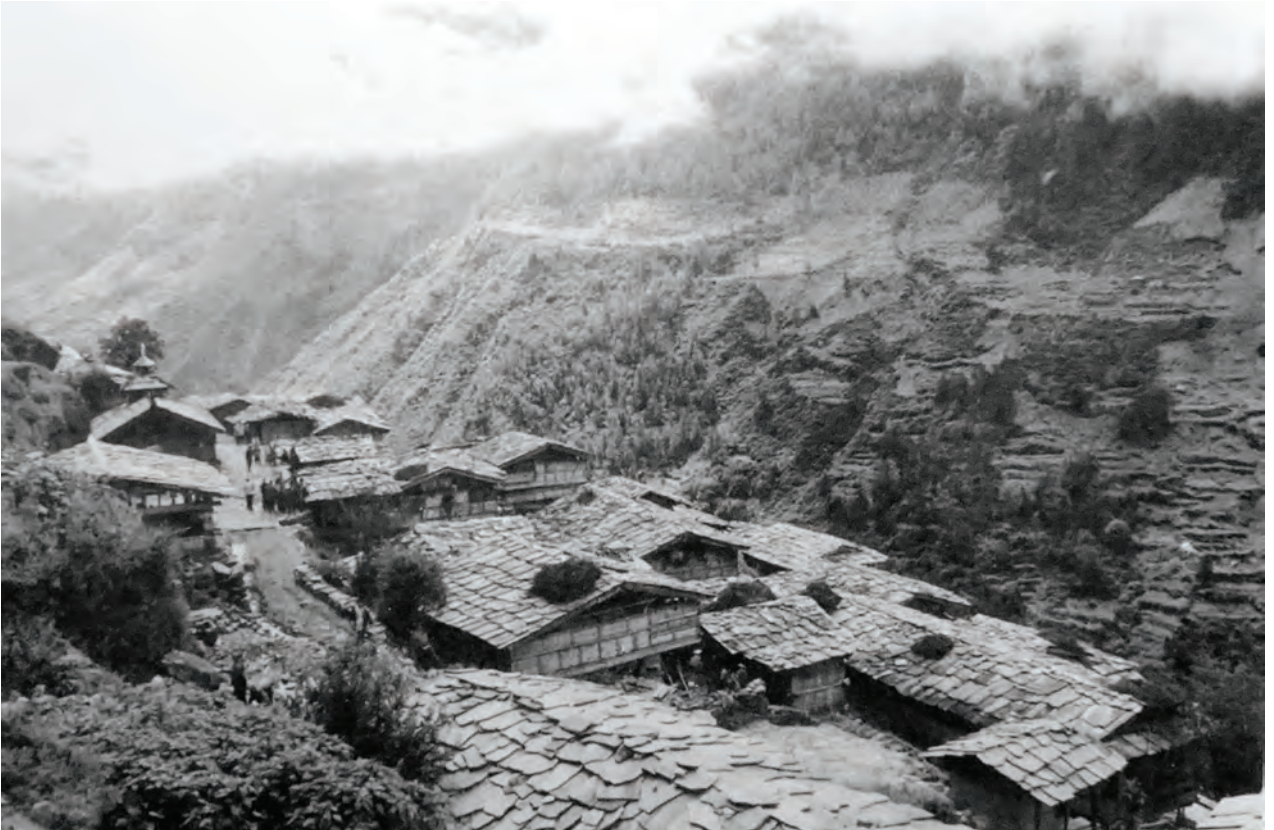
Abb. 46 „Khash“-Dorf in Har-ki-Doon, Uttarkashi (Indien). Steinplatten als Dachdeckung. (Handa 2008: Abb. 71.)
