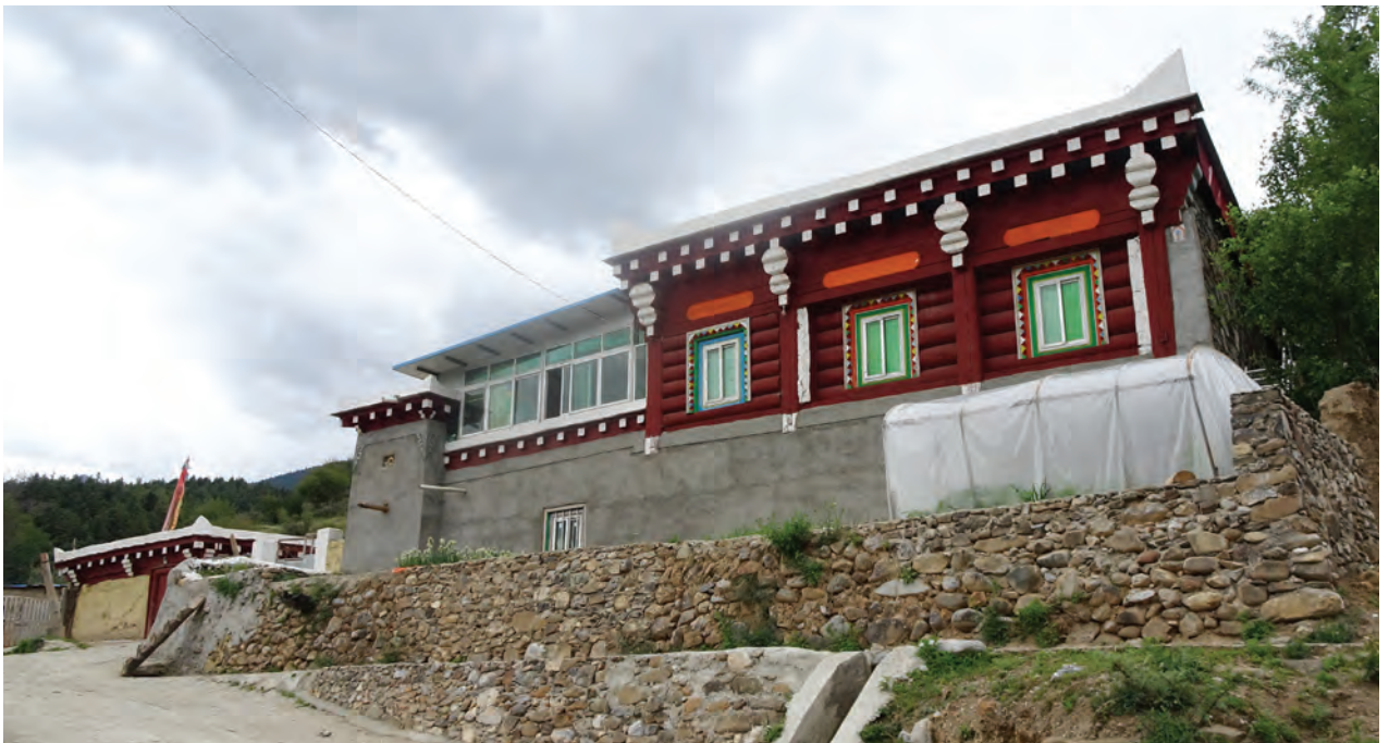
Abb. 40 Haus Yalo bei Dawu. Vergleichbar mit den Mönchswohnungen in Derge, sieht man auch hier die weiß gestrichenen Holzbalkenquerschnitte entlang der Attika.
