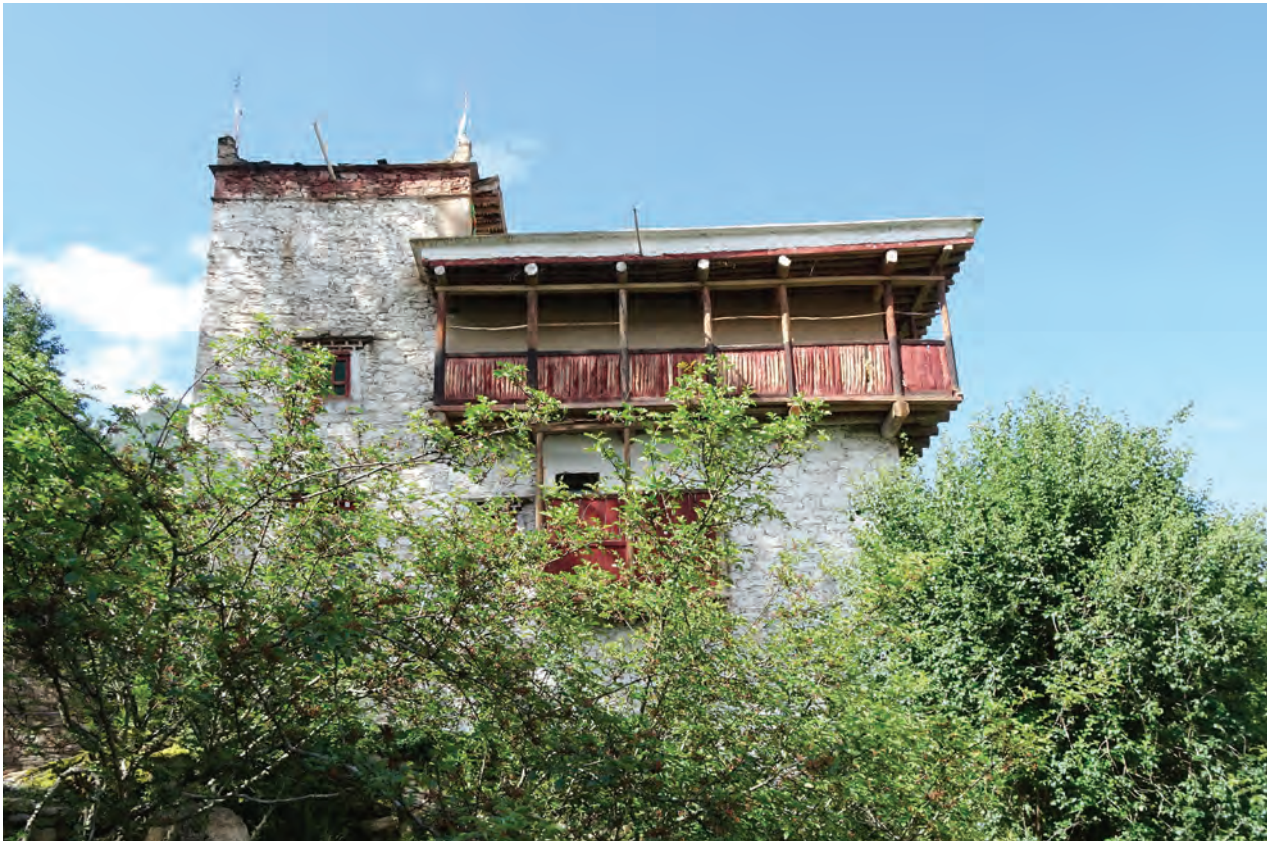
Abb. 136 Der offene Seitenanbau ist als Laubengang ausgeführt und kann um das gesamte Geschoss reichen. Haus in Zhonglu bei Danba.
