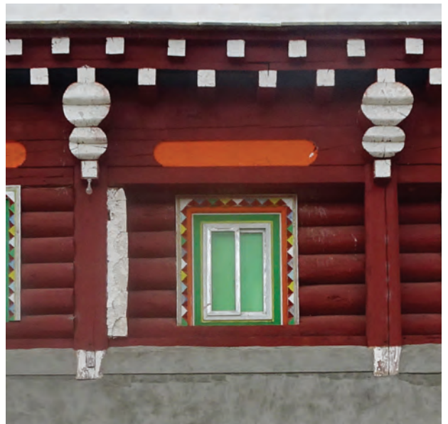
Abb. 146 Die horizontal verlaufenden Verzierungen am Dachabschluss sollen den Übergang von Wand und Himmel artikulieren. Dazu sind die Enden der Holzträger weiß angemalt. Haus Yalo bei Dawu.
