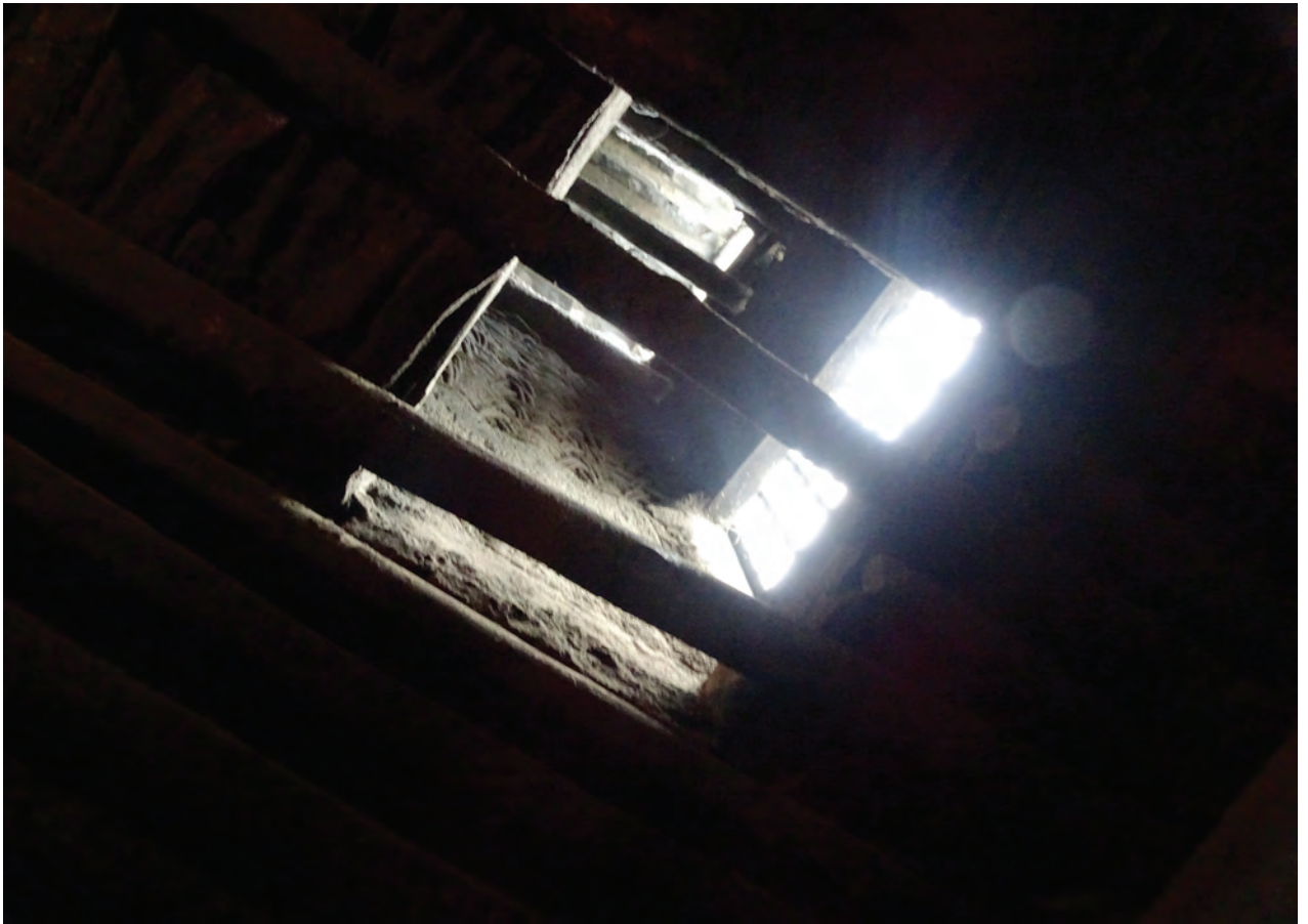
Abb. 122 Blick in den Kamin. Die seitliche Öffnung dient als einzige Lichtquelle im Raum. Haus der zwei Schwestern bei Derge.
