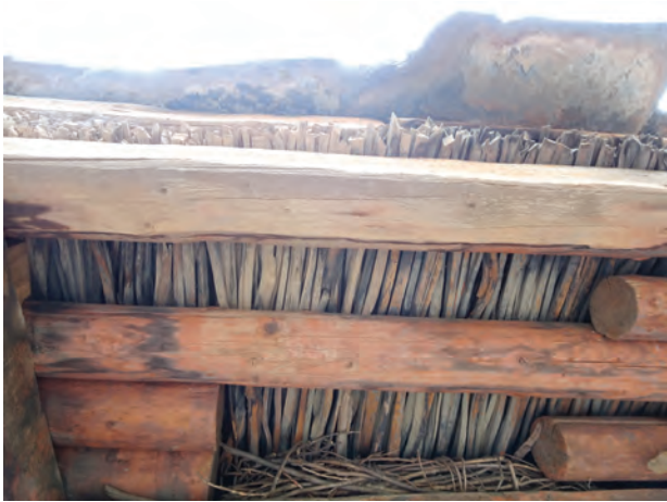
Abb. 126 Untersicht des seitlichen Dachüberstands. Dicht gebündelte Äste und Sprießen auf Holzbalken bilden die Decke. Haus der zwei Schwestern bei Derge.
