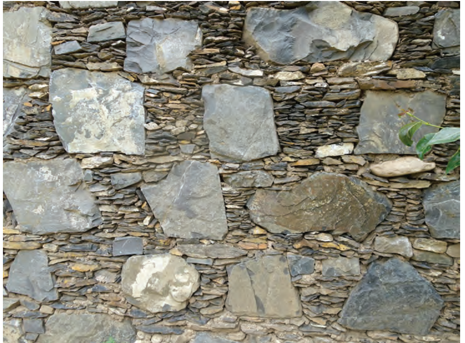
Abb. 131 Gemauerte Wand als zweite Schale der Nord- und Westfassade. Haus Yalo bei Dawu.
