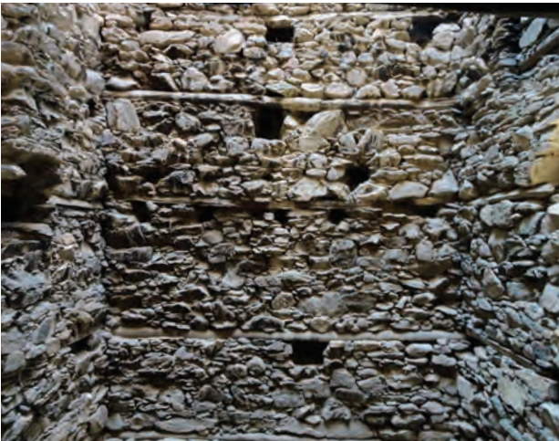
Abb. 29 Blick in den Turm. Die horizontalen Holzlatten dienen zur Aussteifung des Turms.
