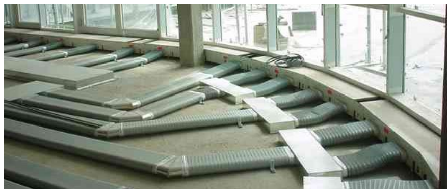
Abb.78. Frischluftzufuhr zum Bodenkonvektor ©Forum Heizkonvektoren
