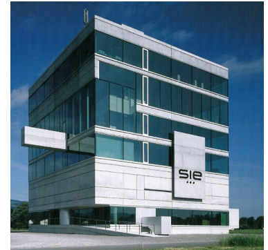
Abb.46. Gebäude von Außen mit ausragendem Balkon im 3. OG ©Marte.Marte Architekten
