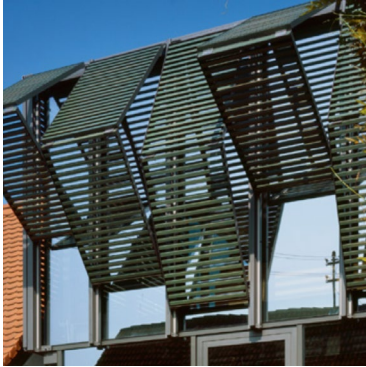
Abb.84. Horizontale Faltläden ©Fa. Hilbra
