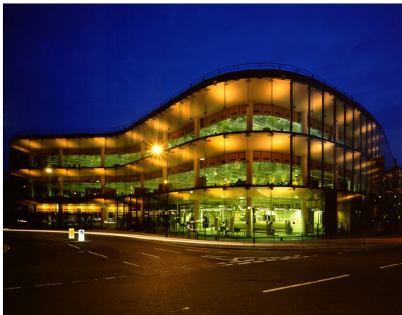
Abb.15. Außenansicht Dumas-Gebäude, Ipswich, England Norman Foster, 1978 ©Hascher/Jeska/Klauck
