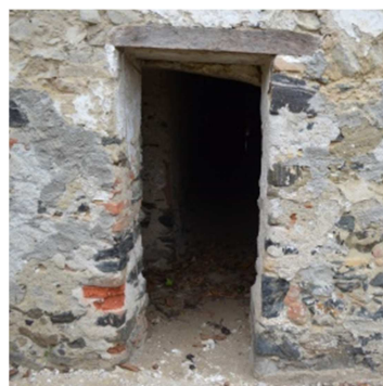
Abb. A.0.01.3 Zugang Straße, Blick hofseitigen Zugang zum Durchgang (Eigenaufnahme vom 08.12.2015 )
