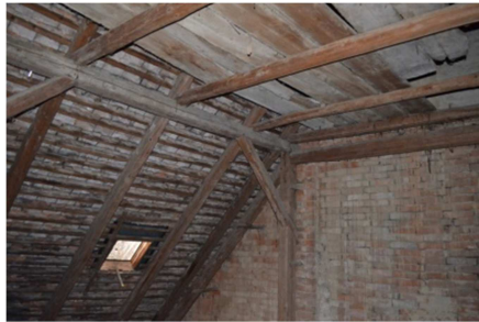
Abb. A.2.01.2 Dachboden, Feuermauer zum Nachbargrundstück, Bereich über den Räumen A.1.06 und A.1.06 (Eigenaufnahme vom 08.12.2015)
