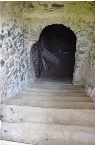
Abb. A.0.08.2 Abgang Kellerhalle, Stiegenabgang (Eigenaufnahme vom 27.08.2016)
