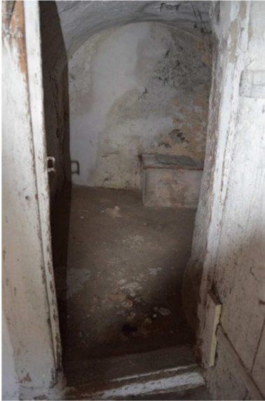
Abb. A.1.06.1 Abort, Zugang (Eigenaufnahme vom 27.08.2016)
