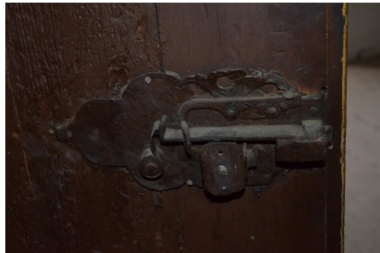
Abb. A.1.03.5 Zimmer, Detailaufnahme Beschläge der Renaissancetür (Eigenaufnahme vom 08.12.2015)
