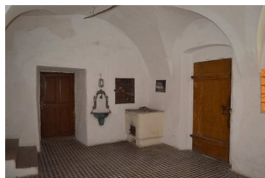
Abb. A.1.02.2 Vorhaus, Stichkappentonne, Zugänge zu Raum A.1.08 (linke Tür) und A.1.01 (rechte Tür) (Eigenaufnahme vom 27.08.2016)
