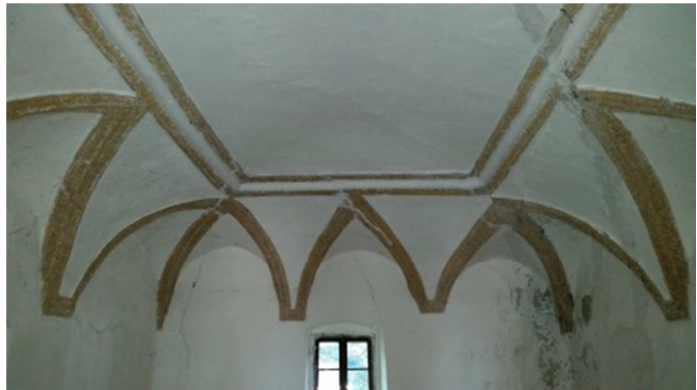
Abb. 3.5 (oben) Raum A.1.04 ehemalige Kapelle, gemauerte Wölbung der Kapellendecke mit Ornamentmotiv einer vergoldeten Eierstabbordüre in Prägestucktechnik
