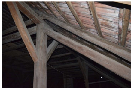
Abb. A.2.01.4 Dachboden, Detailaufnahme Dachstuhl, Stuhlsäule mit Kopfbändern in Längsrichtung sowie der Brustriegel und die Strebe in Querrichtung (Eigenaufnahme vom 08.12.2015)
