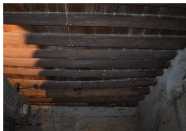
Abb. A.-1.01.3 Presskeller Rundlingdecke aus Holz (Panorama erstellt von Eigenaufnahme n vom 08.12.2015)
