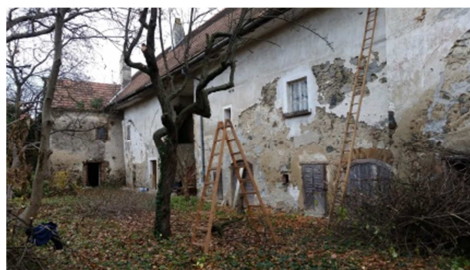
Abb. 3.16 Lesehof Mauternbach, Hoffront (Norden) mit Blick um hakenförmigen Osttrakt
