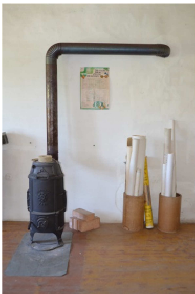
Abb. A.1.12.3 Zimmer, Detailaufnahme Ofen (Eigenaufnahme vom 27.08.2016)
