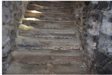
Abb. A.-2.02.2 Keller unter Keller, Detailaufnahme Steintreppe zum Raum A.-1.02 Kellerhalle (Eigenaufnahme vom 08.12.2015)
