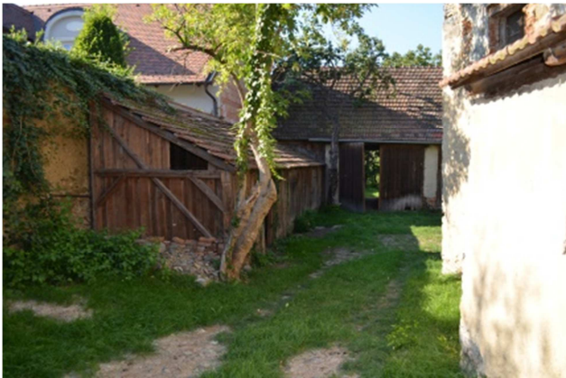
Abb. B.0.01.1 (oben) L-förmige Nebengebäude, links im Bild das Wirtschaftsgebäude aus Holz errichtet mit Pulldach (Panorama erstellt von Eigenaufnahmen vom 27.08.2016)
