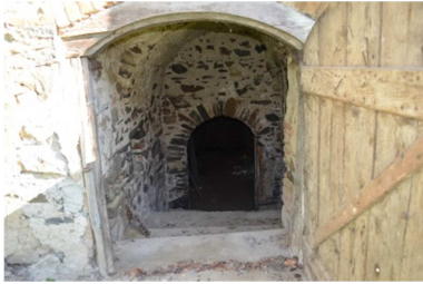
Abb. A.0.10.1 Zugang Keller (Eigenaufnahme vom 27.08.2016)
