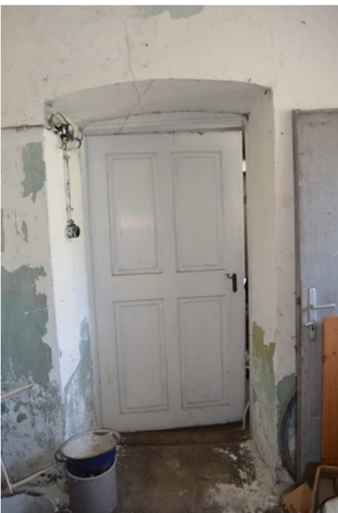
Abb. A.0.03.2 Lager, Detailaufnahme Tür zu Raum A.0.04 Zimmer (Eigenaufnahme vom 27.08.2016)
