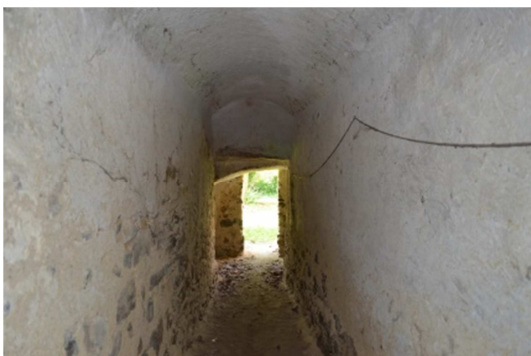
Abb. A.0.01.2 Zugang Straße, Blick zum Hof vom Durchgang (Eigenaufnahme vom 27.08.2016)
