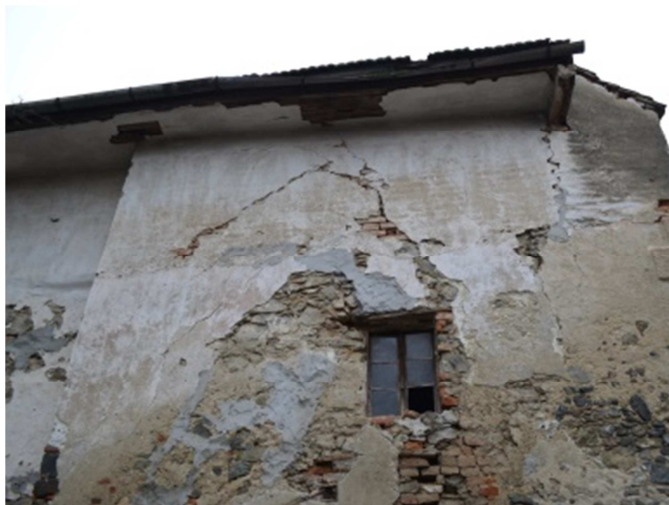
Abb. 3.26 (rechts) Raum A.1.05 Kammer, Detailaufnahme Fenster (Eigenaufnahme vom 27.08.2016)
