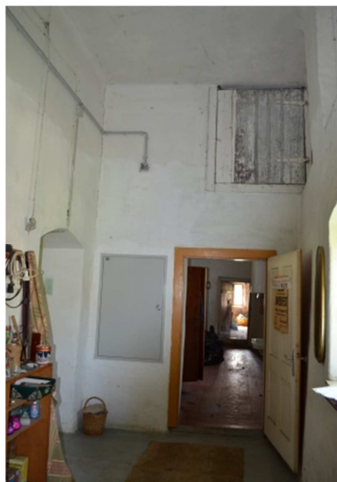
Abb. A.1.11.3 Vorraum, Blick zu Raum A.1.13 Gang (Eigenaufnahme vom 27.08.2016)
