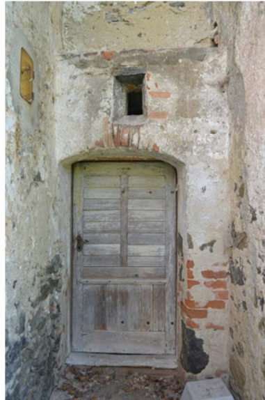
Abb. A.0.02.1 Lager, Zugang hofseitig (Eigenaufnahme vom 27.08.2016)
