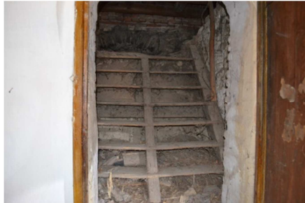
Abb. A.2.01.1 Dachboden, Zugang (Eigenaufnahme vom 08.12.2015)
