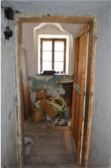
Abb. A.0.03.1 Lager, Zugang von Raum A.0.02 Lager (Eigenaufnahme vom 27.08.2016)
