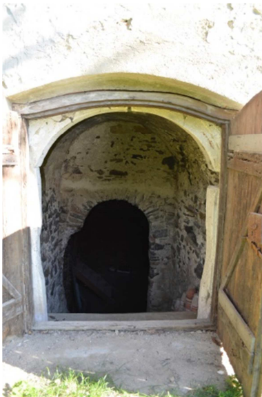
Abb. A.0.08.1 Abgang Kellerhalle (Eigenaufnahme vom 27.08.2016)
