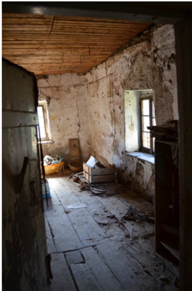
Abb. A.1.14.1 Kammer, Eingang (Eigenaufnahme vom 27.08.2016)
