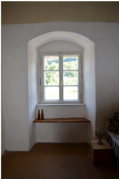
Abb. A.1.12.2 Zimmer, Detailaufnahme linkes Fenster (Eigenaufnahme vom 27.08.2016)
