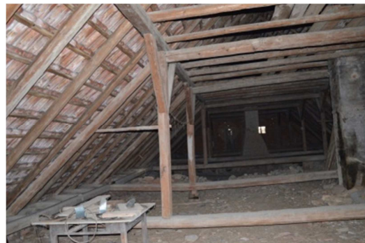
Abb. 3.21 (rechts) Abgestreber Pfettendachstuhl (Eigenaufnahmen vom 08.12.2015)
