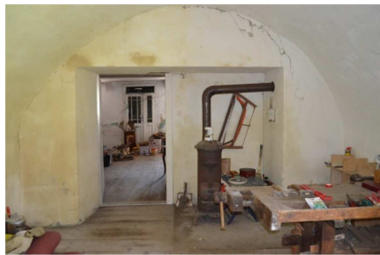
Abb. A.0.05.2 Zimmer, Blick zu Raum A.0.04 Zimmer (Eigenaufnahme vom 27.08.2016)
