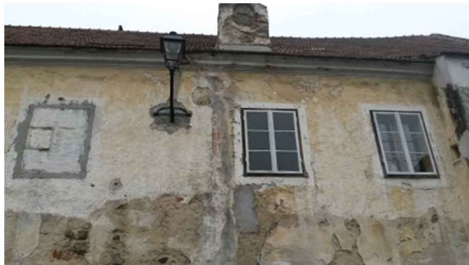
Abb. 3.9 (oben) Straßenfront, Fassadenausschnitt, Fenster der Räume A.1.03 und A.1.07 sowie zugemauertes Fenster im Bereich des Dachbodenaufganges (Eigenaufnahme vom 08.12.2015)
