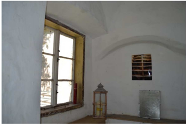
Abb. A.1.01.1 Stiegenhaus, Podest (Eigenaufnahme vom 27.08.2016)
