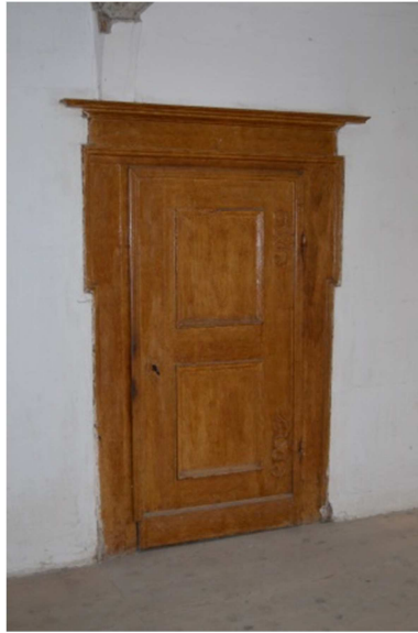
Abb. A.1.03.4 Zimmer, Detailaufnahme Tür aus der Renaissance mit originalen Beschlägen (Eigenaufnahme vom 08.12.2015)
