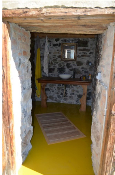
Abb. A.0.09.1 Bad, Zugang (Eigenaufnahme vom 27.08.2016)
