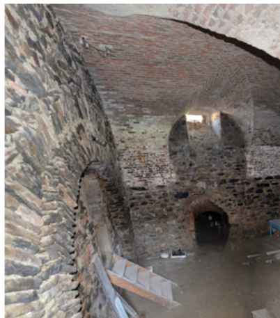
Abb. 3.5 (oben) Raum A.1.04 ehemalige Kapelle, gemauerte Wölbung der Kapellendecke mit Ornamentmotiv einer vergoldeten Eierstabbordüre in Prägestucktechnik
