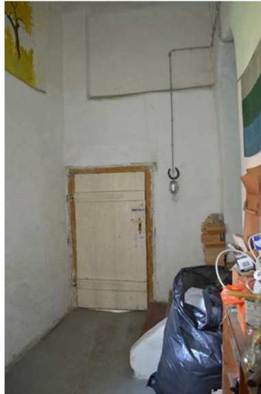
Abb. A.1.11.1 Vorraum, Blick zur Eingangstüre über die Freitreppe (Eigenaufnahme vom 27.08.2016)
