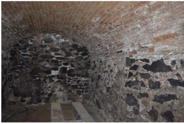
Abb. A.-2.01.1 Keller unter Straße, abgemauertes Kellerkompartment (Eigenaufnahme vom 08.12.2015)
