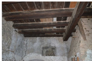
Abb. A.1.15.4 Zimmer, Blick zu Raum Raum A.1.14 Kammer bzw. nach oben hin zum Dachboden (Eigenaufnahme vom 27.08.2016)
