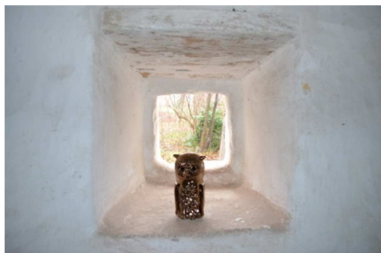
Abb. A.0.06.3 Stiegenhaus, Detailaufnahme Öffnung (Eigenaufnahme vom 08.12.2015 )
