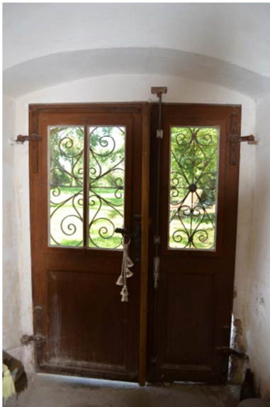
Abb. A.0.06.1 Stiegenhaus, Detailaufnahme Eingangstür zu Stiegenhaus (Eigenaufnahme vom 27.08.2016)
