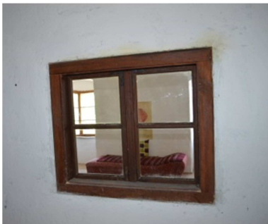
Abb. A.1.10.2 Gang, Detailaufnahme Fenster zu Raum A.1.09 Zimmer (Eigenaufnahme vom 27.08.2016)
