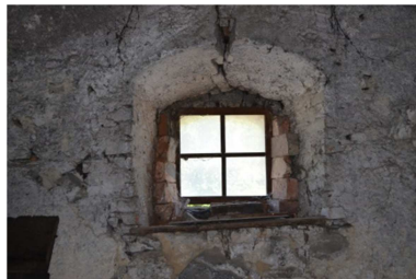
Abb. A.1.15.2 Zimmer, Detailaufnahme rechtes Fenster (Eigenaufnahme vom 27.08.2016)
