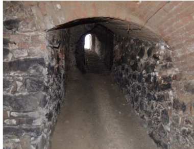
Abb. A.-1.03.2 Blick vom Keller unter der Straße in die beiden Kellerabgänge (Eigenaufnahme vom 08.12.2015)
