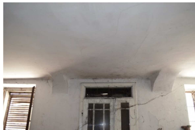
Abb. A.0.04.2 Zimmer, Detailaufnahme Auflager für straßenseitigen Flacherker (Eigenaufnahme vom 27.08.2016)
