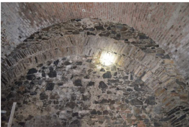
Abb. A.-1.02.3 Kellerhalle, Bruchsteinmauerwerk zu den übereinanderliegenden Kellerräumen (A.- 1.04 und A.-2.02) Eigenaufnahme vom 08.12.2015)
