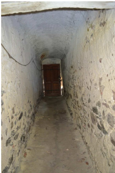
Abb. A.0.01.1 Zugang Straße, Blick zur Eingangstür straßenseitig (Eigenaufnahme vom 27.08.2016)
