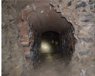
Abb. A.-1.03.1 Abgang zum Keller unter der Straße vom Raum A.-1.02 Kellerhalle (Eigenaufnahme vom 08.12.2015)
