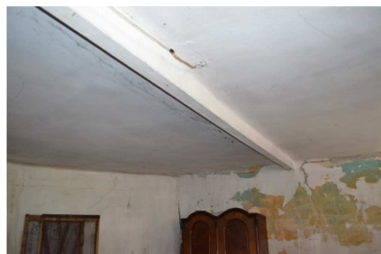
Abb. A.0.04.4 Zimmer, Detailaufnahme Flachdecke mit Metallunterzug (Eigenaufnahme vom 27.08.2016)
