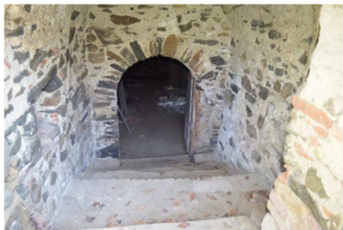
Abb. A.0.10.2 Zugang Keller, Stiegenabgang (Eigenaufnahme vom 27.08.2016)
