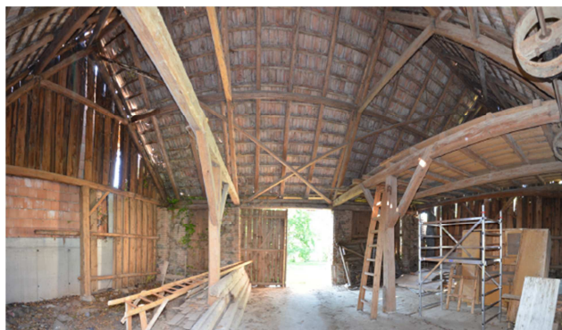
Abb. C.0.01.3 (unten) Querscheune, Innenraum, Blick in den Garten (Panorama erstellt von Eigenaufnahmen vom 27.08.2016)
