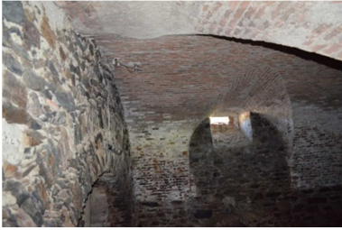
Abb. A.-1.02.1 Kellerhalle, Stichkappentonne aus Ziegeln (Eigenaufnahme vom 27.08.2016)
