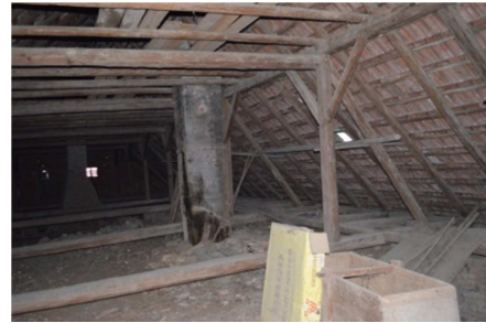
Abb. A.2.01.3 Dachboden, Blick nach Nord-Westen (Eigenaufnahme vom 08.12.2015)
