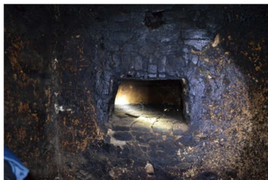
Abb. A.1.07.3 Rauchküche, Brotbackofen (Eigenaufnahme vom 27.08.2016)
