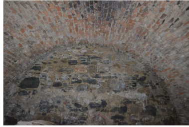
Abb. A.-2.02.1 Keller unter Keller, Tonnengewölbe (Eigenaufnahme vom 08.12.2015)
