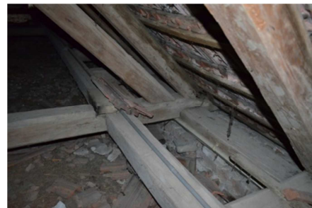
Abb. A.2.01.5 Dachboden, Detailaufnahme Dachstuhl, Anschluss Strebe an Bundtram sowie Anschluss Bundtram an Mauer- bzw. Fußpfette (Eigenaufnahme vom 08.12.2015)
