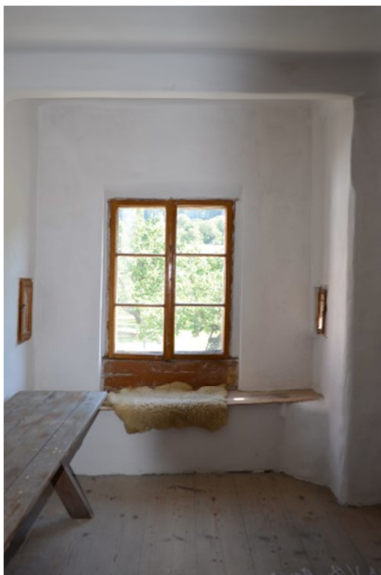
Abb. A.1.03.3 Zimmer, Detailaufnahme Flacherker mit seitlichen Spionfenstern (Eigenaufnahme vom 27.08.2016)
