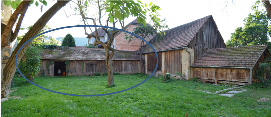
Abb. B.0.01.1 (oben) L-förmige Nebengebäude, links im Bild das Wirtschaftsgebäude aus Holz errichtet mit Pulldach (Panorama erstellt von Eigenaufnahmen vom 27.08.2016)
