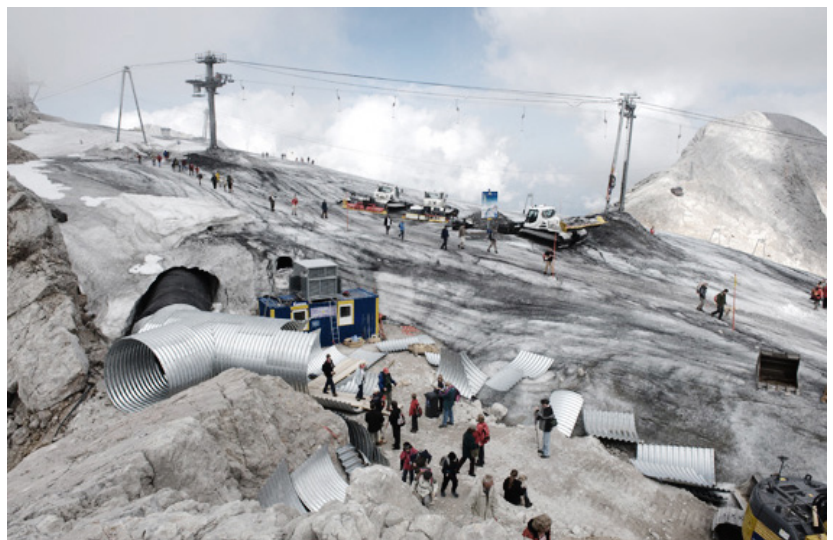
Abb. 47.: Die Liftanlage und der Eingang zum Eispalast im Sommer
