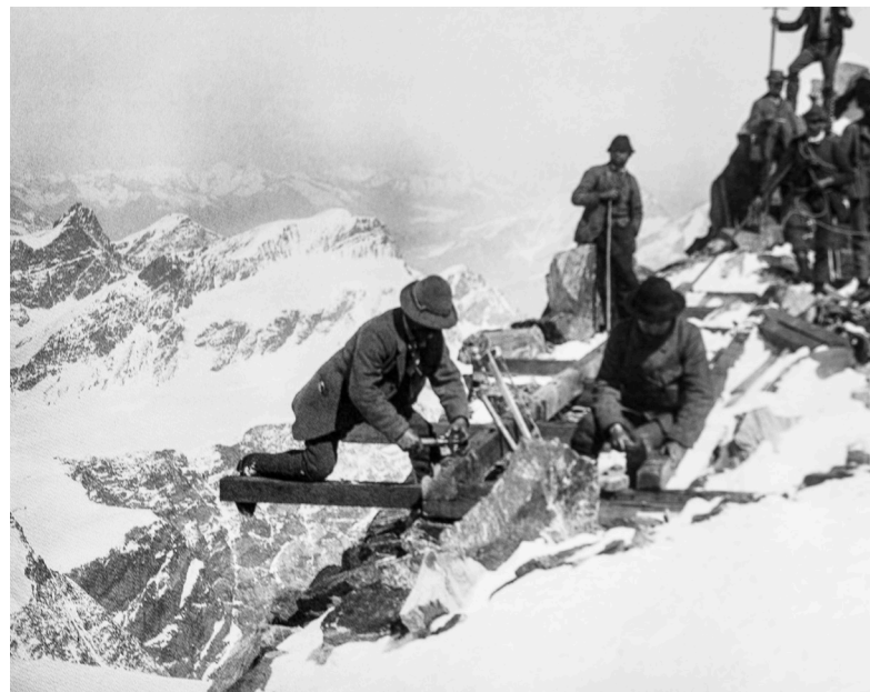
Abb. 11.: Der erste auf der Signalkuppe für die Capanna Margherita befestigte Balken, September 1892
