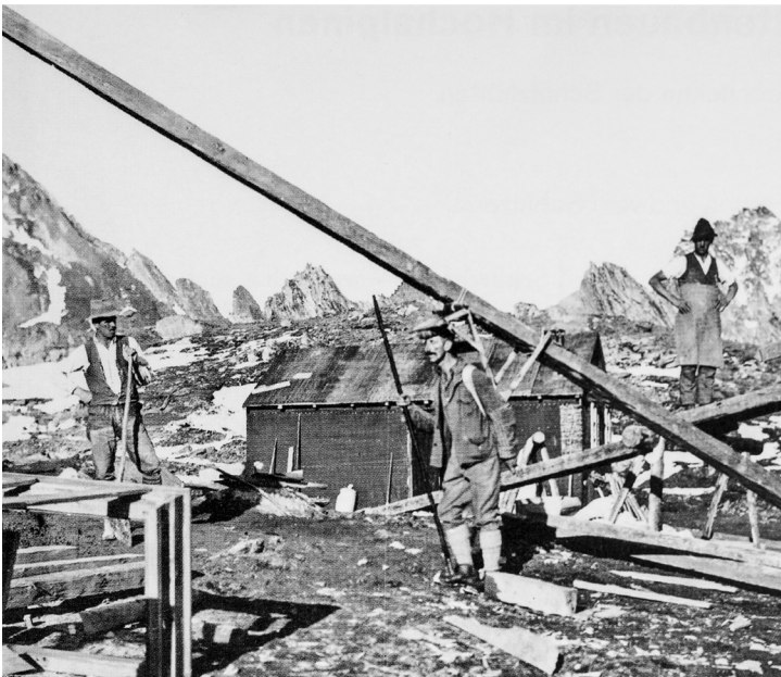
Abb. 9.: Firsträger beim Bau der Bonn-Matreier Hütte im Oktober 1931
