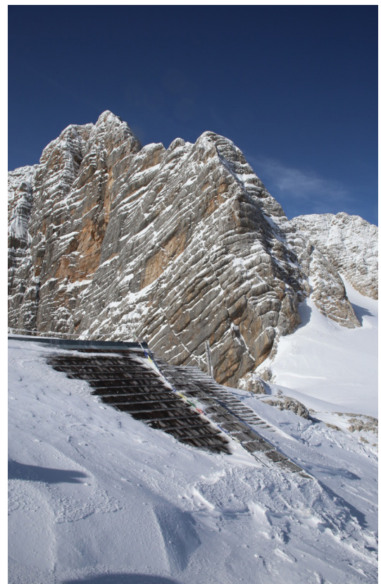
Abb. 66.: Blick auf den Dachstein, von der Hütte ist nur mehr der First zu sehen
