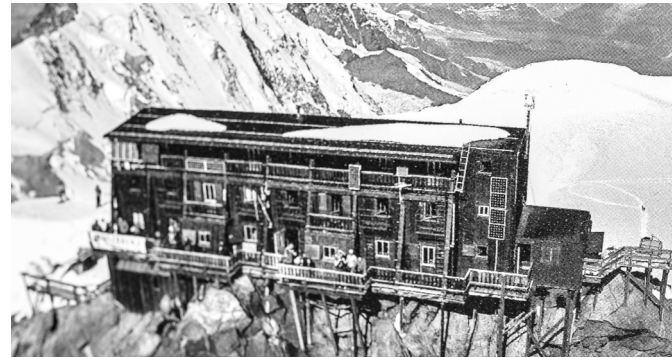
Abb. 26.: die neue „Capanna Regina Margherita“ auf der Signalkuppel im Monte-Rosa-Massiv
